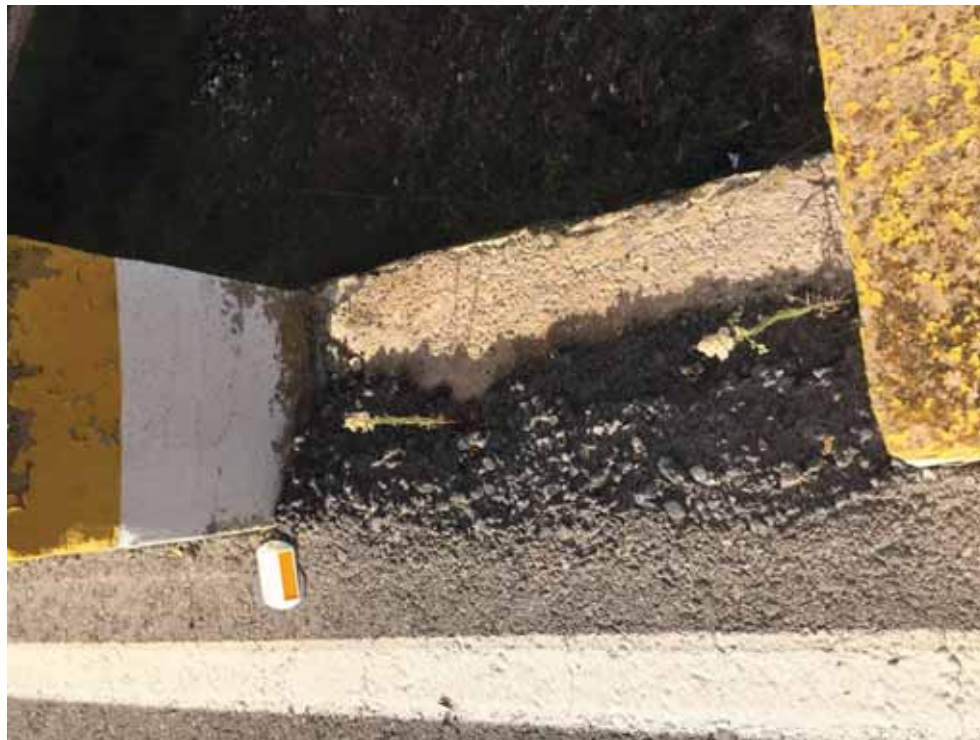
Imagen 08. Vista borde obra de fábrica
