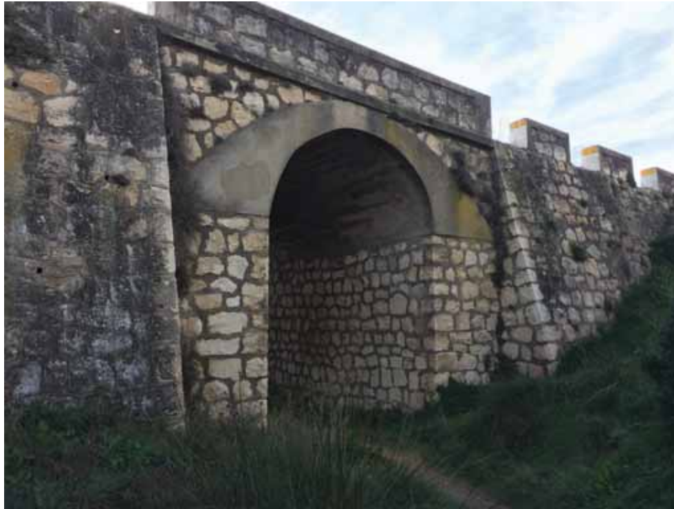
Imagen 01. Obra de fábrica. Alzado noroeste
