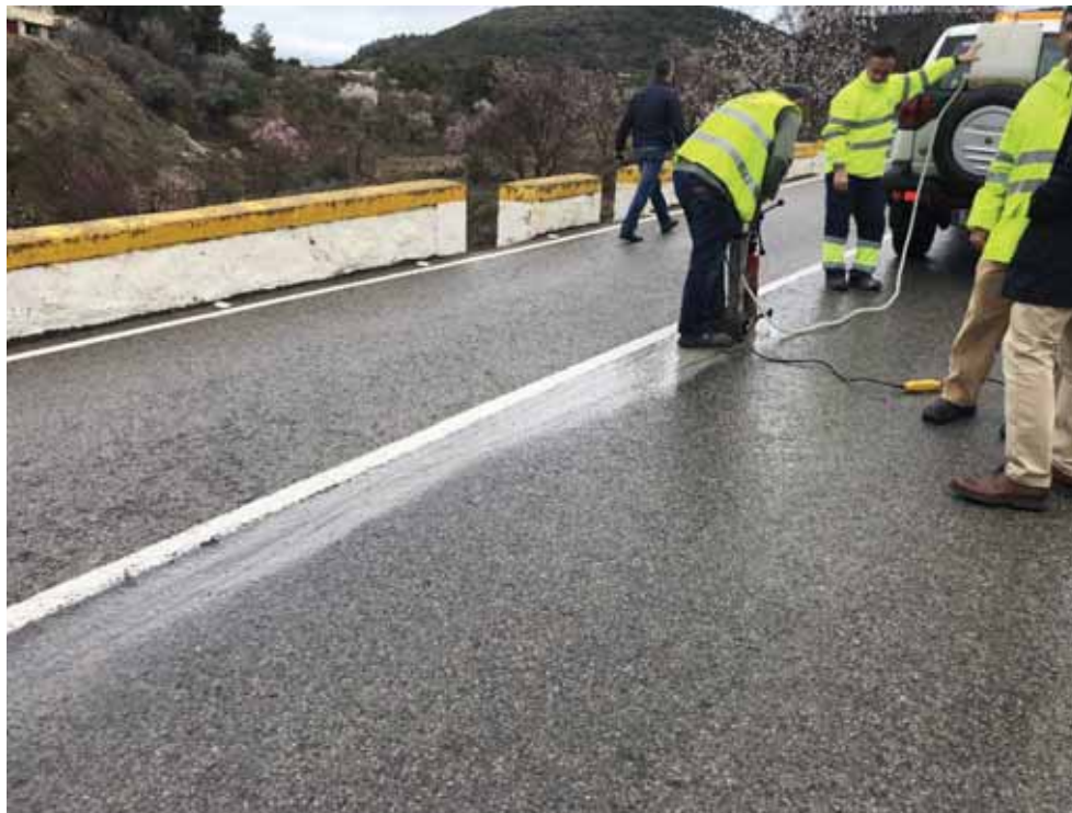
Imagen 3. Perforación del pavimento
