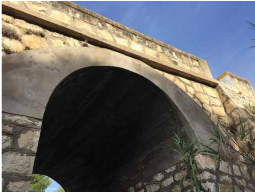
Imagen 02. Obra de fábrica. Alzado sudeste
