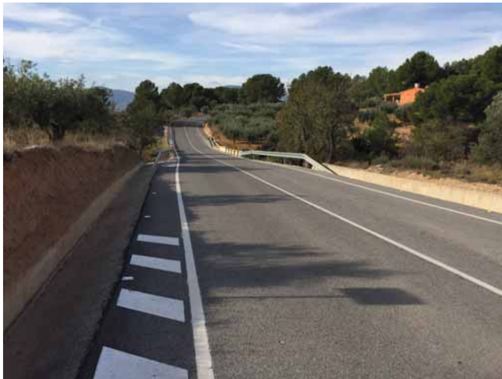
Imagen 06. Acceso obra de fábrica. Vista noreste
