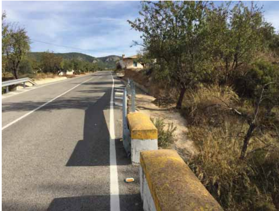
Imagen 07. Vista desde obra de fábrica hacia noreste
