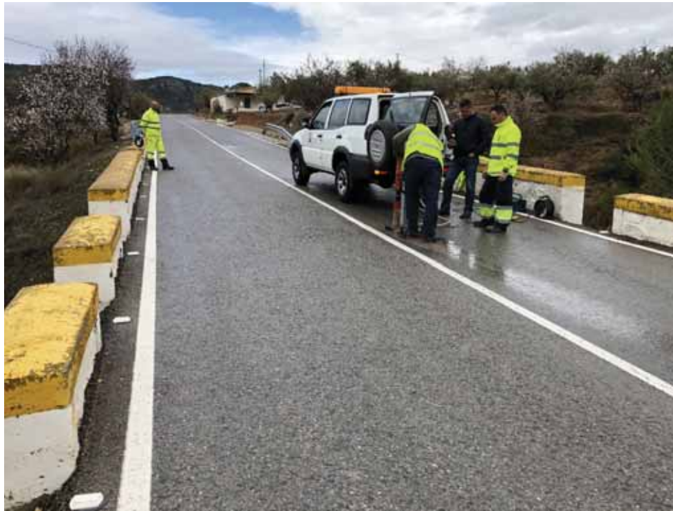
Imagen 4. Perforación del pavimento 2
