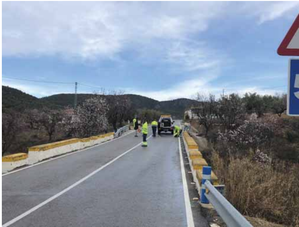
Imagen 2. Trabajos de ejecución de las catas
