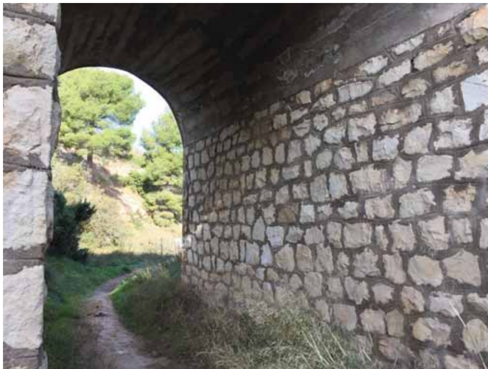
Imagen 04. Obra de fábrica. Vista interior
