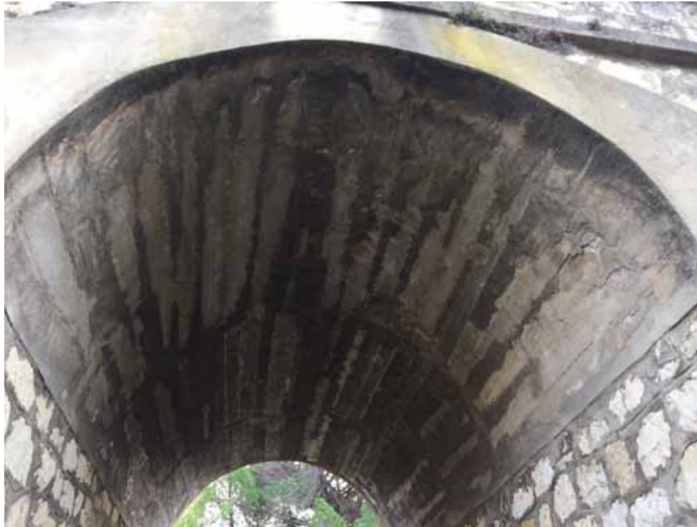
Imagen 05. Obra de fábrica. Vista interior arco
