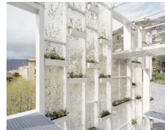
Detalle de revestimiento para fachada de chapa de acero compuesta por una malla ondulada.
