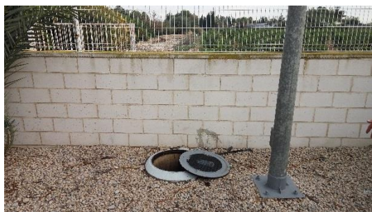
Pozo de registro del colector de salida en el recinto de la E.D.A.R.
