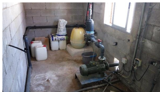
Instalación de riego existente. Toma desde el depósito, grupo de bombeo y filtro de anillas.
