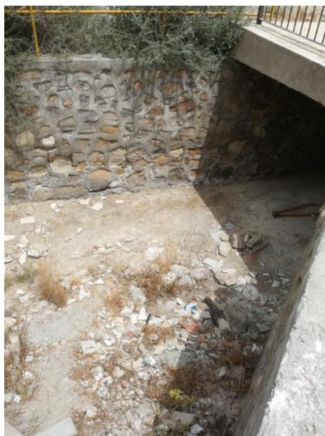
La actuación en este tramo, se limita a una limpieza y desbroce del cauce, la ejecución de solera de hormigón, arenero y muros de mampostería de acompañamiento del cauce.
