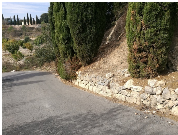
Fotografía 2. Camí de Benimarfull. Zona 1. Murete a reparar
