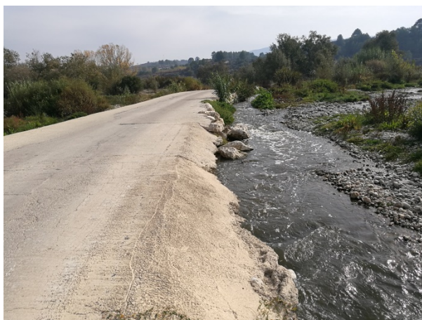
Fotografía 8. Camí de Benimarfull. Zona 3. Reposición de escollera y pavimentación de hormigón
