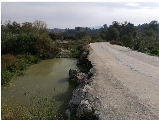
Fotografía 7. Camí de Benimarfull. Zona 3. Reposición de escollera y pavimentación de hormigón
