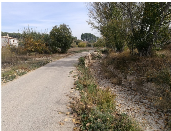
Fotografía 5. Camí Barranc del Mas. Zona 2. Zona donde se ejecutará escollera
