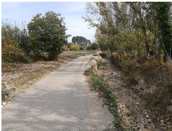
Fotografía 6. Camí Barranc del Mas. Zona 2. Zona donde se ejecutará escollera
