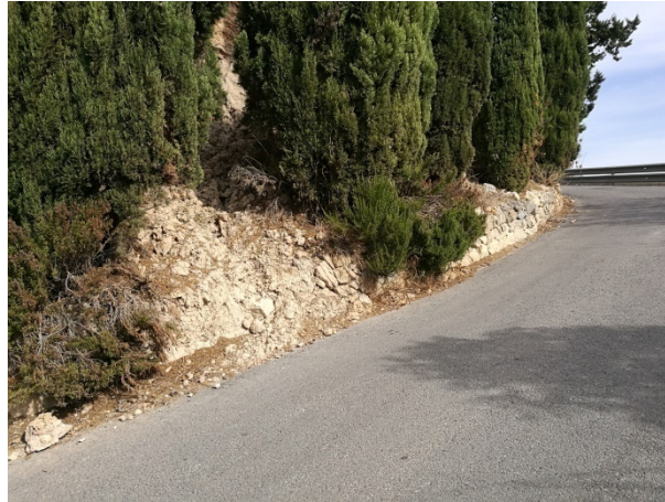
Fotografía 1. Camí de Benimarfull. Zona 1. Murete a reparar
