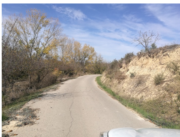
Fotografía 9. Camí Font del Moro. Tramo 1
