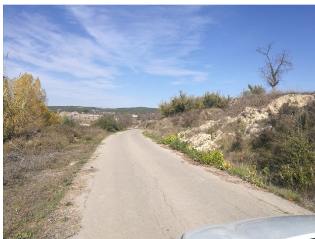
Fotografía 8. Camí Font del Moro. Tramo 1
