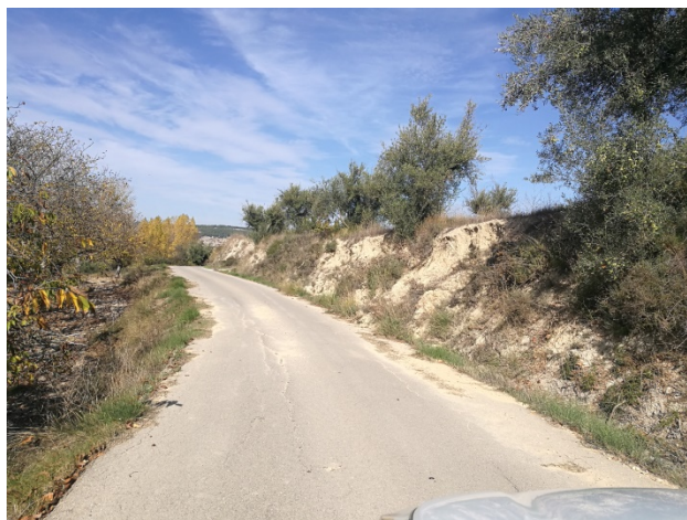
Fotografía 7. Camí Font del Moro. Tramo 1
