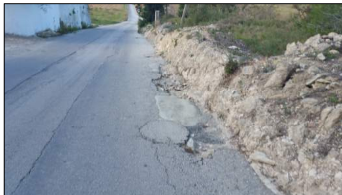
Imágenes representativas "Camino de la Torreta". Daños puntuales.
