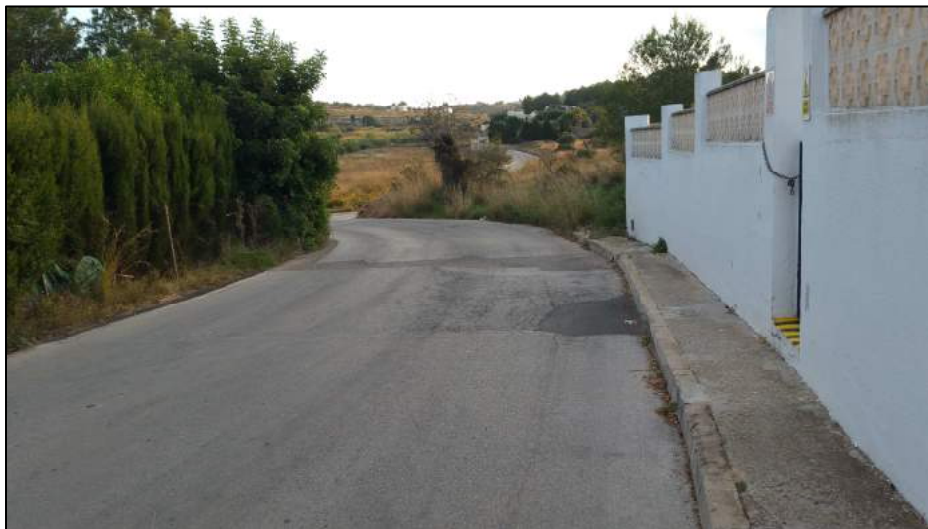
Estado del firme en accesos a Urbanización Les Fonts.
