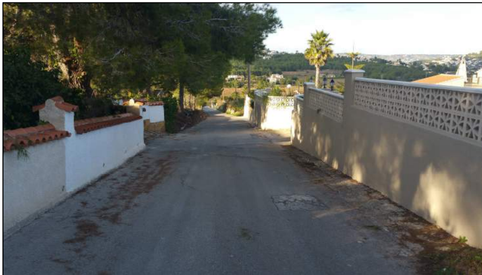
Imagen representativa "Camino Benicambres". Daños puntuales por raíces
