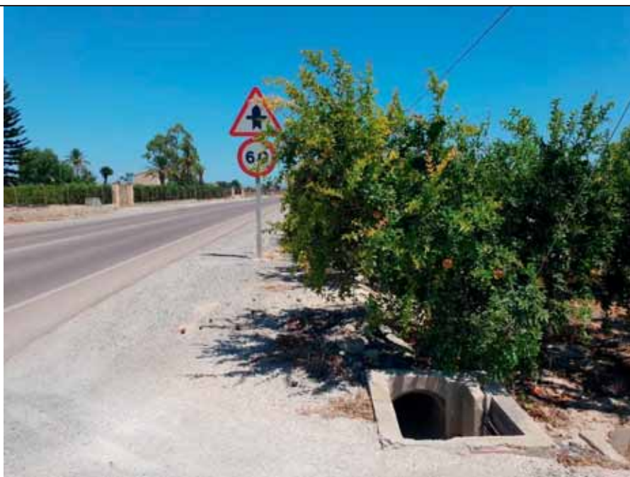
Pk 13+160, acequia de riego paralela a la CV-851
