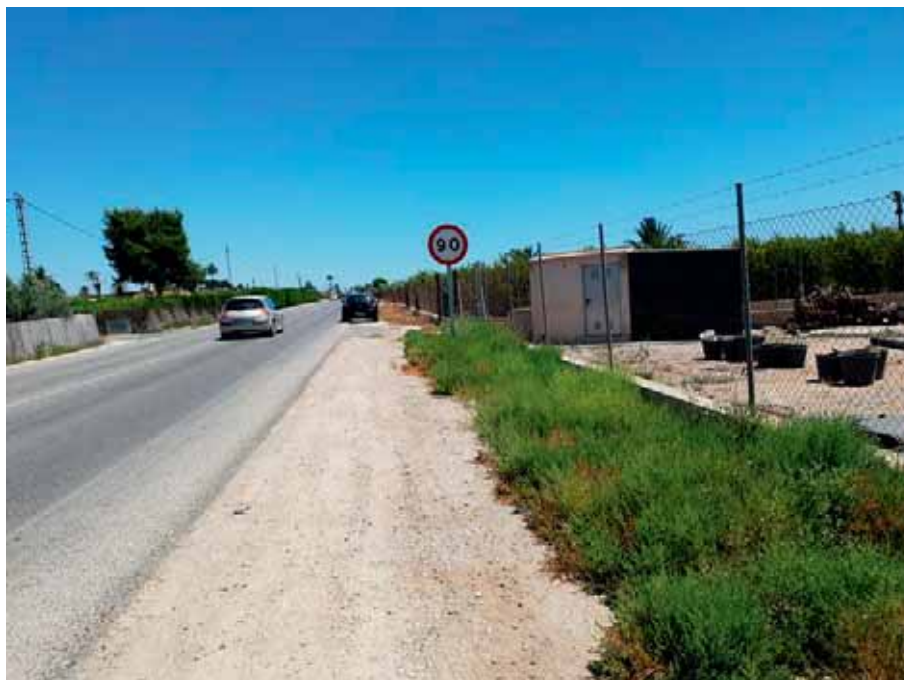
Zona de afección por donde discurrirá el carril bici . PK 11+660. Desbroce y cajeo para la formación de la explanada
