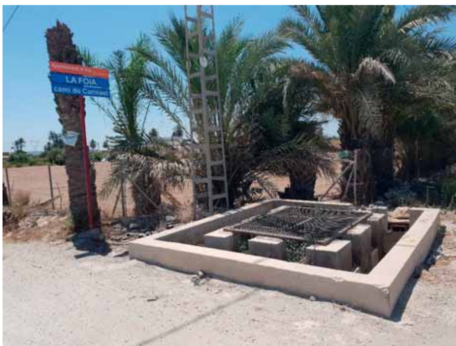
Pk 12+620, zona de retranqueo que no se ve afectada por la ejecución de las obras
