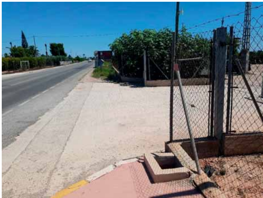
Entrada a una de las parcelas colindantes. Rebaje de acera para el cruce. Inicio de la actuación sobre asfalto
