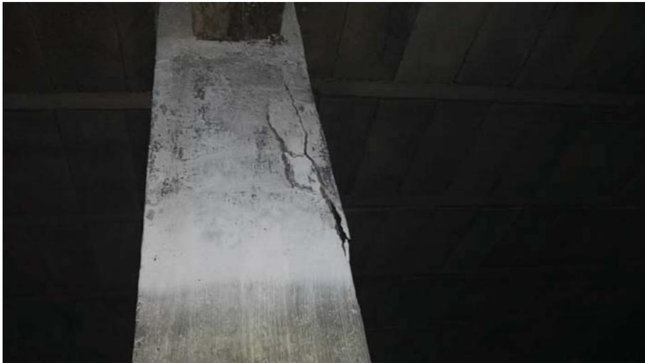
Grietas y pérdida de recubrimiento en pilares. Pérdida del hormigón del recubrimiento de la armadura que la ha dejado a la vista y oxidación.
