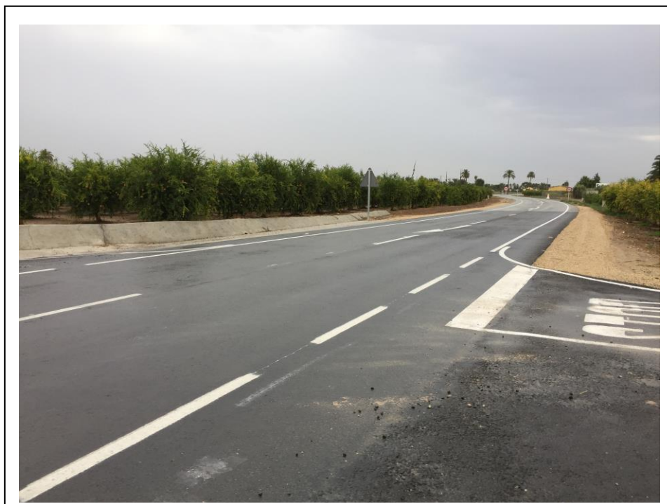
Foto 4: Cruce de la carretera con camino rural en PK 7+850
