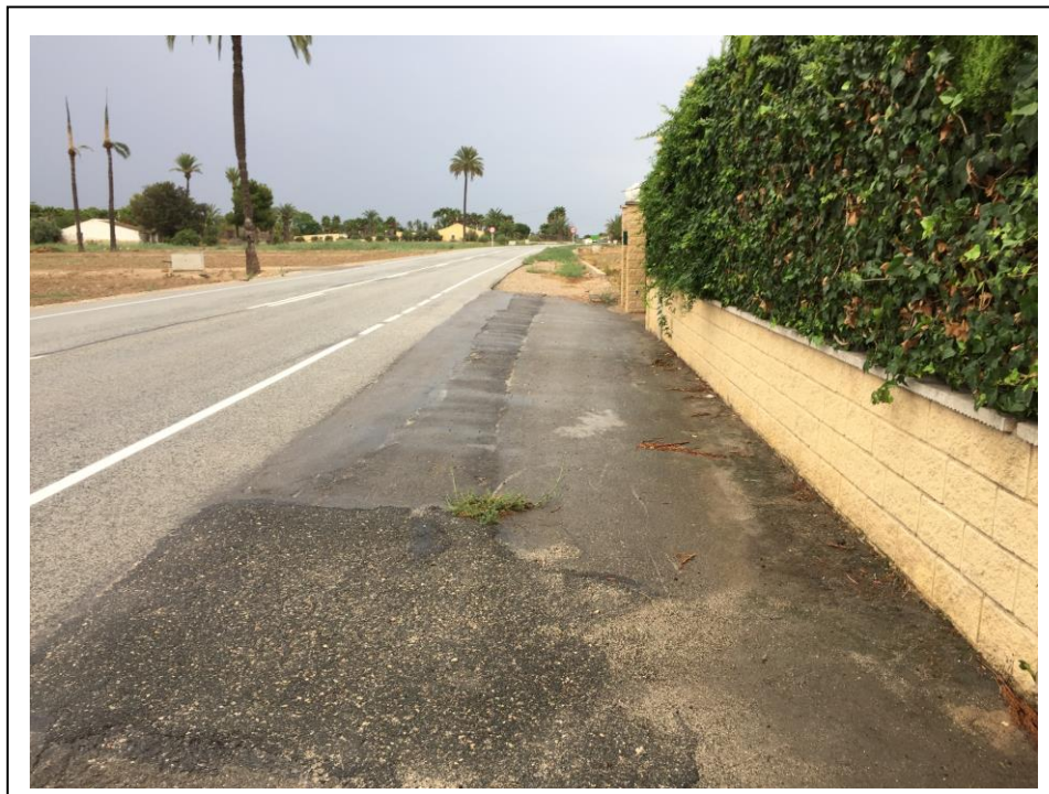
Foto 13: Tramo del margen afectado por las obras con aglomerado asfáltico en el PK 8+160
