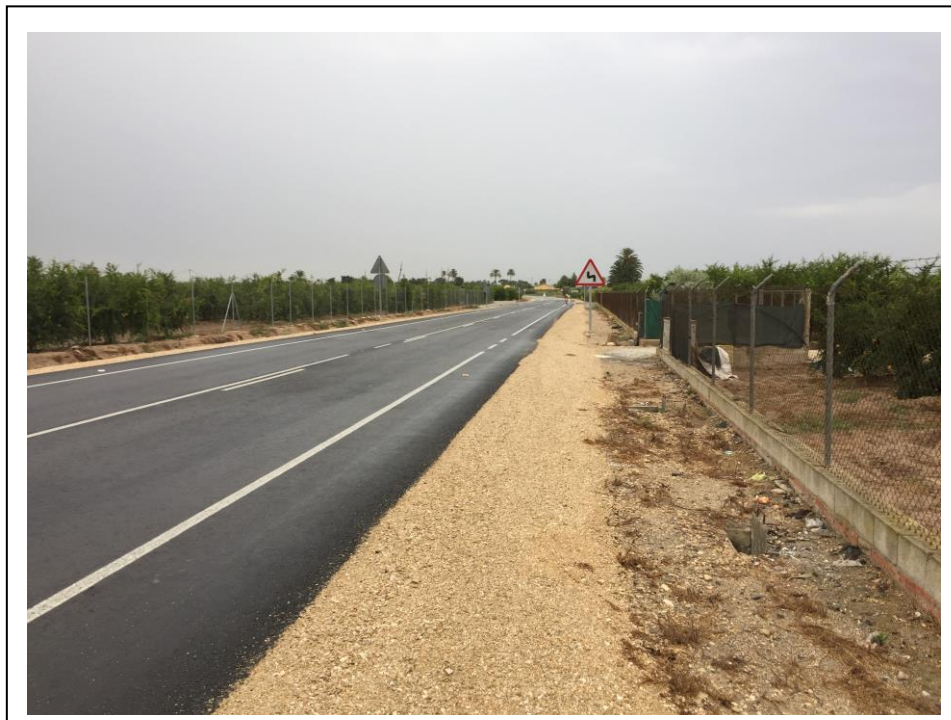
Foto 3: Margen de la CV-851 en el PK 7+730
