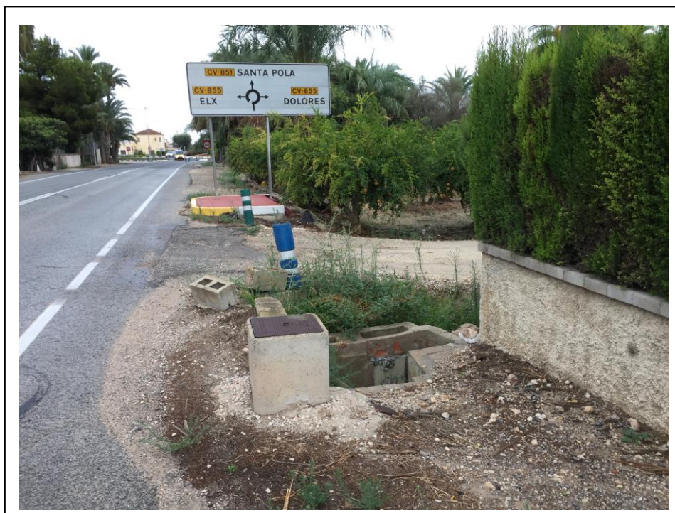
Foto 27: Vista del tramo de actuación situada en el PK 9+100, en donde se sitúa una arqueta de riego de grandes dimensiones a acondicionar y cartel informativo del cruce.
