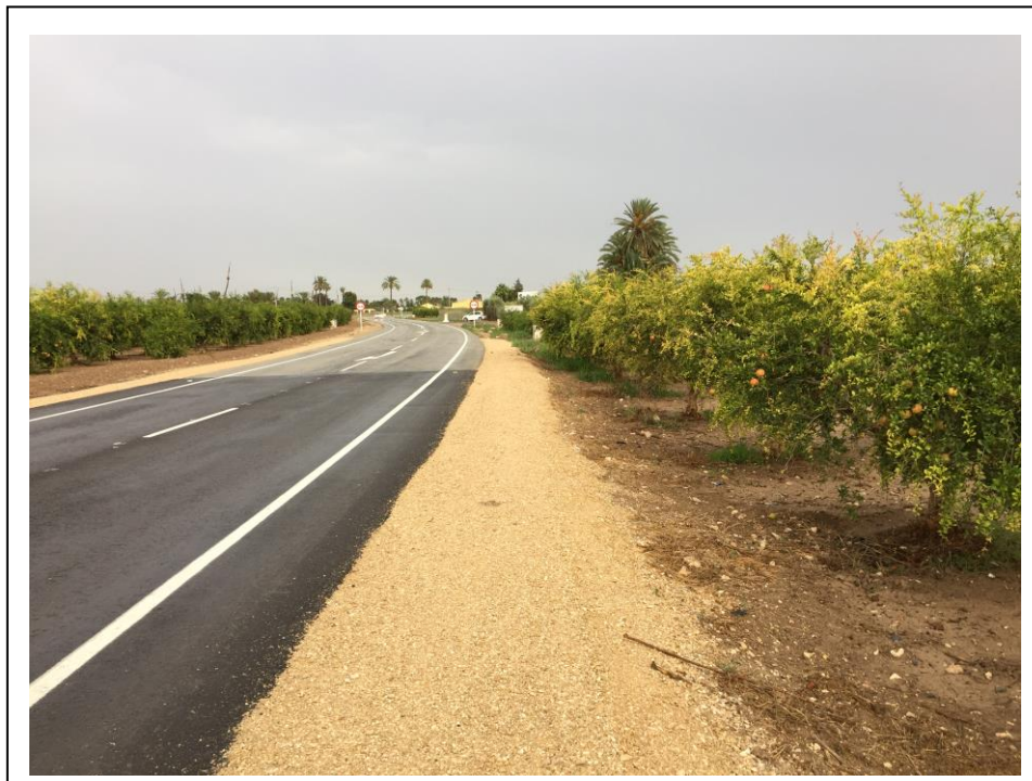
Foto 5: Vista del tramo donde se inicia la actuación en calzada, PK 7+870
