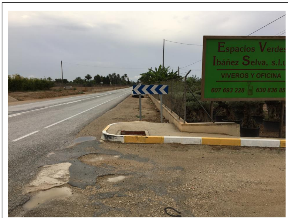
Foto 18: Firme hormigón con arqueta de riego en el PK 8+480
