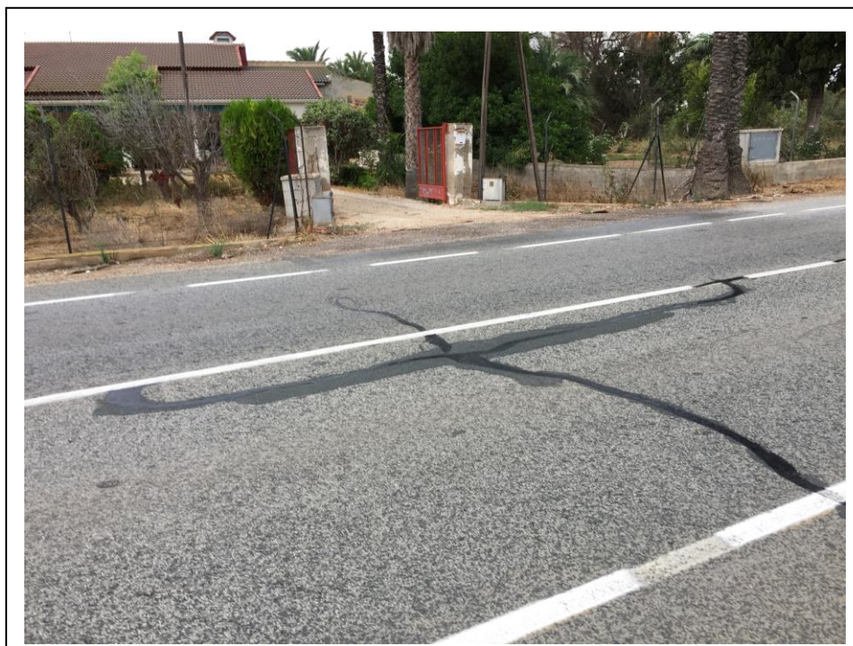
Foto 26: Estado actual de la calzada a reasfaltar con fisuras reparadas.
