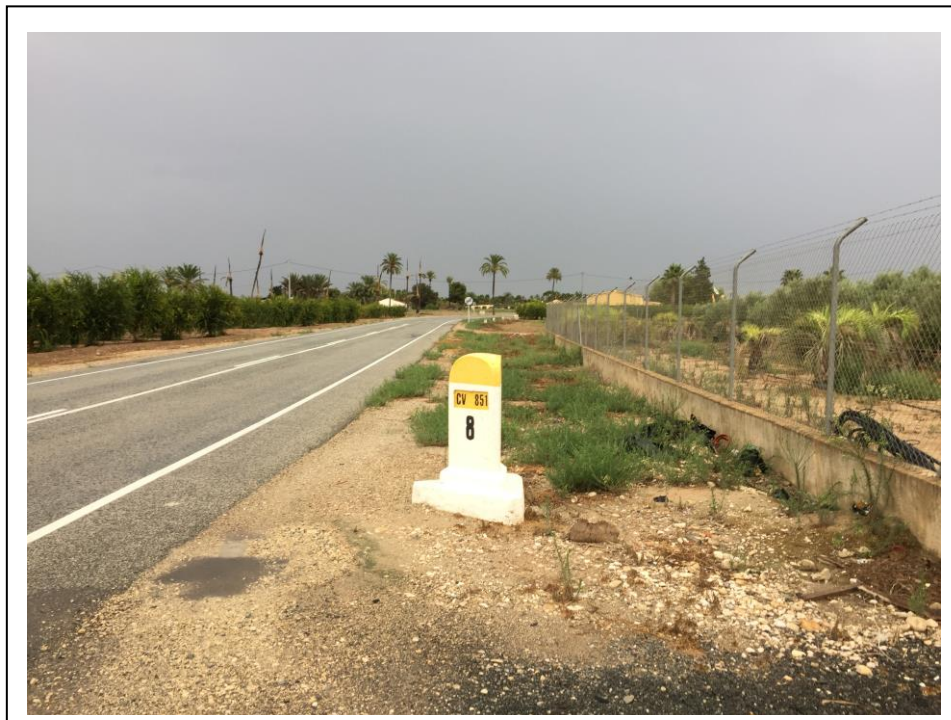
Foto 9: Estado actual del margen a afectar en el PK 8+000
