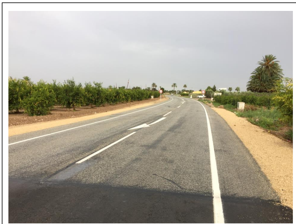
Foto 6: Detalle de la transición entre pavimentos
