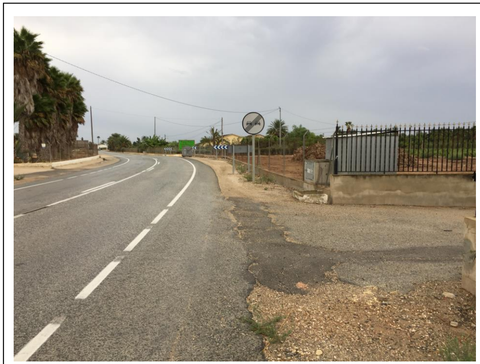
Foto 17: Acceso a parcela en el PK 8+410
