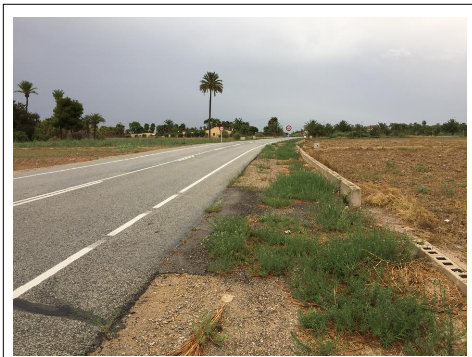
Foto 14: Otra vista del margen de actuación en el PK 8+250
