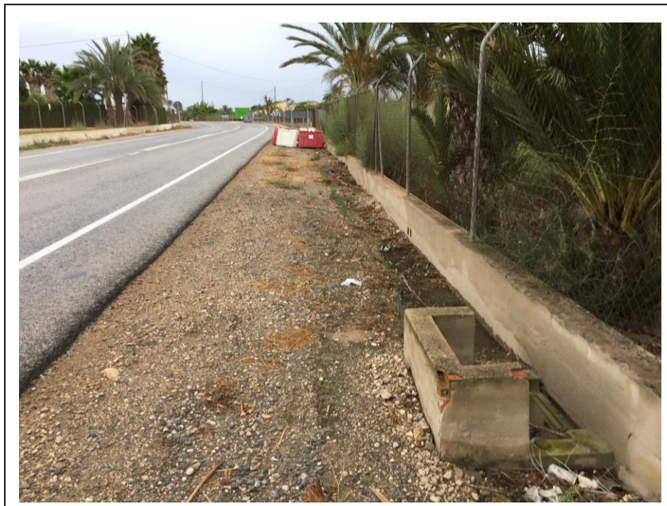
Foto 15: Vista de una arqueta de la red de riego existente en la zona del PK 8+370
