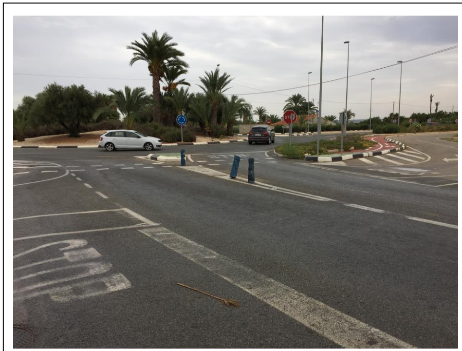
Foto 31: Tramo final de la CV-851 afectada por las obras, con el carril bici existente al que se conecta.
