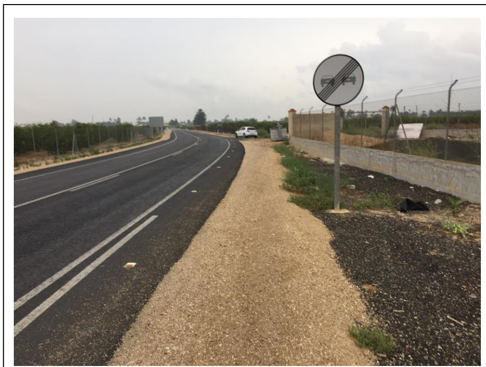
Foto 2: Estado actual de CV-851 en el PK 7+670 en donde no se prevé el reasfaltado. Margen por donde se ejecutará el itinerario ciclista.
