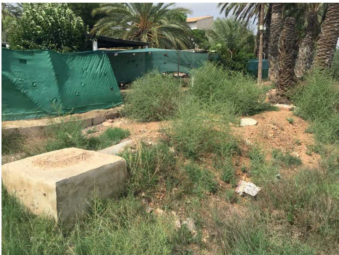
Cerramiento e instalación de riego afectados por la ampliación de la plataforma
