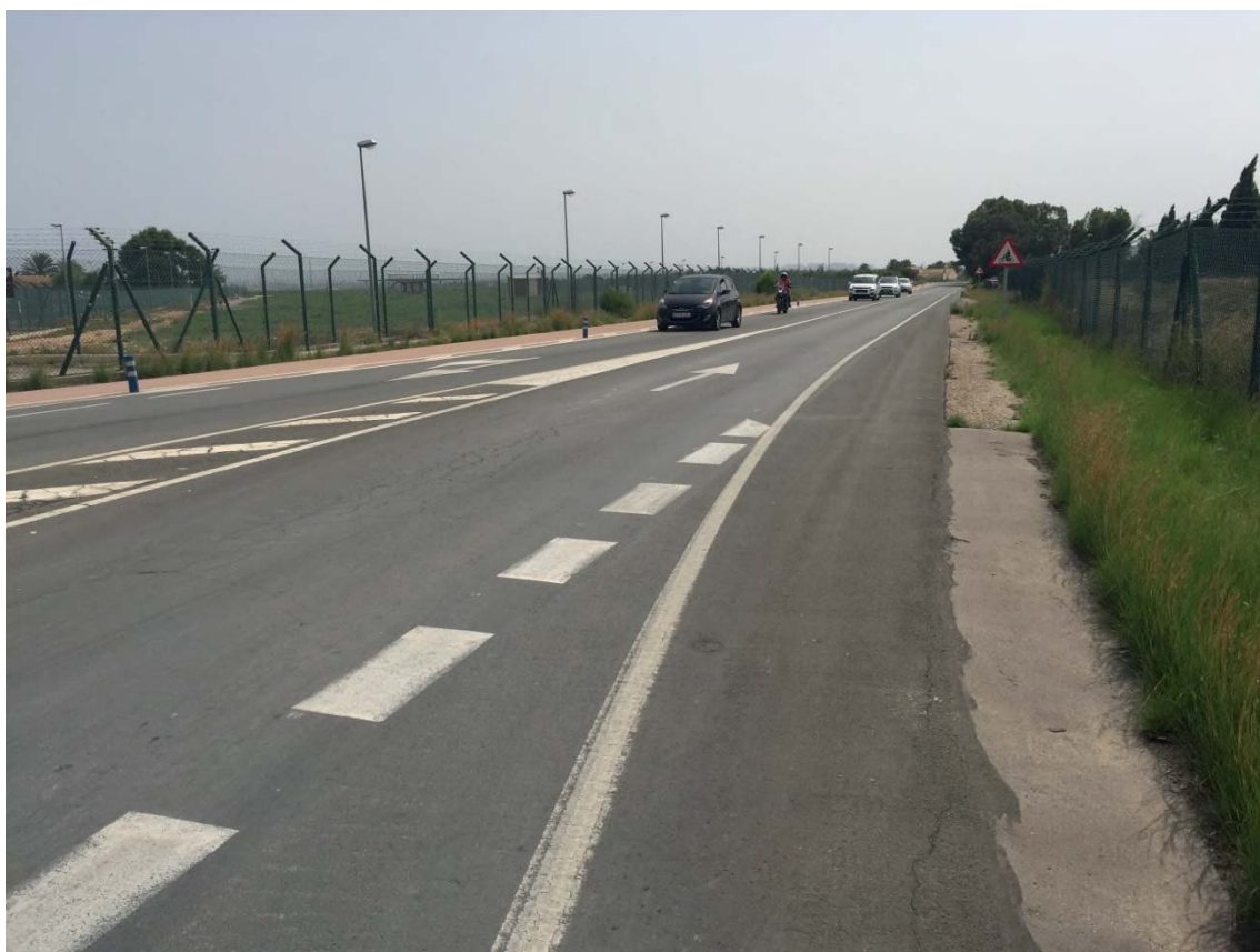
Tramo intersección – El Altet
