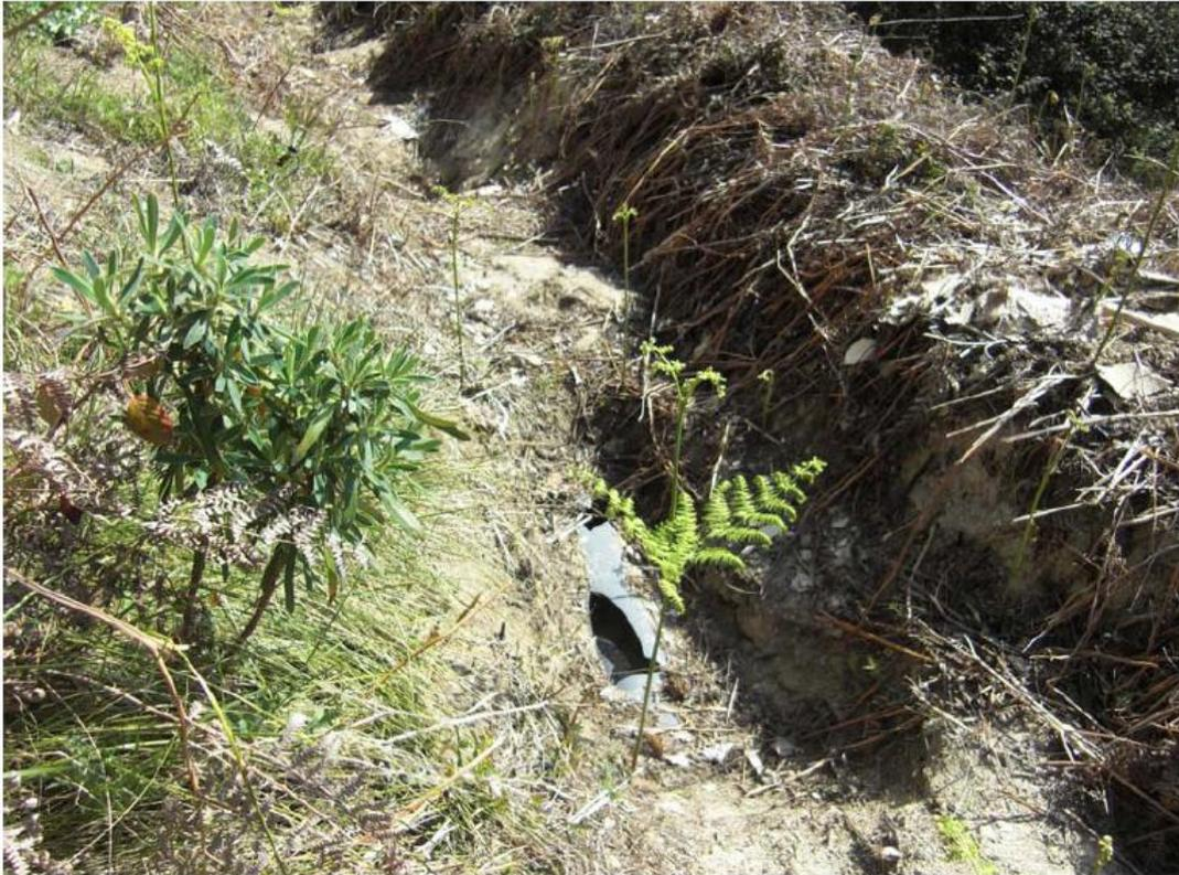
*Imagen 7: Catas y rotura para desatascar tubería*
