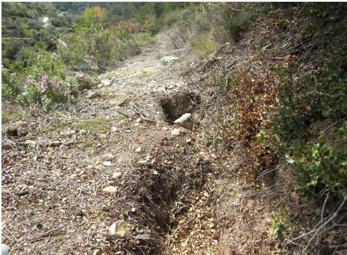
*Imagen 4: Catas para desatascar tubería*
