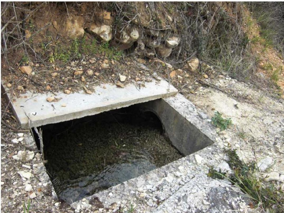
*Imagen 2: Partidor. Se observa como las algas obstruyen y penetran en la tubería*
