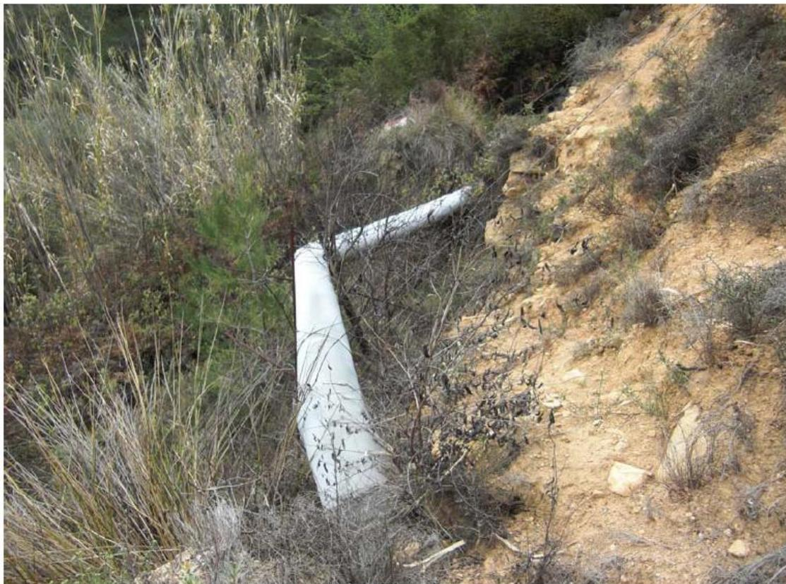
*Imagen 10: Tramo de tubería descolgada*
