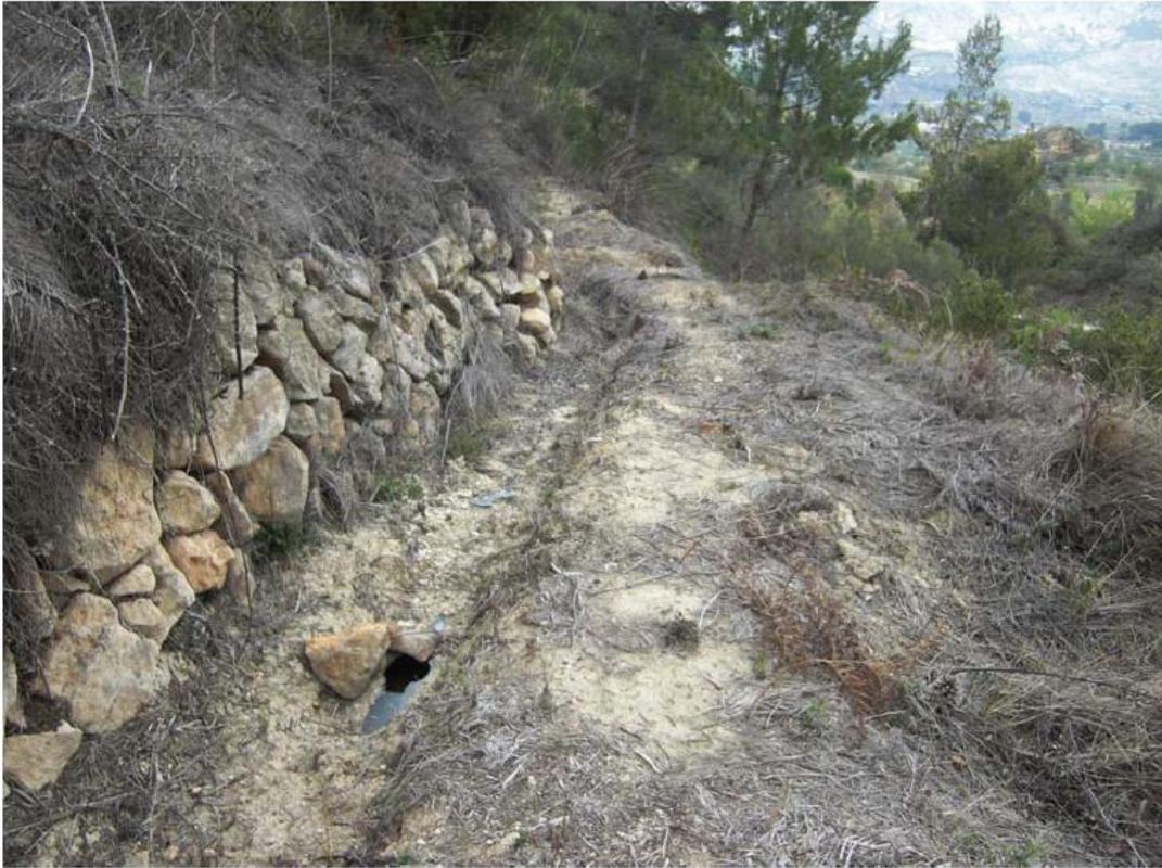
*Imagen 1: Catas y rotura para desatascar tubería*
