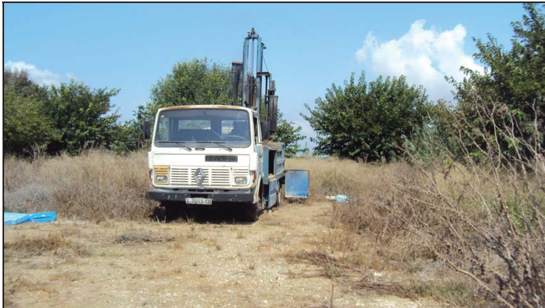
Fotografía 4: Vista del emplazamiento del sondeo 2.
