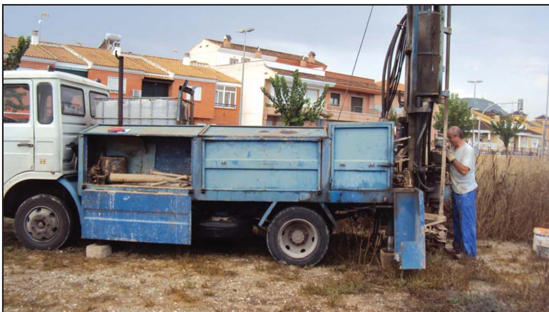
Fotografía 3: Vista de trabajos en el sondeo 1.
