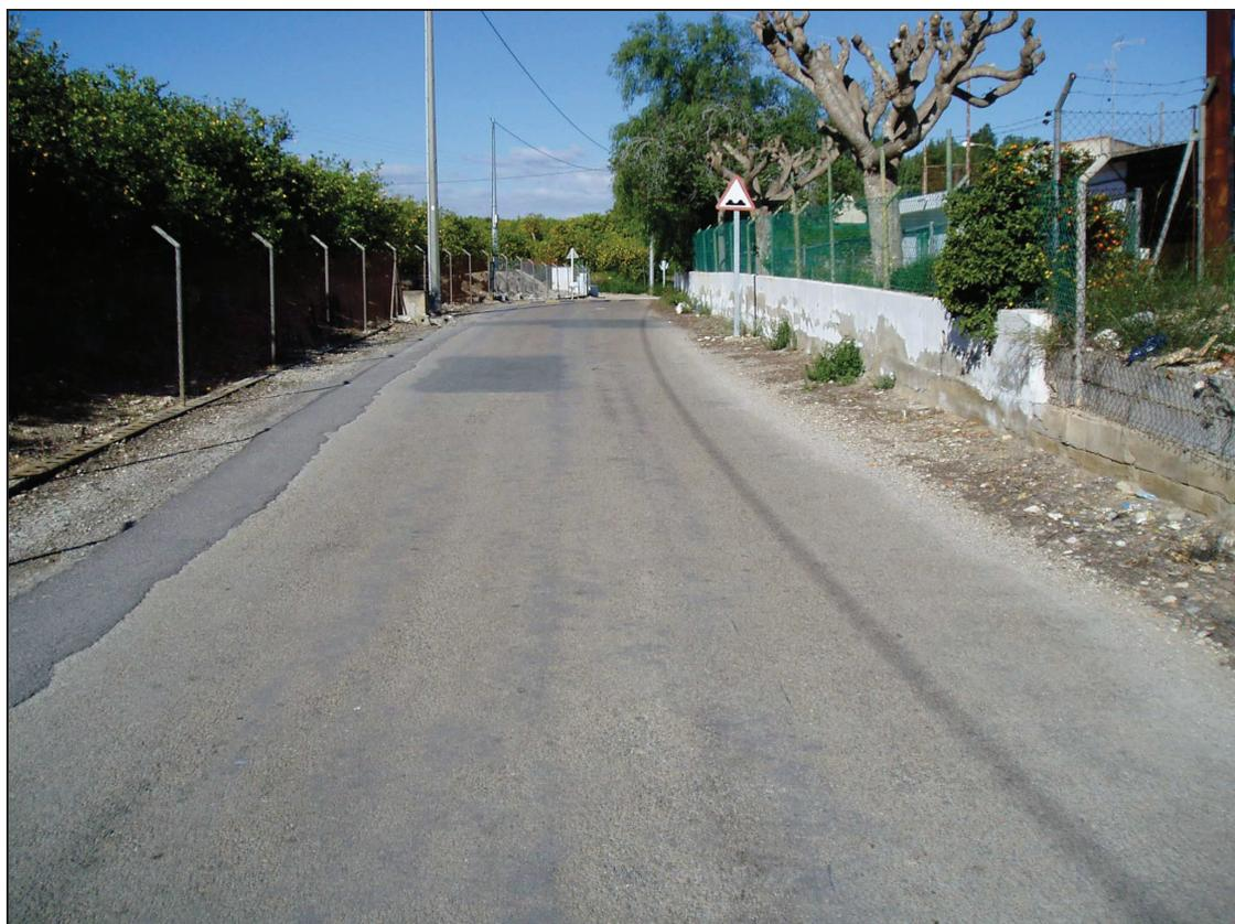
**Fotografía n°8:** Existe un reductor de velocidad que se deberá retirar y reponer tras la extensión de la nueva capa de rodadura de 5 cms de espesor.
