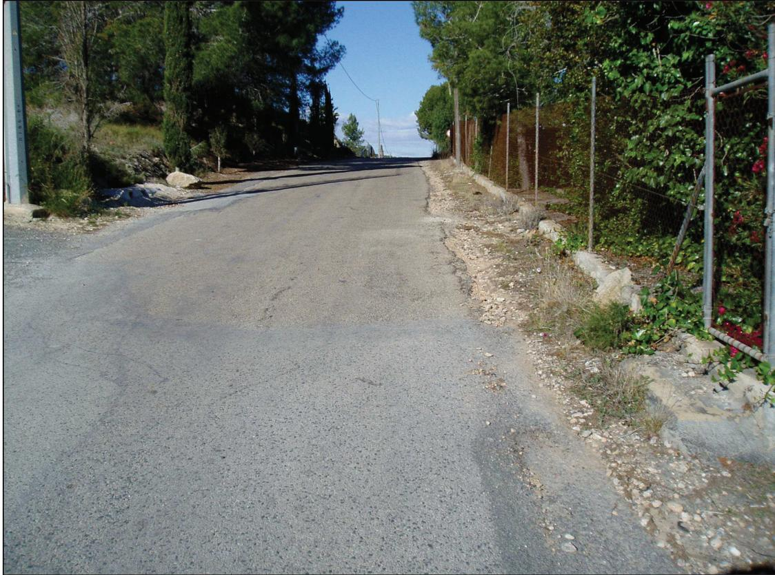
**Fotografía nº5:** En el siguiente tramo, de 5,50 mts de ancho, el agua ha erosionado el lateral, por lo que se saneará y reforzará con hormigón HM-20 previo al asfaltado.
