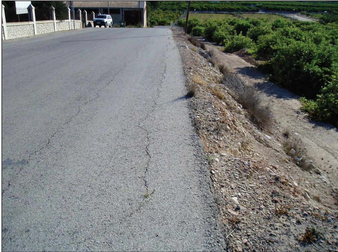
**Fotografía nº3:** El camino en esta zona discurre junto a un talud, que ha provocado la fisuración del pavimento.
