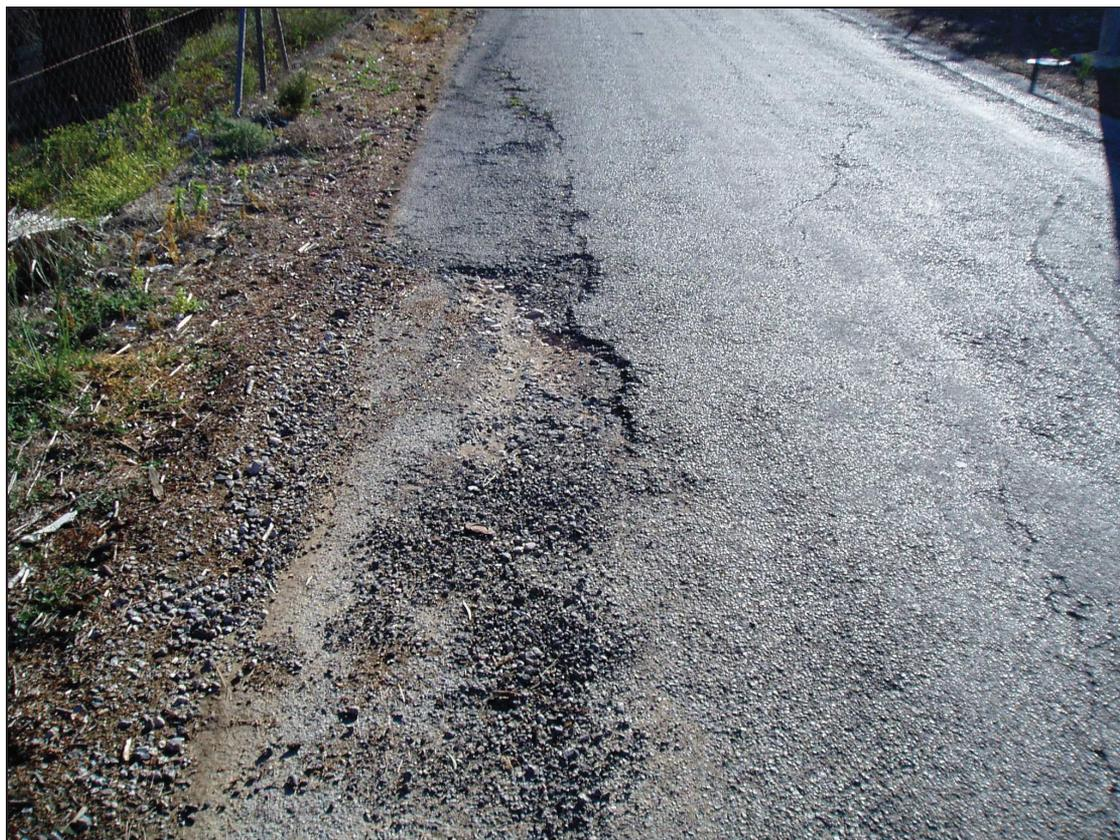
**Fotografía n°7:** La presencia de zonas donde se ha perdido el asfalto obligará a realizar un bacheo inicial con aglomerado previo a la extensión de la nueva capa.
