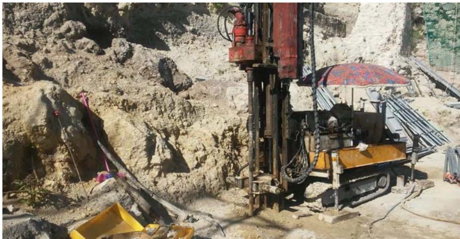
Fotografía 5: Vista de la sonda durante la realización del Sondeo S-2.
