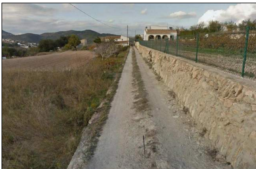
Imagen representativa estado actual Tramo-2
