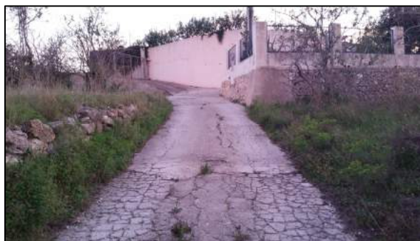
Imágenes representativas del mal estado del firme en Tramo-1
