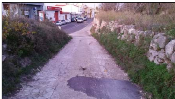
Imágenes representativas del mal estado del firme en Tramo-1
