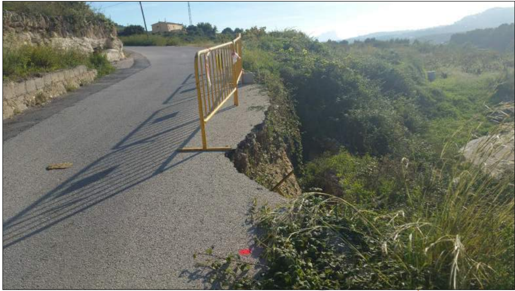
Panorámica estado actual. Grieta en firme y desprendimiento de talud
