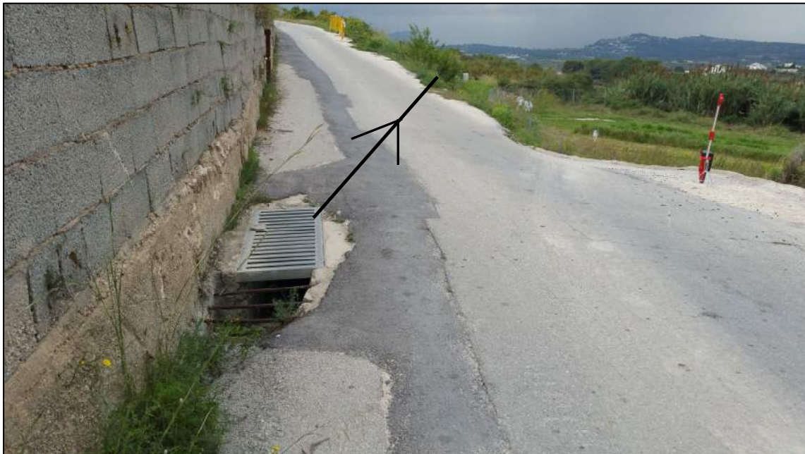
Imbornal y desagüe existente a pie de terraplén.
