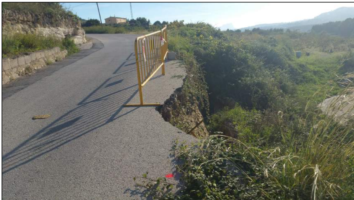
Rotura de firme Camino La Torra y deslizamiento de talud.
