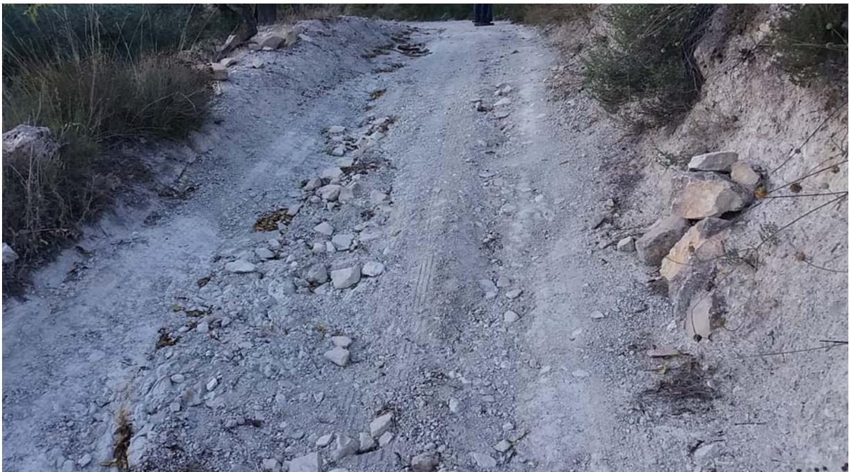
Vistas de los tramos cortos donde se aprecia que el camino actual es un mero cajeadado sobre terreno pedregoso, y cómo la acumulación del material excavado canaliza las aguas pluviales que erosionan el camino.
