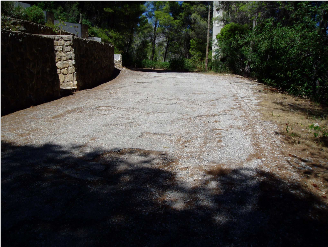
Fotografía nº9: La acción del agua ha dejado la plataforma descarnada y con arrastres.
