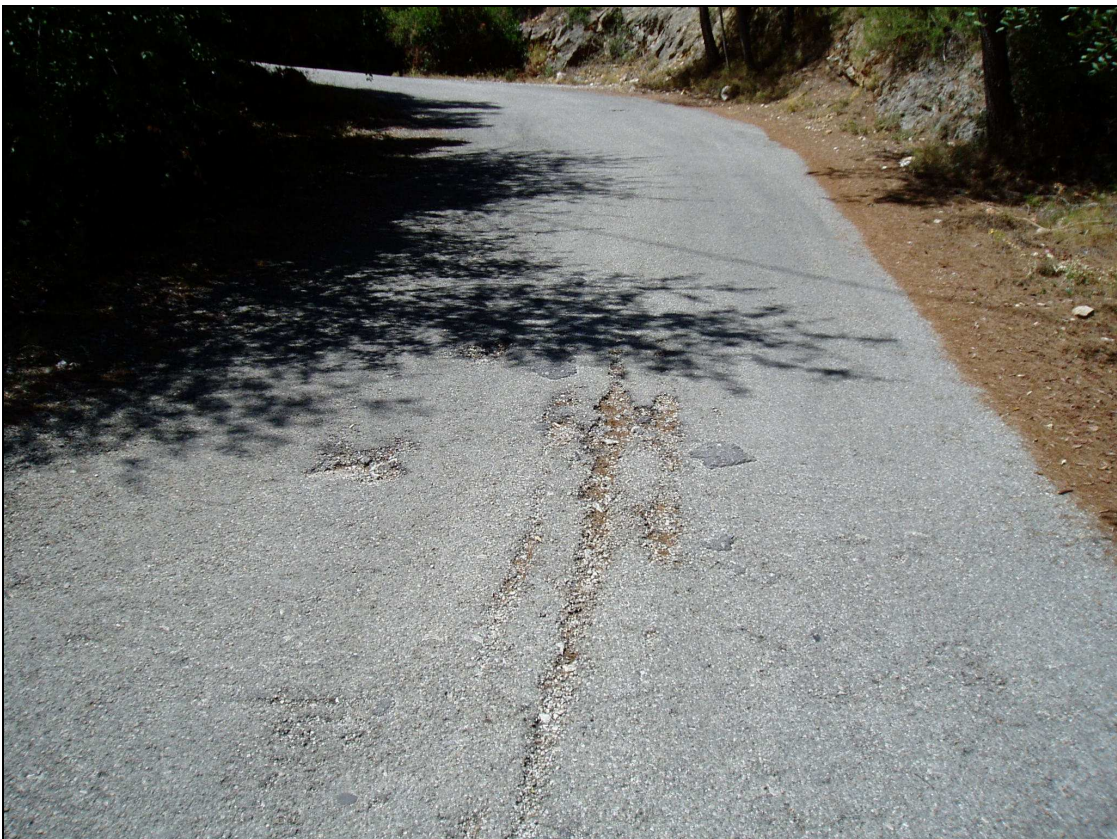
Fotografía nº2: El ramal izquierdo presenta un mejor estado y los bacheos son más localizados.
