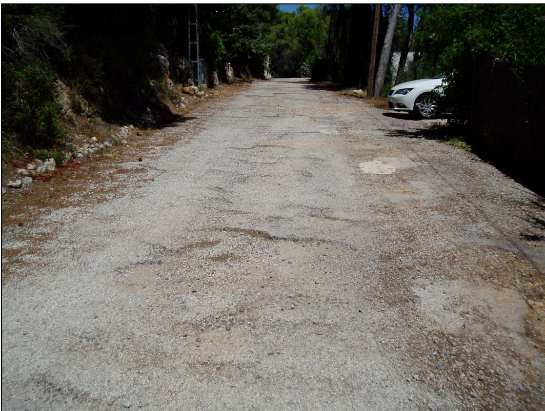
Fotografía nº6: A partir del primer chalet, el camino se presenta muy deteriorado.
