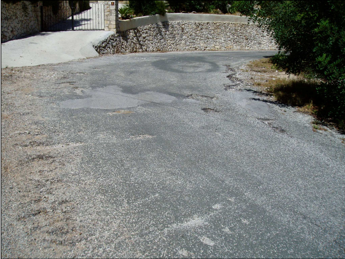
Fotografía nº3: La fuerte pendiente provoca los descarnados en el aglomerado provocados por el agua de lluvia.
