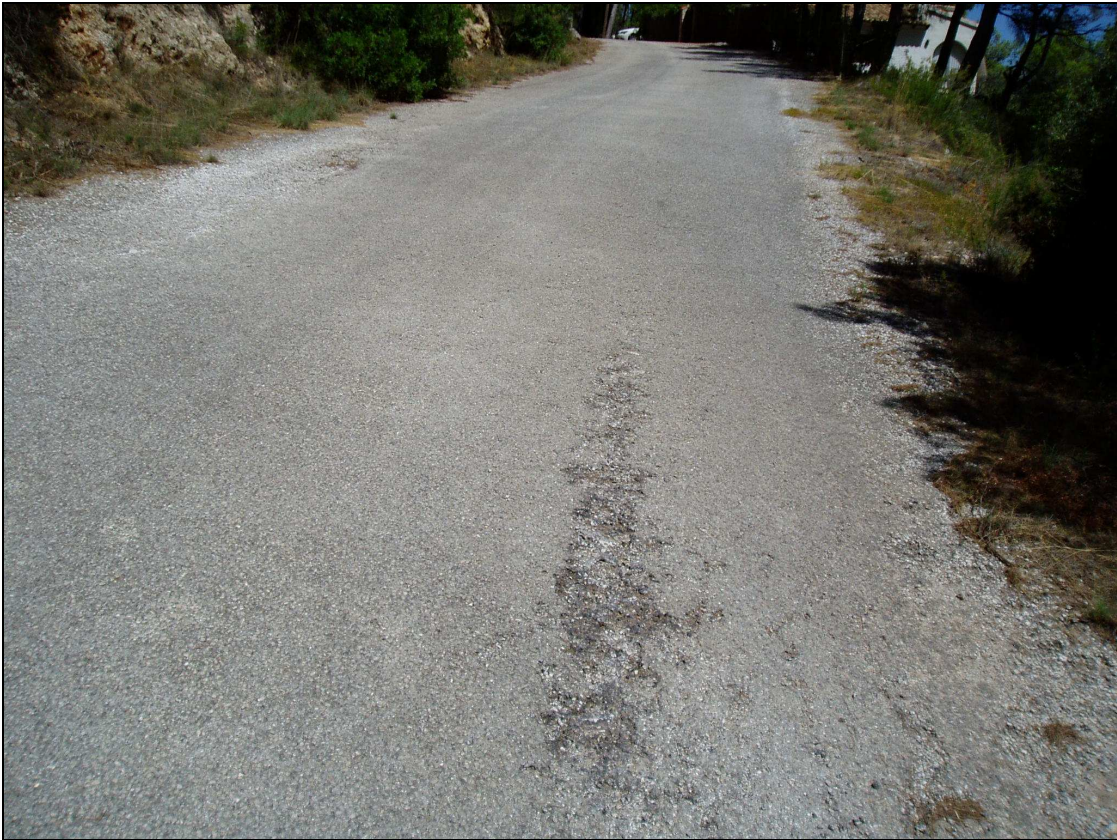
Fotografía nº5: El ramal derecho en su primer tramo precisa de bacheos localizados.
