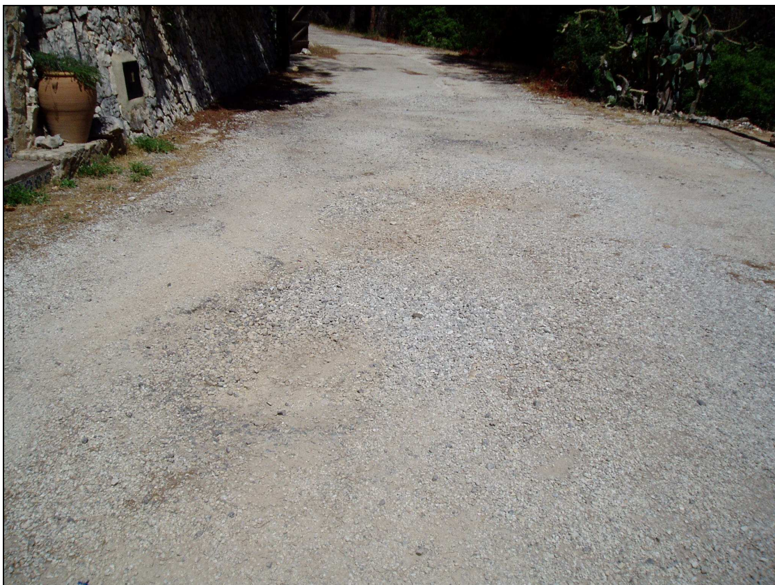
Fotografía nº7: Previo al bacheo se realizará un barrido de la plataforma.
