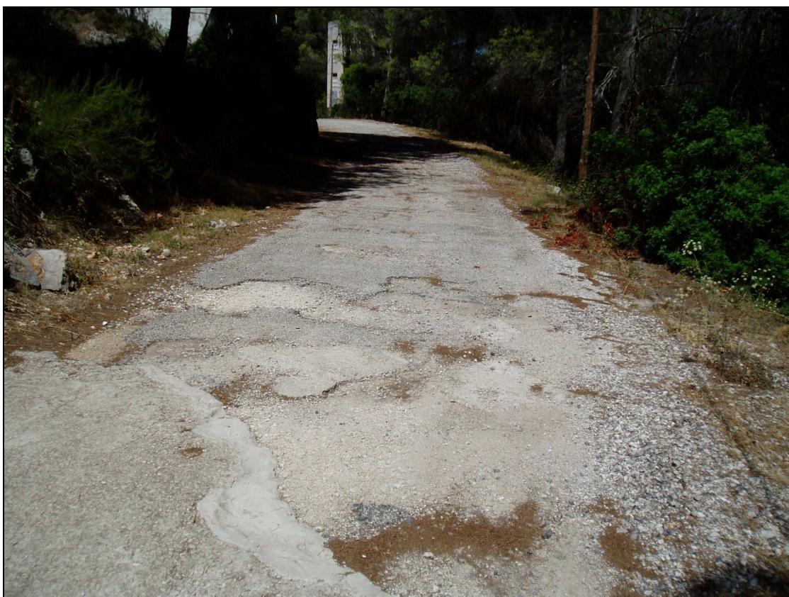
Fotografía nº8: Tras el barrido y el bacheo inicial, se extenderá la capa de rodadura de 4 cms de espesor.
