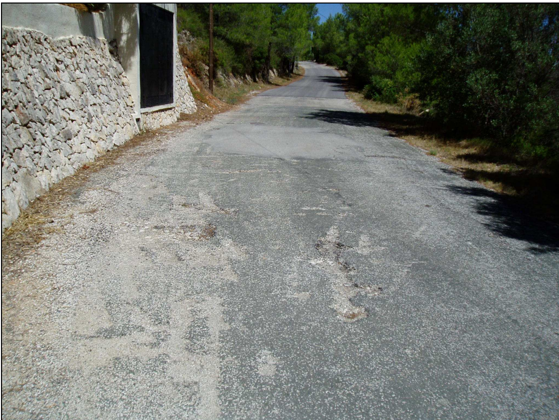
Fotografía nº4: El final de la actuación en este ramal se produce en una zona reparada recientemente.
