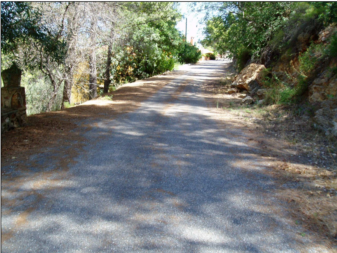
Fotografía nº10: Final de la actuación junto al chalet rojo de la izquierda. A la derecha se observa la gran piedra caída sobre el camino que habrá que demoler y reperfilar el talud.
