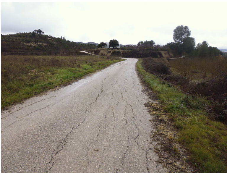
- Detalle del agrietamiento longitudinal del firme bituminoso -
