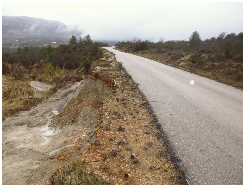
- Derrumbe del talud bajo la calzada, provocado por el cauce del barranco-
