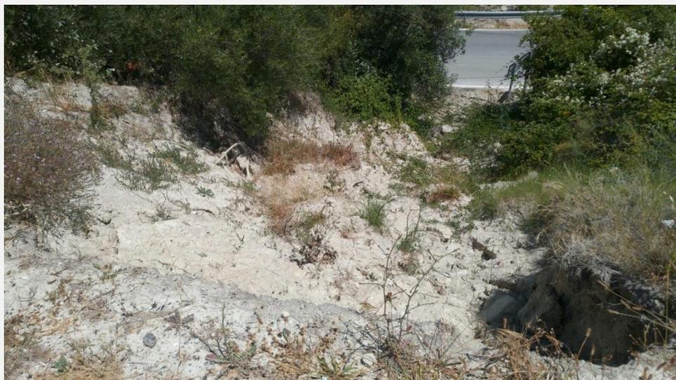
**Foto 04. Ubicación Pk 0+210.** Zona de refuerzo del talud mediante revestimiento del mismo con piedras de escollera. Se proyecta el desbroce, adecuación de la base mediante excavación y posterior revestimiento del talud con piedra de escollera de tamaño media superior a los 400 kg.
