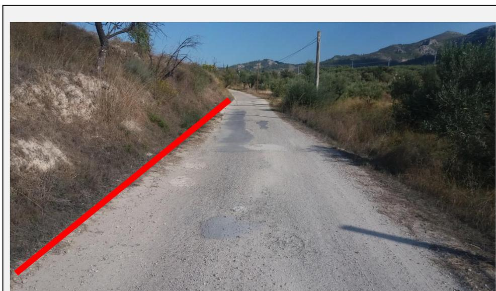
**Foto 10. Ubicación Pk 0+540.** Elevado estado de deterioro de la capa de rodadura con diversos baches existentes, siendo visibles las reparaciones anteriores de los mismos. Corresponde a una zona donde en la actualidad se produce encharcamiento de las aguas de escorrentía superficial.
