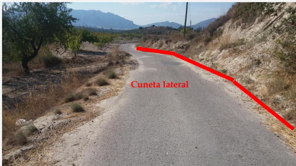
**Foto 07. Ubicación Pk 0+430.** Zona correspondiente a desmonte del camino. Se proyecta cuneta lateral de hormigón de 1,50 m en el margen izquierdo.
