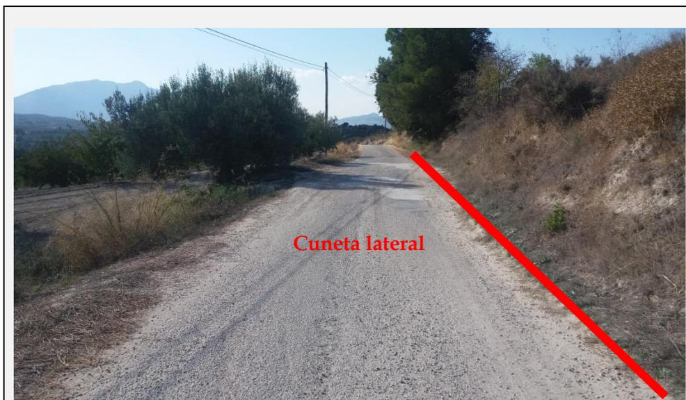
**Foto 09. Ubicación Pk 0+500.** Zona final de actuación del desmonte. Se proyecta cuneta lateral de hormigón de 1,50 m en el margen izquierdo.
