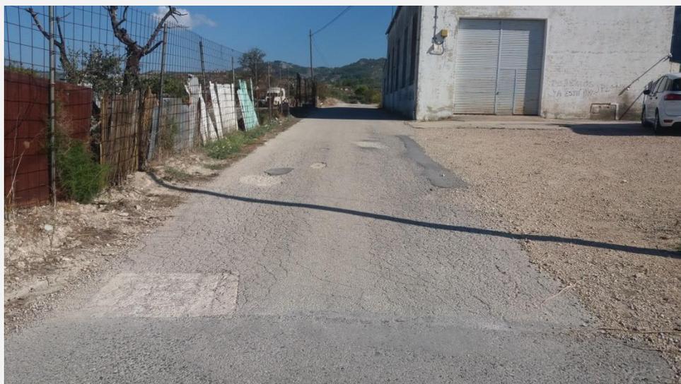
**Foto 02. Ubicación Pk 0+040.** Camino con elevado estado de deterioro. Se presenta una capa de rodadura con patología de piel de cocodrilo, así como diversos parcheos puntuales.
