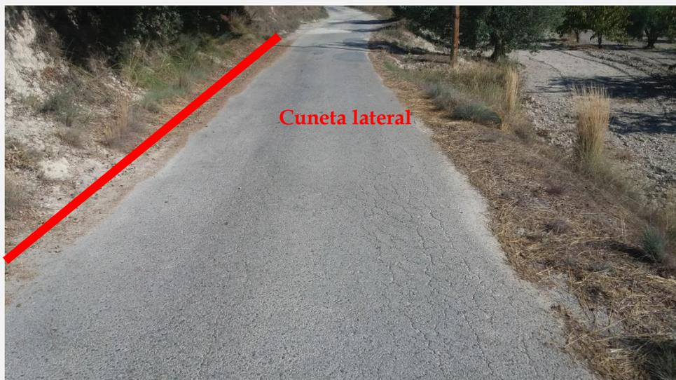
**Foto 08. Ubicación Pk 0+460.** Zona correspondiente a desmonte del camino. Se proyecta cuneta lateral de hormigón de 1,10 m en el margen izquierdo.
