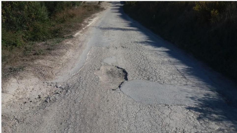
**Foto 03. Ubicación Pk 0+150.** Capa de rodadura altamente deteriorada con pérdida de aglomerado asfáltico (baches de 10 cm de profundidad). Se aprecia el estado en piel de cocodrilo de la capa de aglomerado asfáltico, patología que avisa de la final de la vida útil del pavimento.
