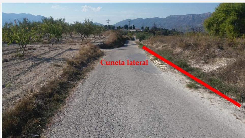
**Foto 06. Ubicación Pk 0+360.** Rotura de la capa de rodadura producida por las solicitudes de tráfico, fatiga y al envejecimiento.
