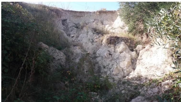
Deslizamiento del pie de talud de abanalamiento. En la parte superior se observa la plataforma del camino.
