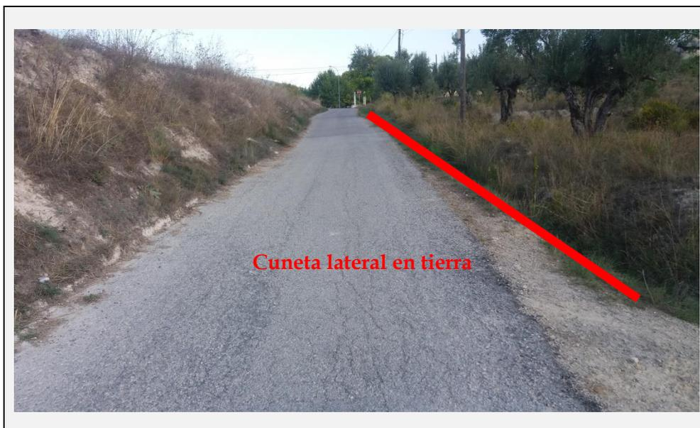
**Foto 11. Ubicación Pk 0+590.** Limpieza de cuneta existente en margen derecho. Se llevará a cabo la adecuación del vial hasta el Pk 0+672.
