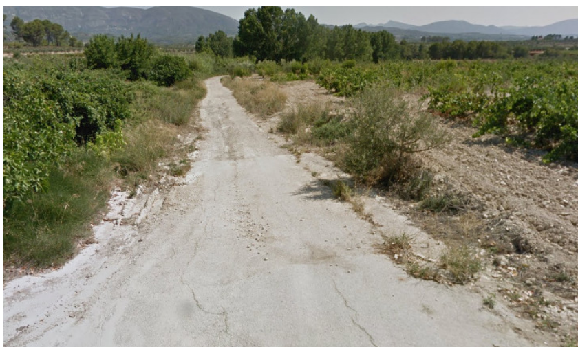
Fotografía 5. Camino de la depuradora, zona de actuación Nº 4
