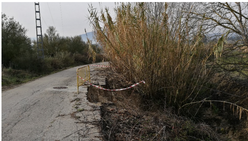
Fotografía 3. Camino de la depuradora, zona de actuación Nº 3
