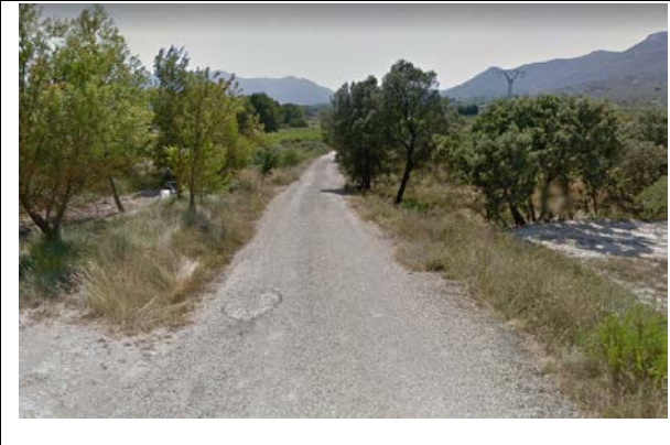
Camino de la depuradora Act Nº 1. Estado anterior
