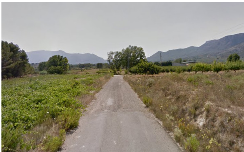
Fotografía 2. Camino de la depuradora, zona de actuación Nº 2
