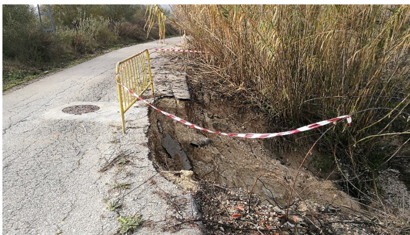
Fotografía 4. Camino de la depuradora, zona de actuación Nº 3
