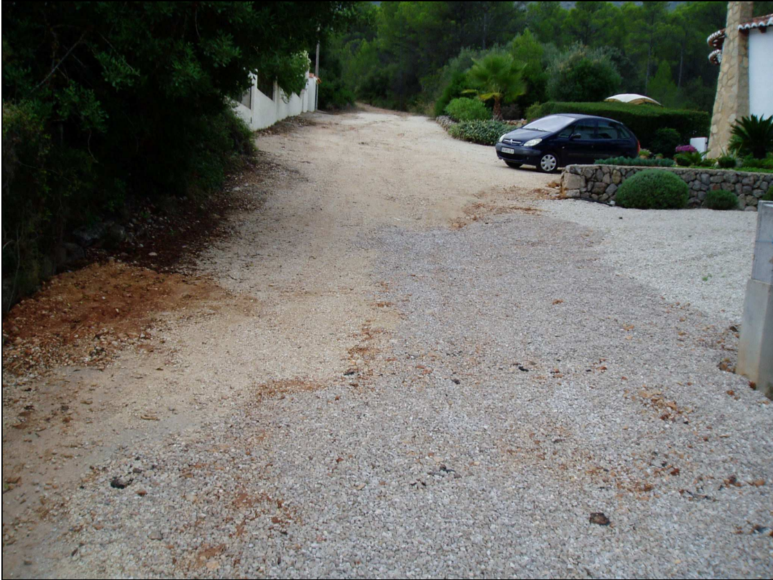
Fotografía nº7: Vista del ramal que se repara al final del camino principal. El camino está muy dañado por las aguas que bajan y se ha extendido una gravilla.
