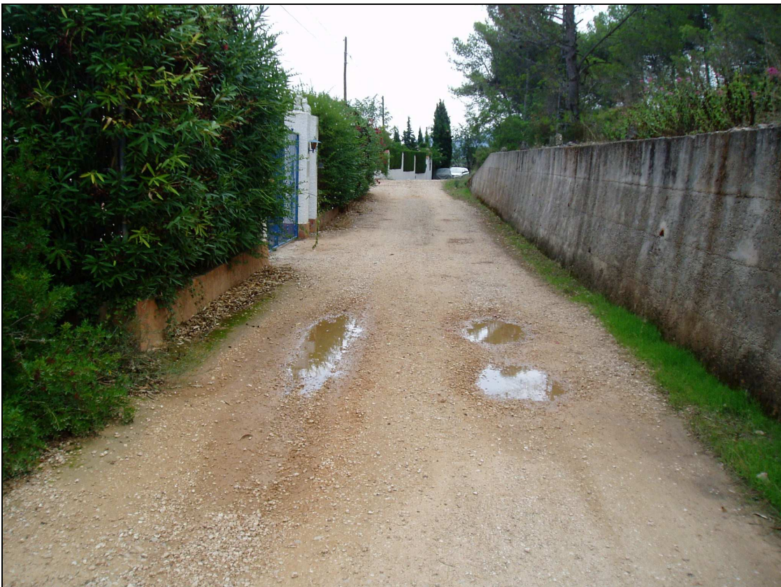
Fotografía nº4: El camino en esta zona será de 3,70 metros de ancho, dejando un hueco de unos 60 cms entre el pavimento y el muro.
