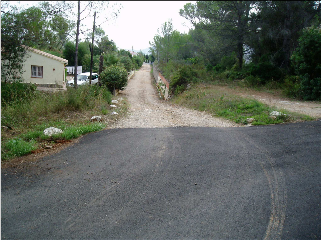
Fotografía n°1: Inicio de la actuación en el camino del Barranquet, junto al aglomerado existente de reciente puesta en obra. En sus primeros metros presenta un ancho de 3,00 metros.
