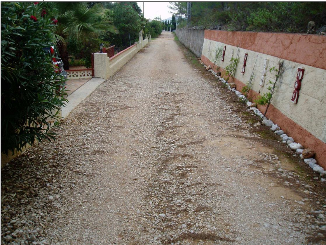
Fotografía n°2: El camino discurre entre el vallado de parcelas a la izquierda y un muro a la derecha. La zahorra del camino está muy lavada por la acción del agua.
