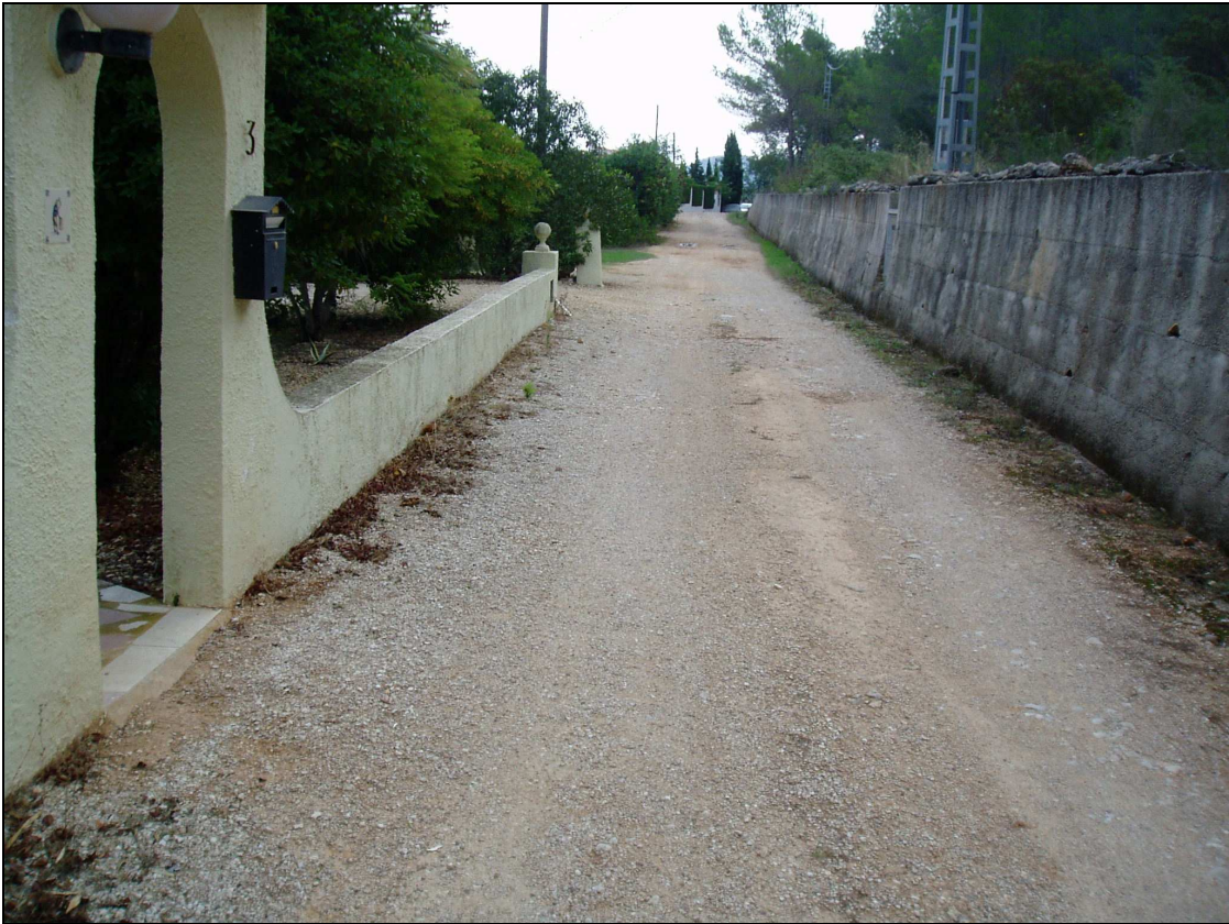
Fotografía nº3: El camino se escarificará y rasanteará dándole pendiente transversal hacia el muro.
