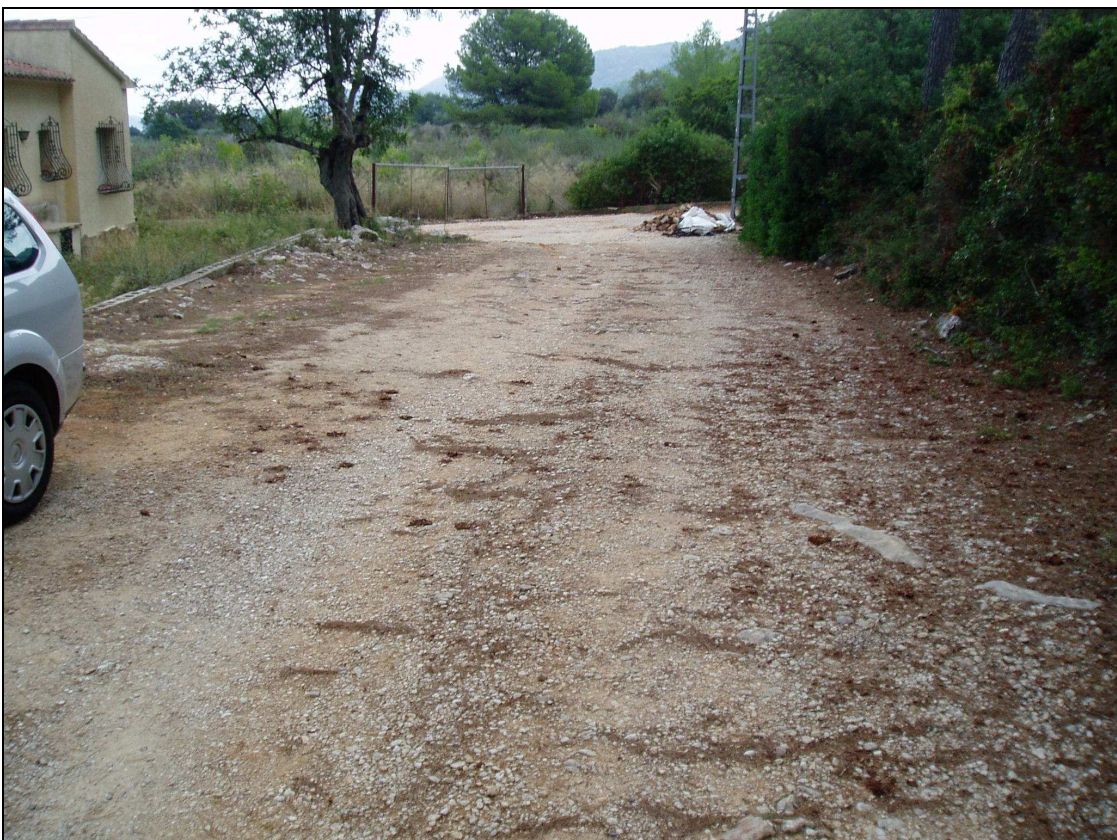
Fotografía nº6: Final del tramo principal del camino. El ancho en esta zona aumenta hasta los 5,00 metros.
