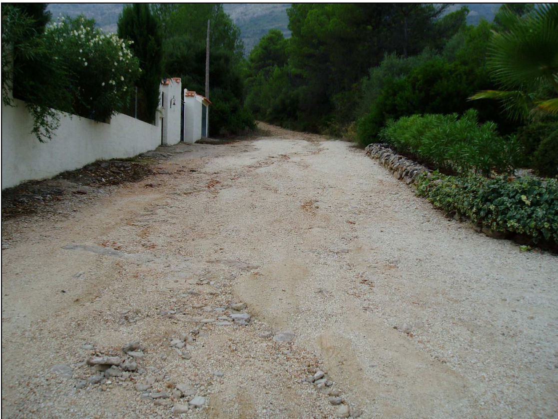
Fotografía nº8: Final de la actuación frente a la entrada del chalet de la izquierda. El ancho previsto en esta zona es de 4,00 metros.
