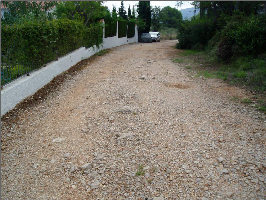
Fotografía nº5: La zahorra del camino está suelta y muy lavada.
