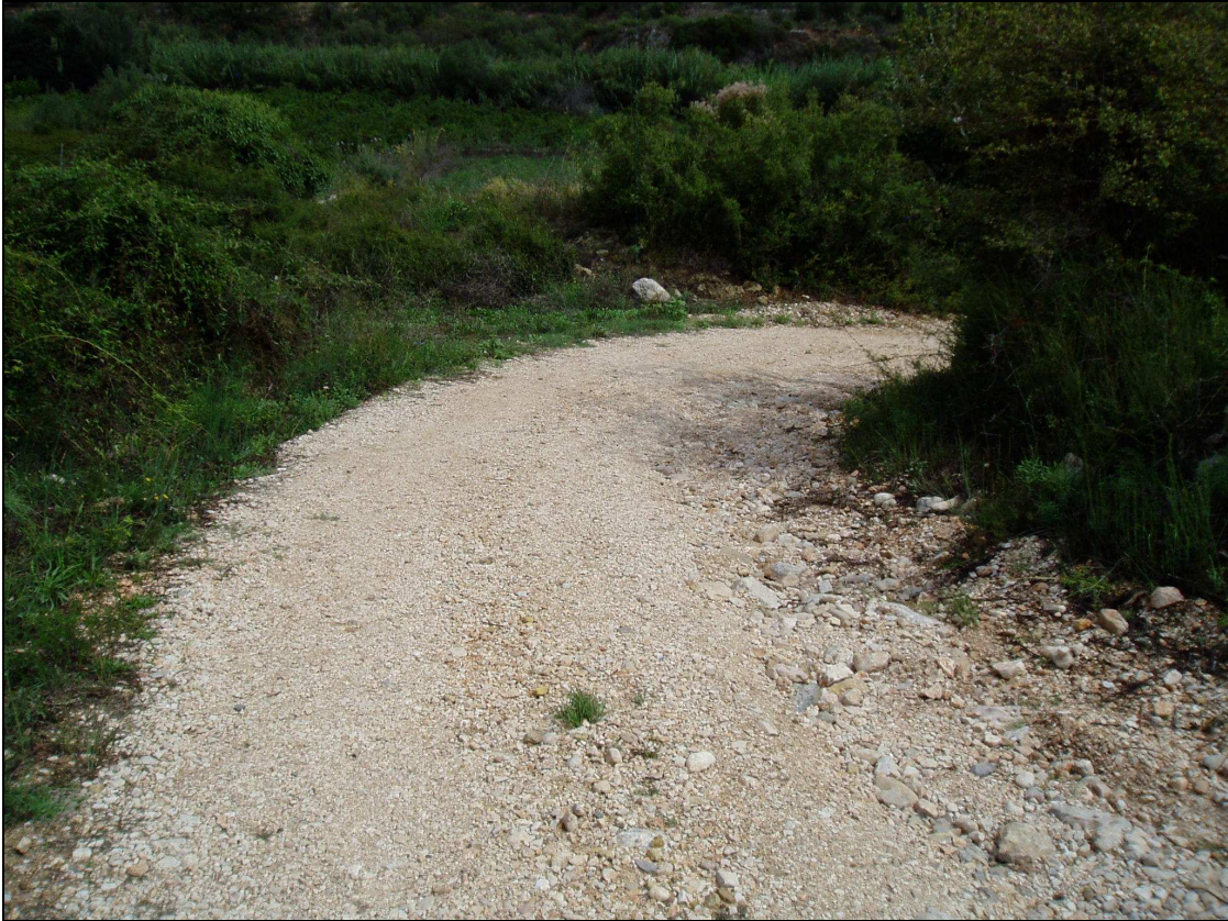
Fotografía nº9: Al final de la actuación, se presenta una curva a derechas de 90 grados con abundantes erosiones en su parte interior. Aquí se generará una nueva cuneta de hormigón.
