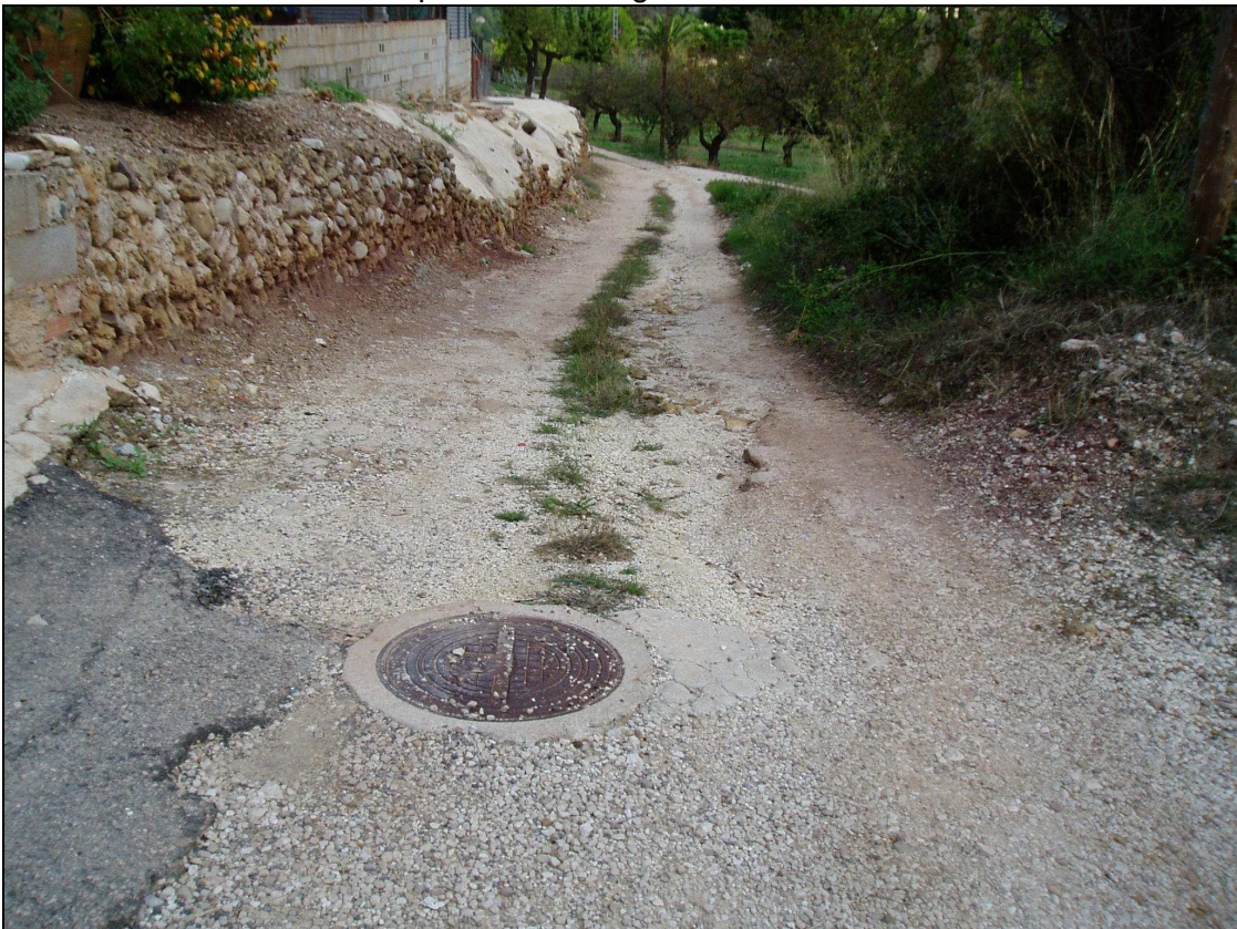
Fotografía nº2: Tras la subida y junto al acceso a una vivienda, el camino inicia su descenso hacia el río. El pavimento es de zahorra y presenta una trapa que se deberá recrecer.
