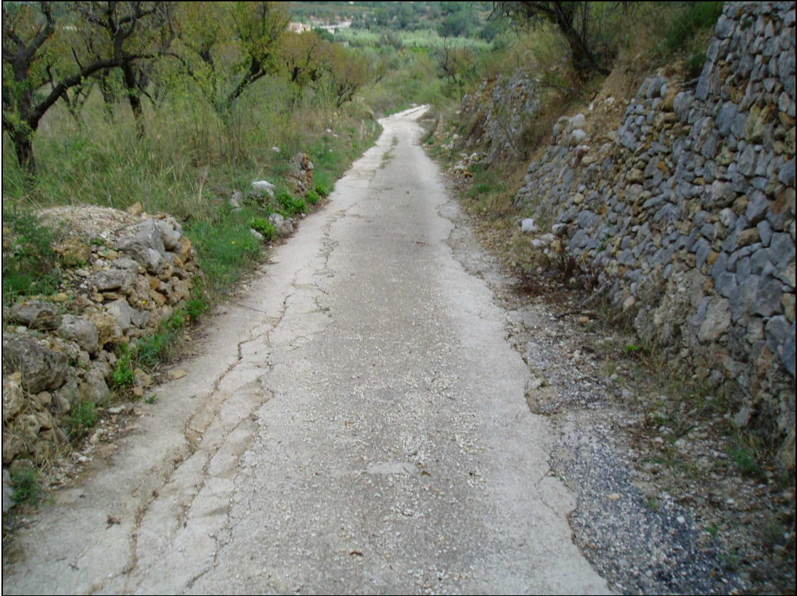
Fotografía nº5: El hormigón del camino está en muy malas condiciones, con abundante fisuración y bordes donde se ha perdido el firme.
