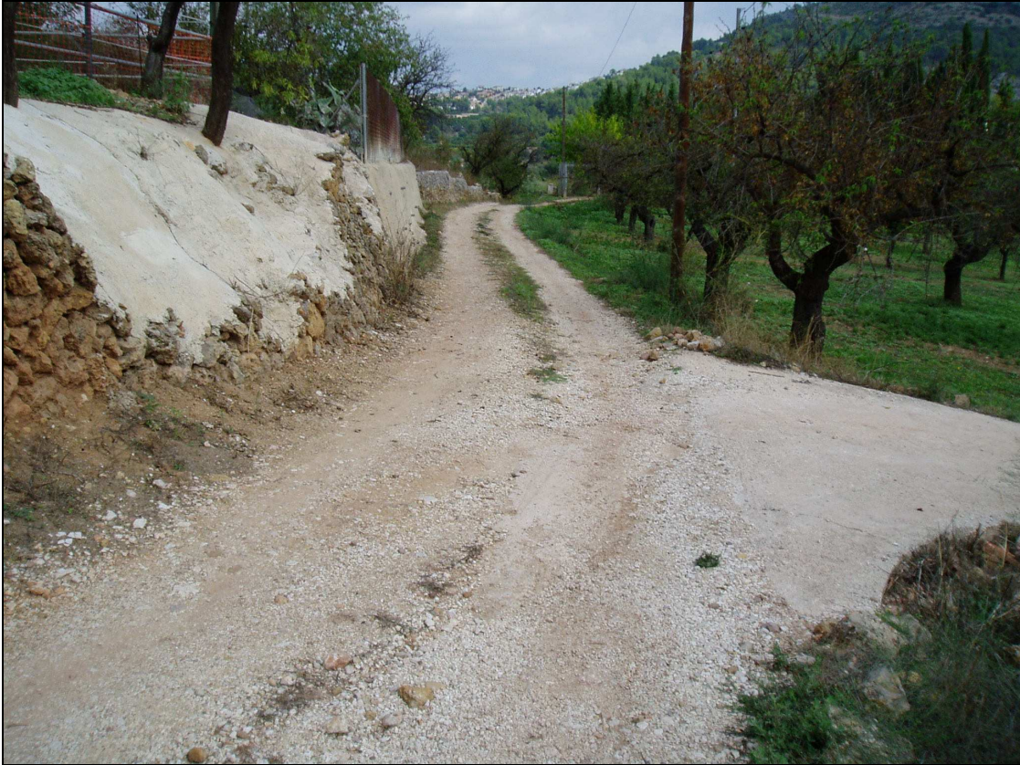
Fotografía nº3: En esta zona el camino discurre a media ladera y presenta la zahorra deteriorada y con arrastres.
