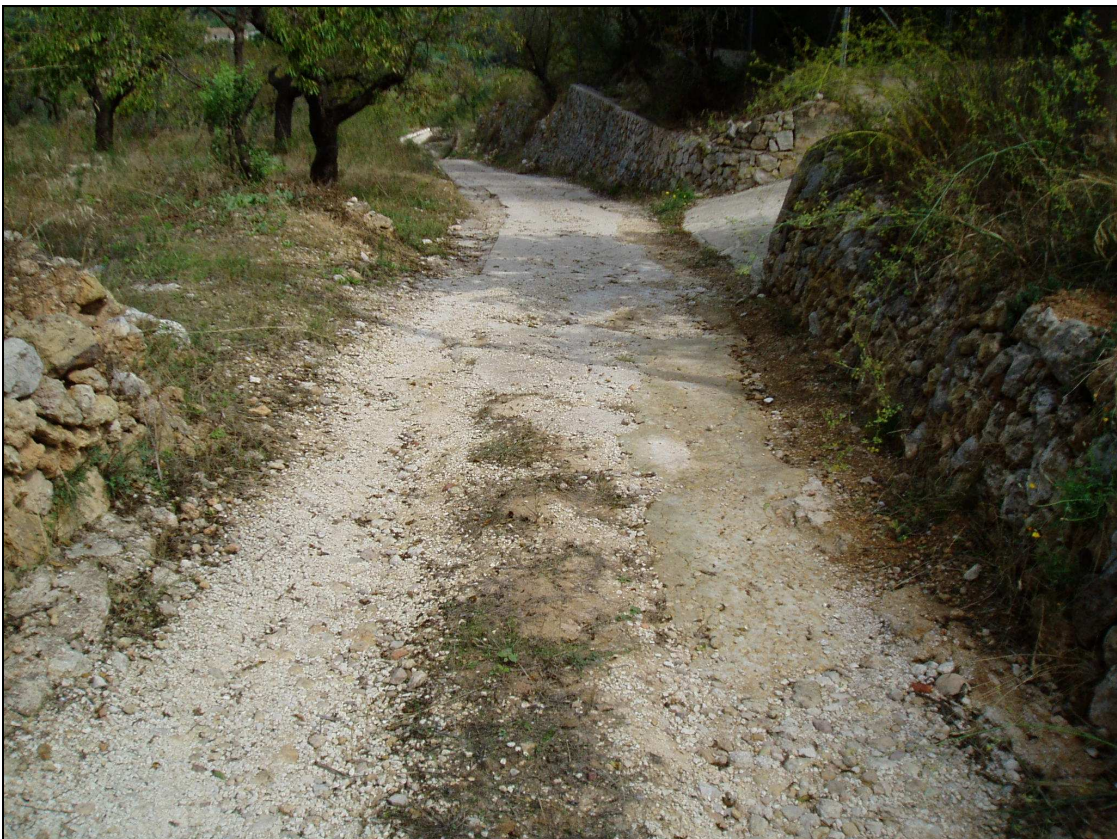
Fotografía nº4: Tras 120 m.l. con pavimento de zahorra, el camino presenta un tramo de 110 m.l. de hormigón muy deteriorado.
