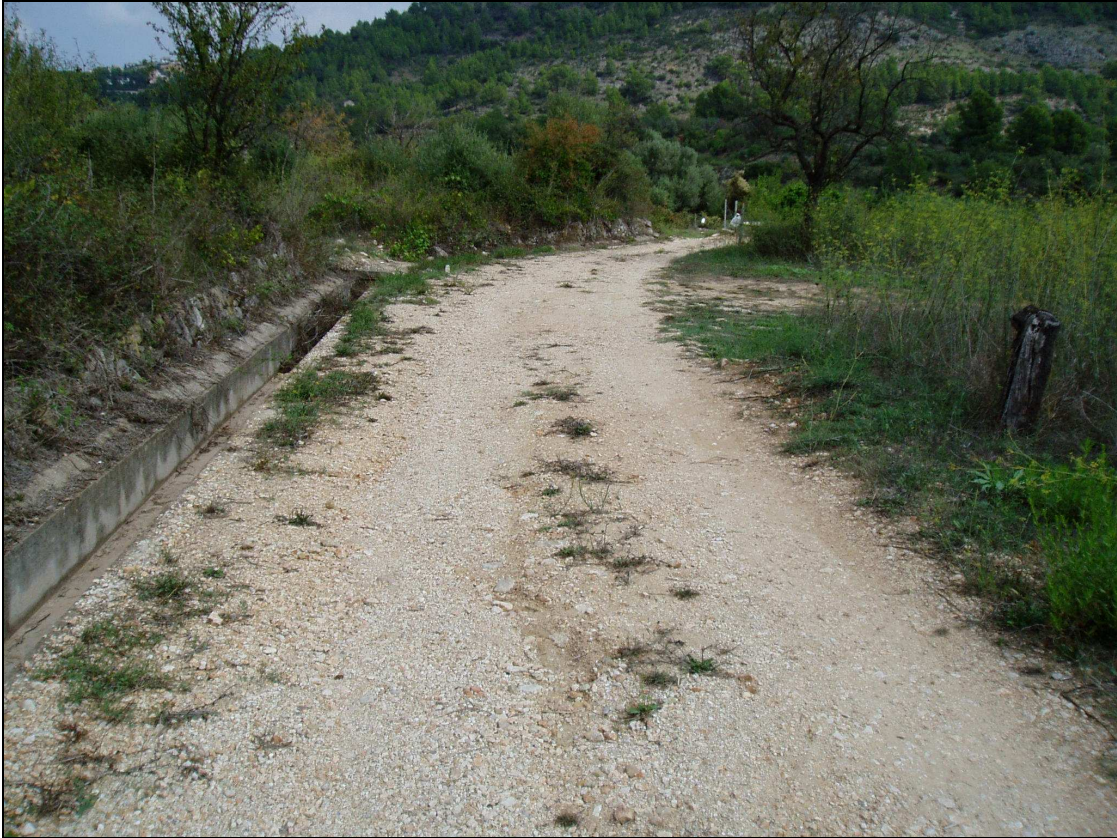
Fotografía n7: El tramo final presenta 88 m.l. de una cuneta tipo acequia que se deberá limpiar y acondicionar.
