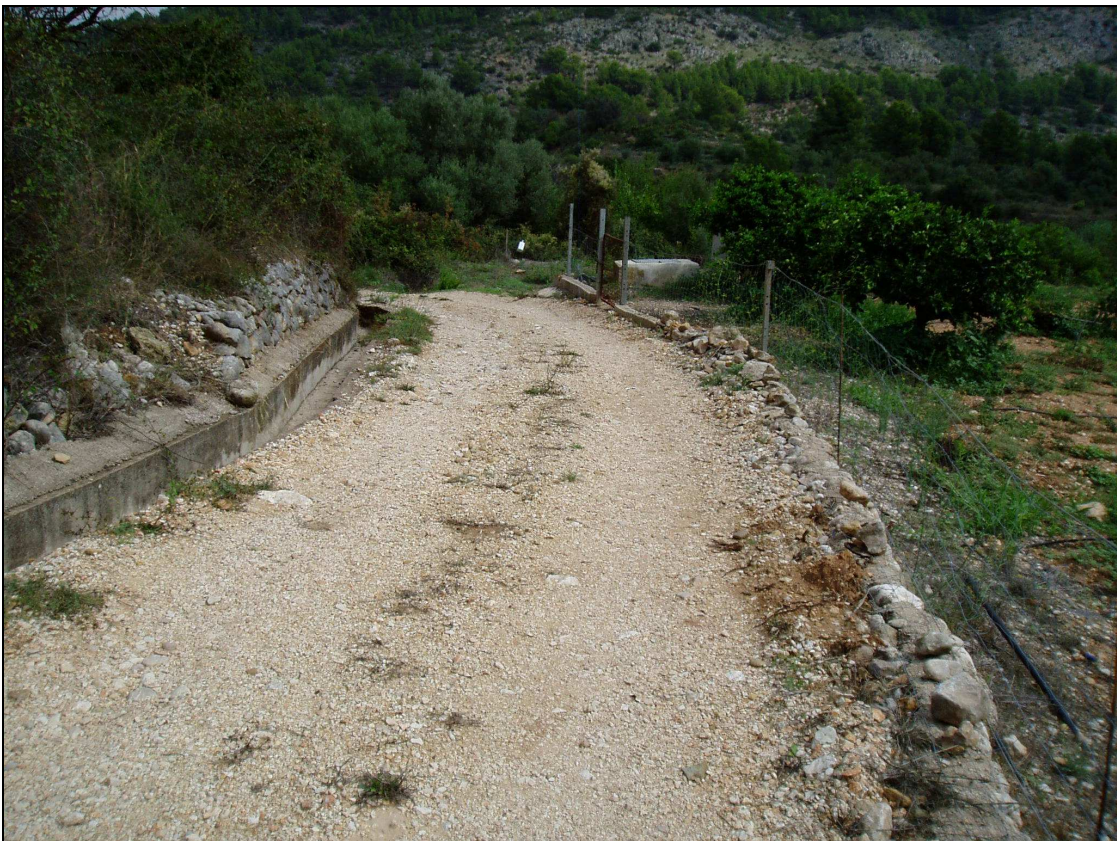
Fotografía n8: Al final de esta cuneta, existe una obra de drenaje transversal que se encuentra aterrada. Se ha incluido en el Proyecto su limpieza y acondicionamiento.
