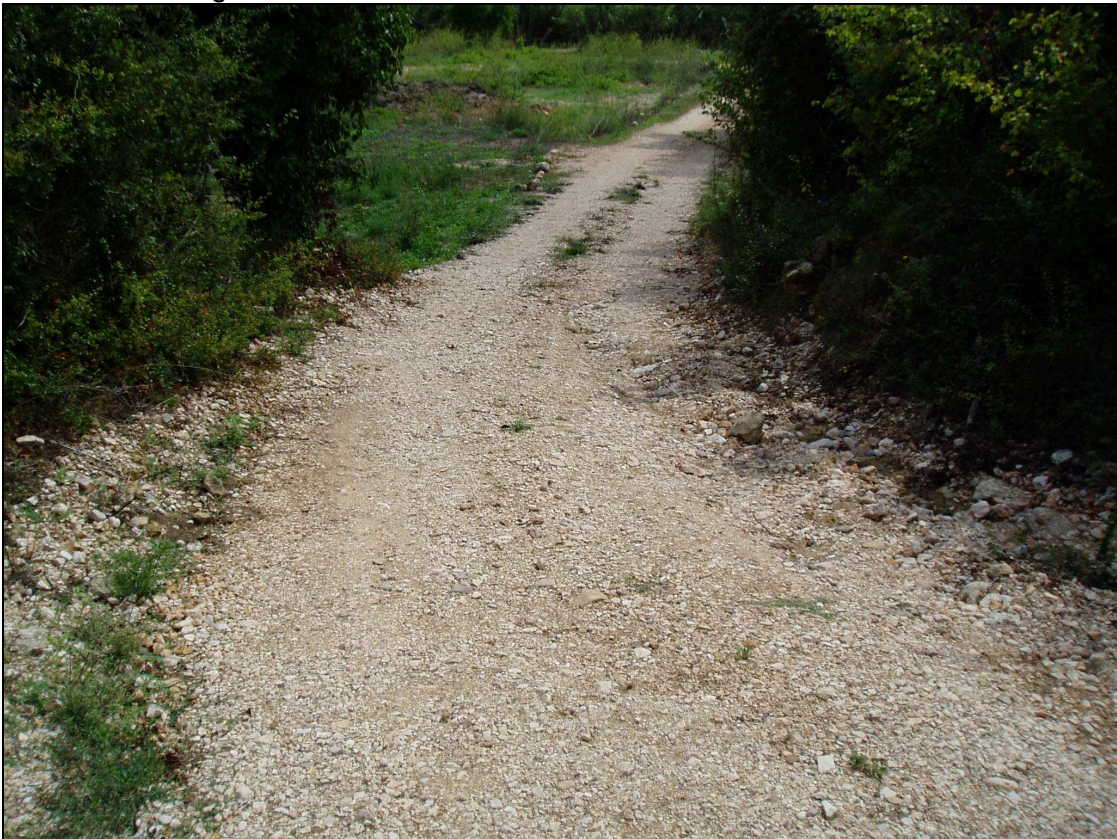
Fotografía nº10: Final de la actuación a la salida de la curva. El río se encuentra a unos 100 metros de este punto.
