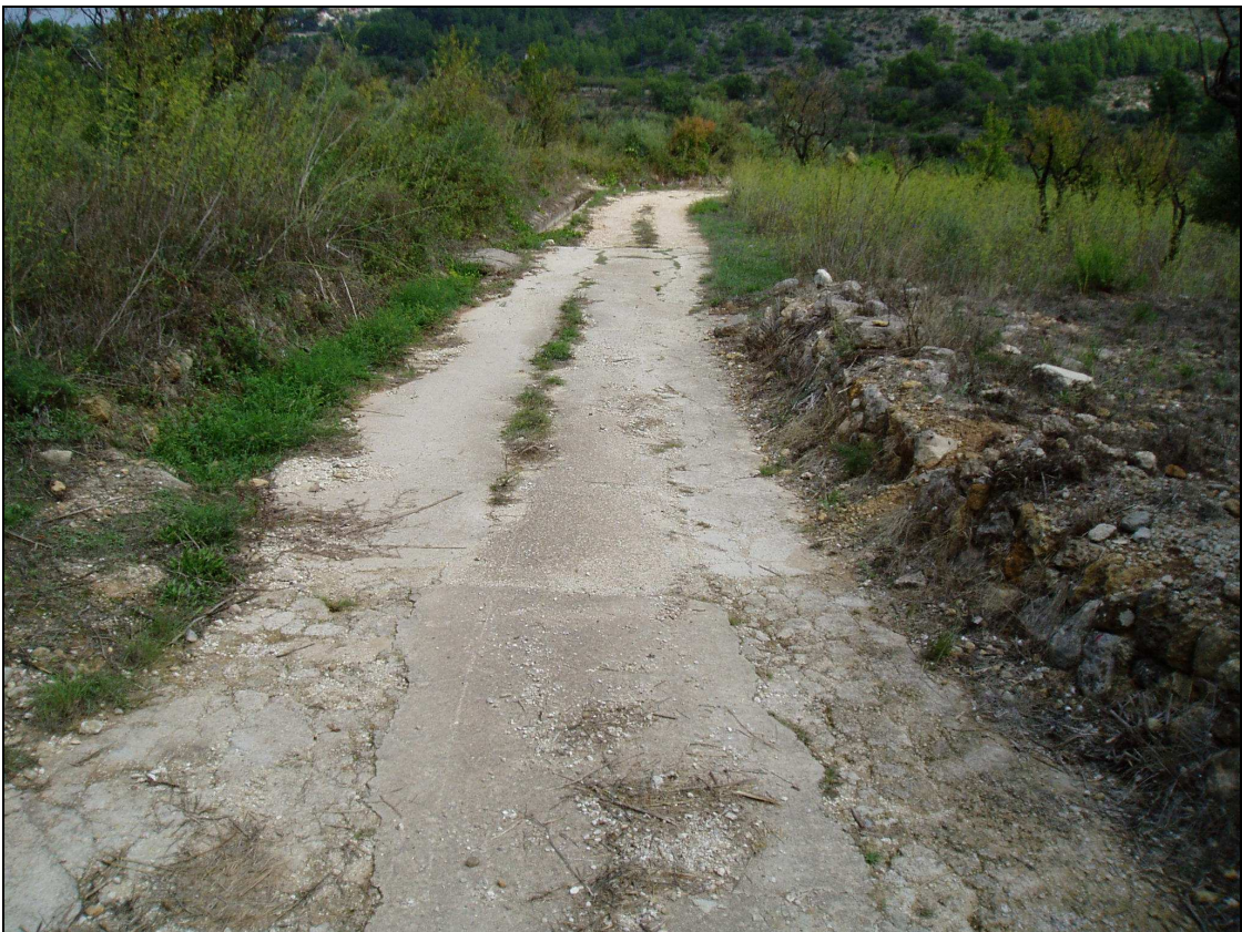
Fotografía nº6: Llegada al río Jalón, el camino vuelve a ser de zahorra.
