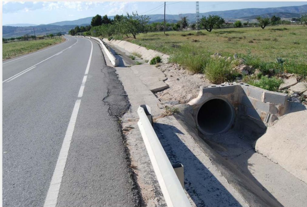
Foto nº 2. Vista del estado actual de las obras de paso a los predios particulares.
