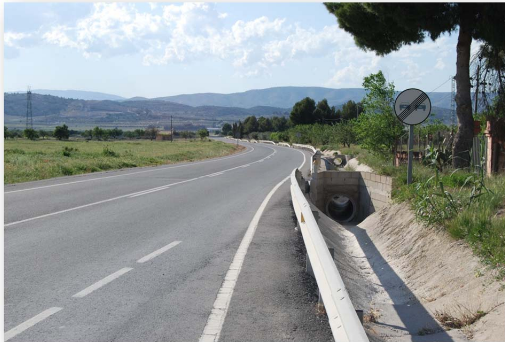
Foto nº 1. Vista general de la cuneta en el P.K. 1+400 junto al cruce de la CV-807 con el camino del Chicharra.
