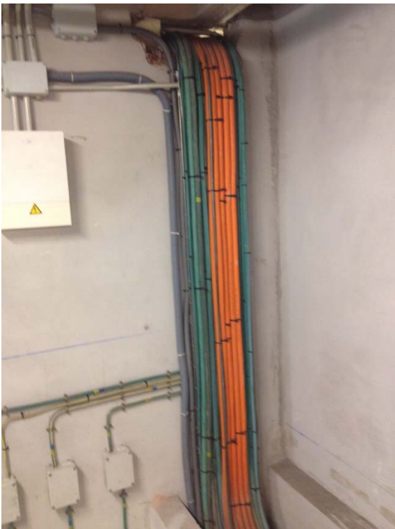
Salida de cuarto por techo
