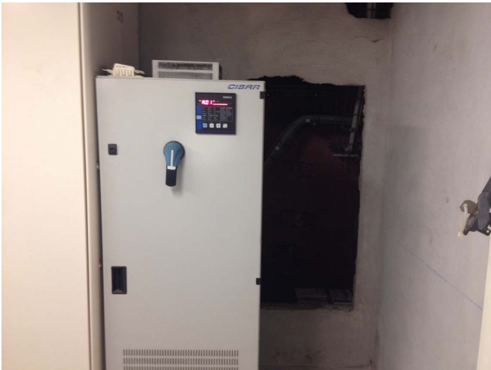
Hueco en cámara para salida a pasillo de Sótano -2
