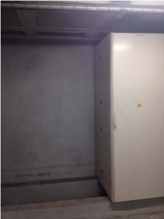
Hueco en CGBT para instalación de protección de líneas eléctricas
