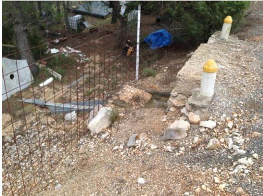
Estado del drenaje transversal en el otro borde, en el que vierte sobre una edificación.
