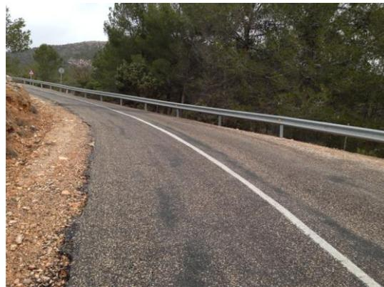
Roderas. Bionda y señalización vertical en buen estado.
