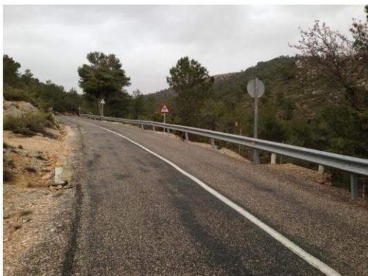
Roderas pronunciadas. Obra de drenaje transversal. Señalización vertical en buen estado.
