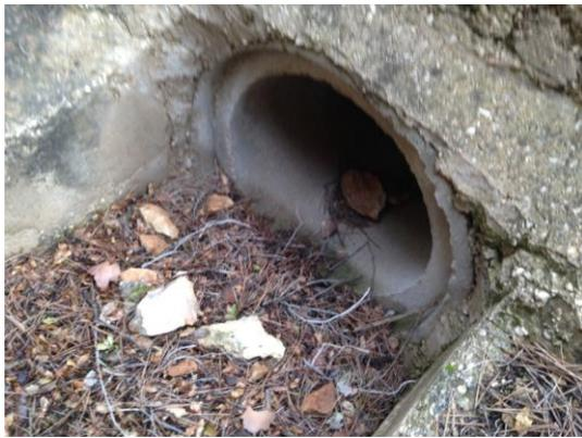
Tubo de hormigón que forma el drenaje transversal
