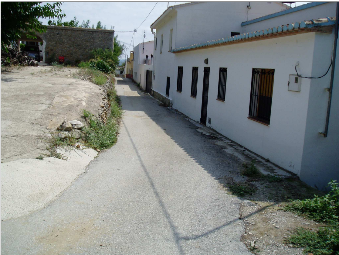
Fotografía nº6: En este punto, se construye un imbornal para evitar que el agua de lluvia siga entrando por la puerta de la vivienda de la fotografía.
