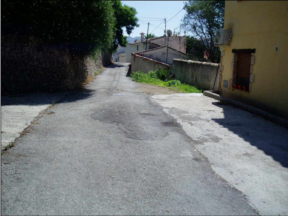
Fotografía nº9: Algunos vecinos han pavimentado en contrapendiente y puesto bordillos para defender sus casas del agua.
