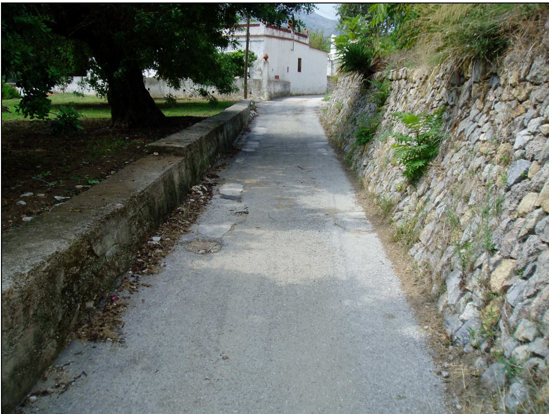
Fotografía nº2: El camino es muy estrecho en sus primeros metros con un ancho de 2,50 mts y presenta baches, parcheos y arrastres de las lluvias.
