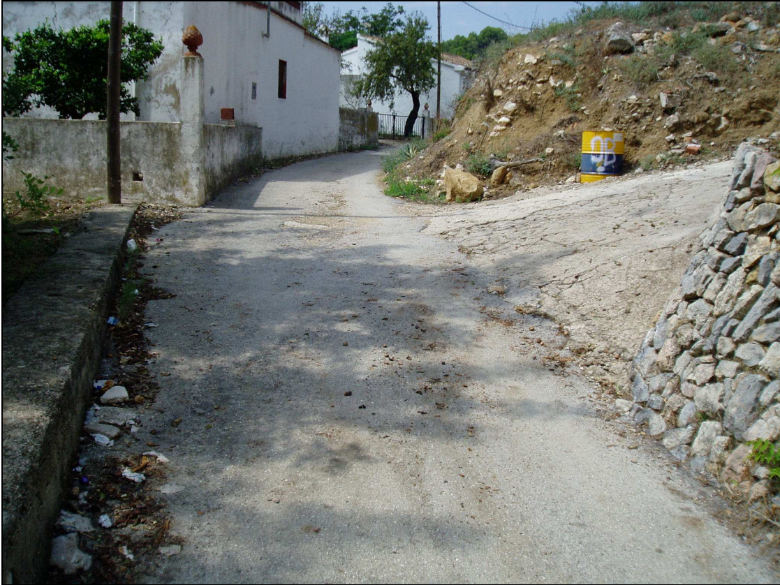
Fotografía nº3: El camino recibe el agua de lluvia de varios viales transversales con mucha pendiente.
