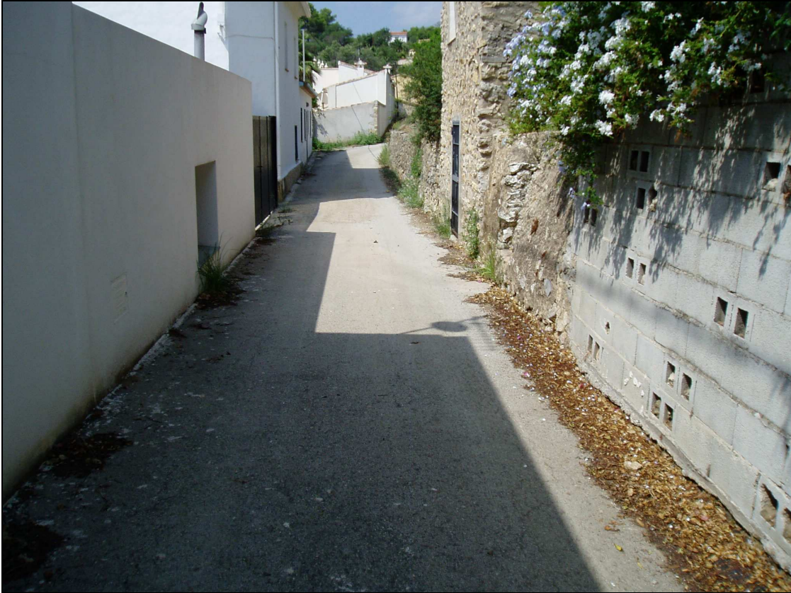
Fotografía nº5: Dado la estrechez del camino, el cierre de las fachadas y la aportación de agua de los viales superiores, el camino se comporta como un canal cuando llueve.
