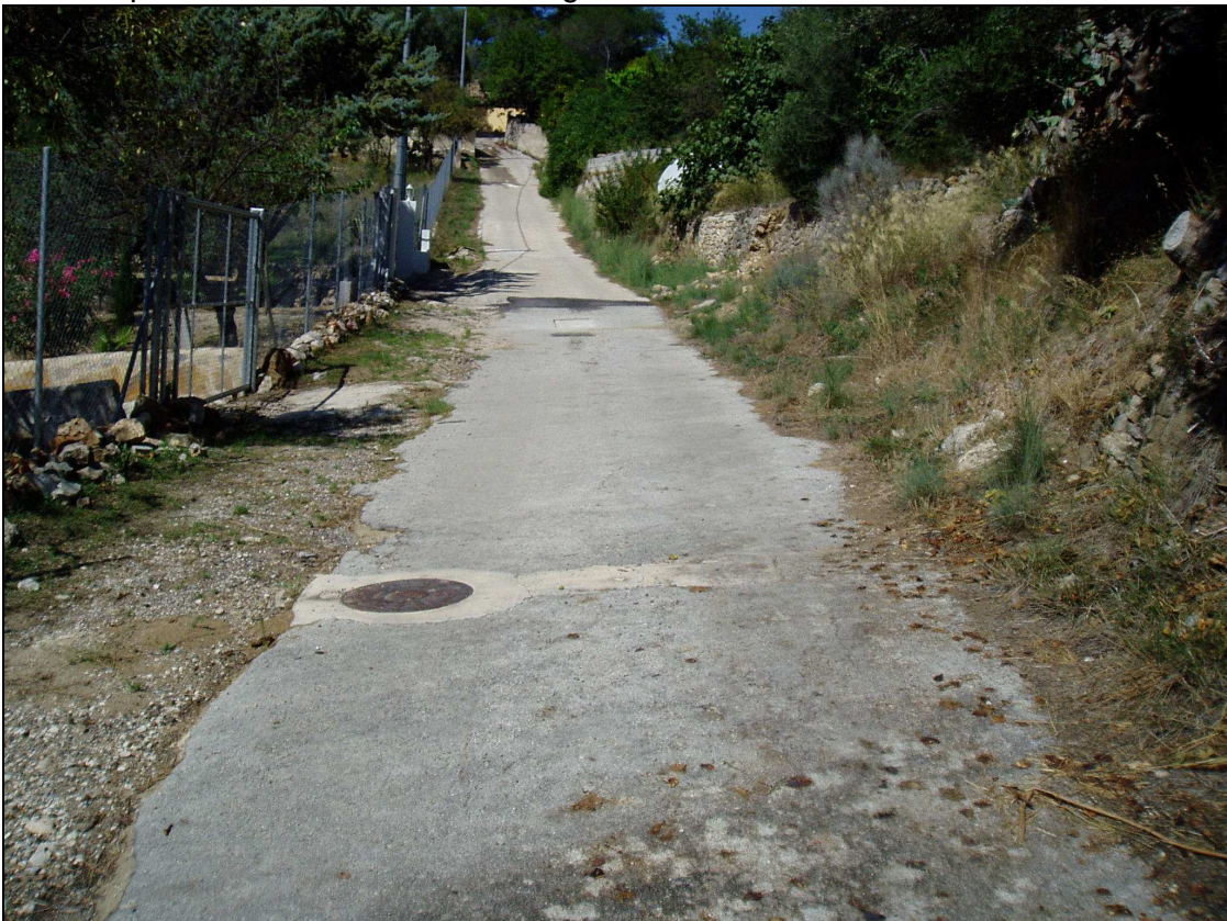
Fotografía nº10: Final de la actuación donde comienza el pavimento de hormigón (mancha transversal oscura). En esta zona (54 m.l.) se refuerza el camino con la misma tipología de hormigón con mallazo.
