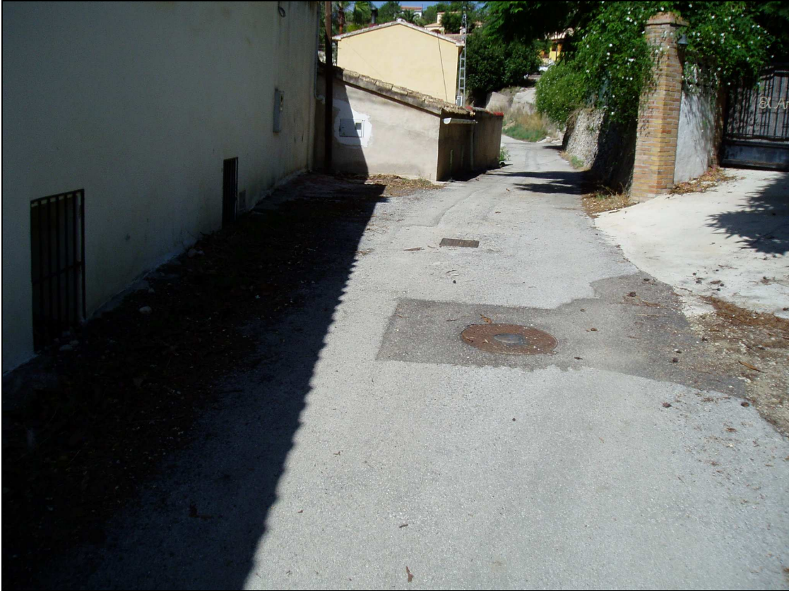
Fotografía n°7: La presencia de ventanales a la cota del camino obliga a fresar el firme en zonas específicas previo a la extensión de la nueva capa de aglomerado.
