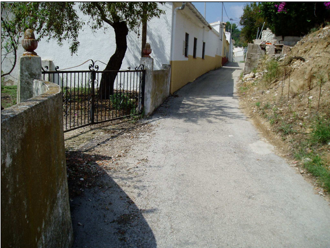
Fotografía nº4: Debido a la fuerte circulación de agua durante una lluvia, algunas viviendas permiten que el agua del camino salga a la carretera cruzando sus parcelas.
