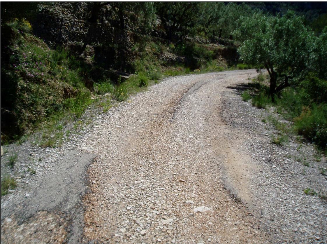
**Fotografía nº2:** La actuación pasa por escarificar el firme existente, añadirle zahorra artificial, rasante y compactar para obtener la nueva base.
