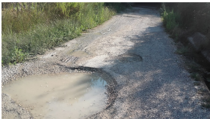
Fotografía 4. Camino de la Vía, zona de actuación Nº 3
