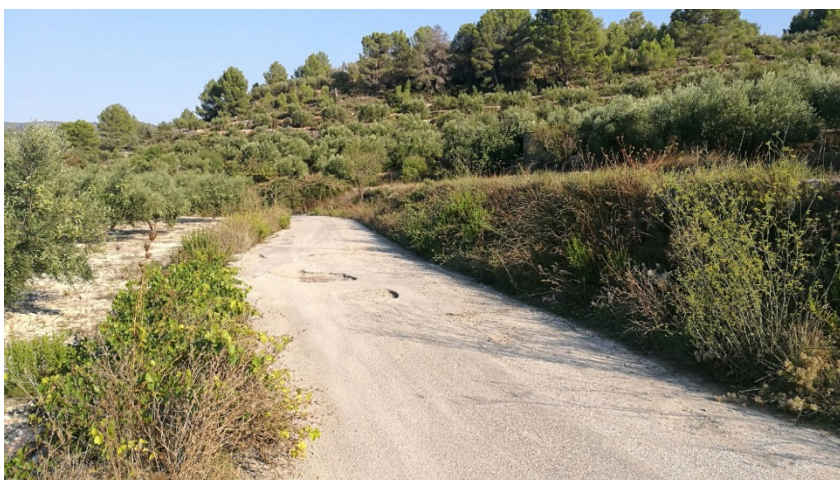
Fotografía 8. Camino del Pantano, zona de actuación Nº 7
