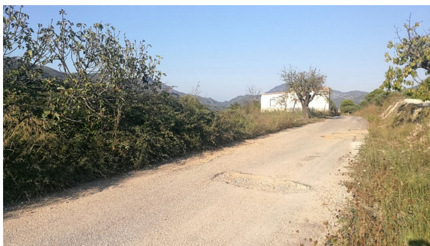
Fotografía 5. Caminodel Pantano, zona de actuación Nº 4
