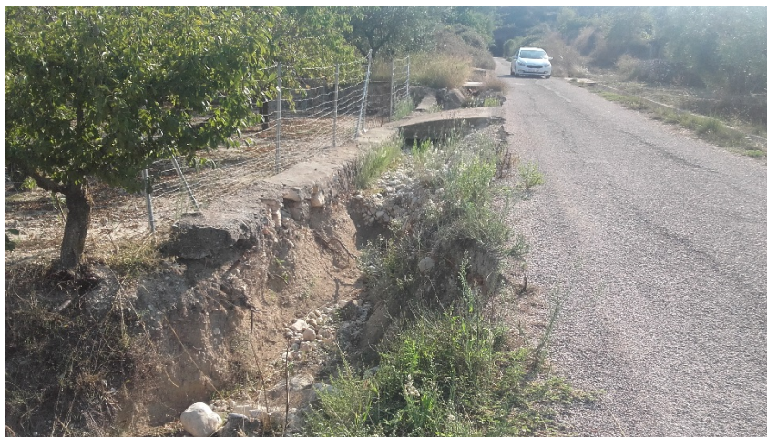
Fotografía 3. Camino de la Vía, zona de actuación Nº 2
