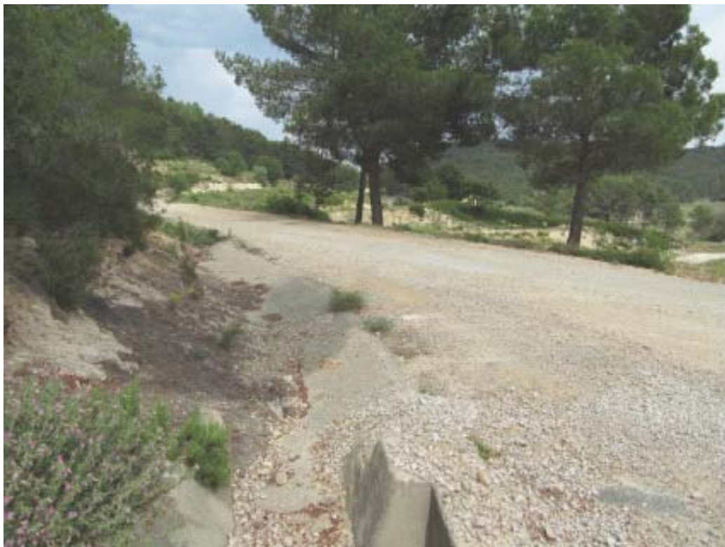
Foto 1 Estado actual inicio desde Camino "La Rabosina"
