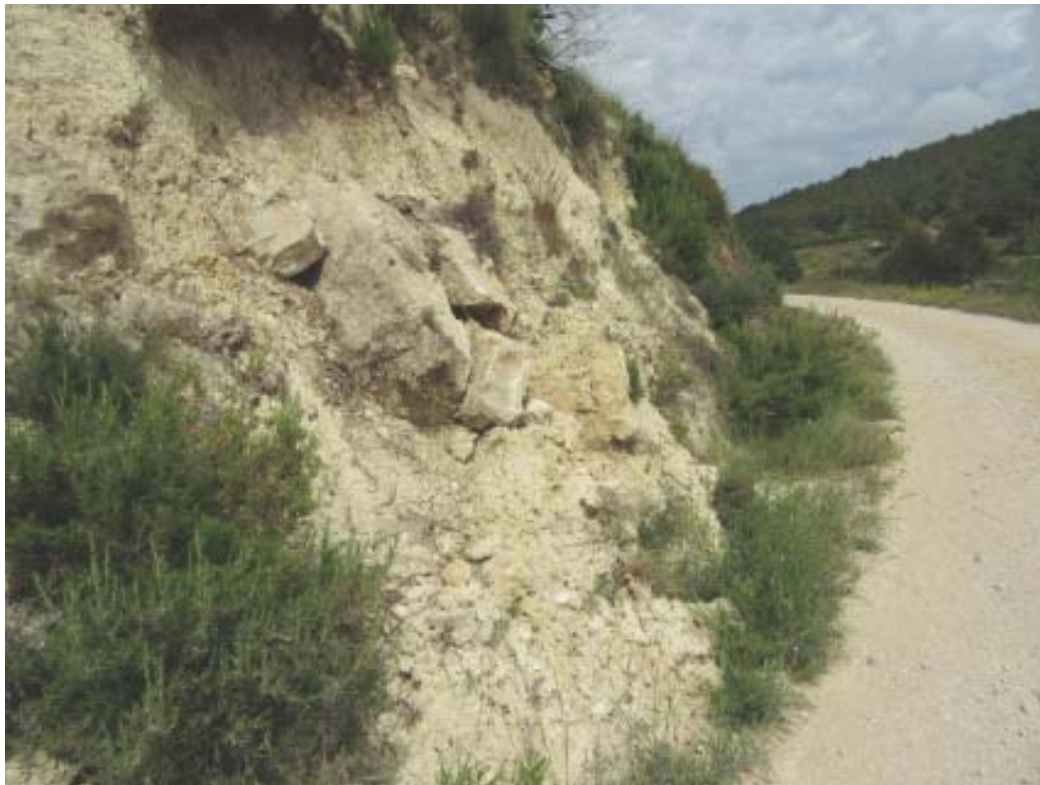
Foto 4 Talud con materiales inestables
