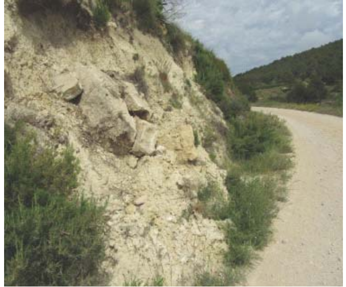
Cunetas obstruidas por desprendimientos
