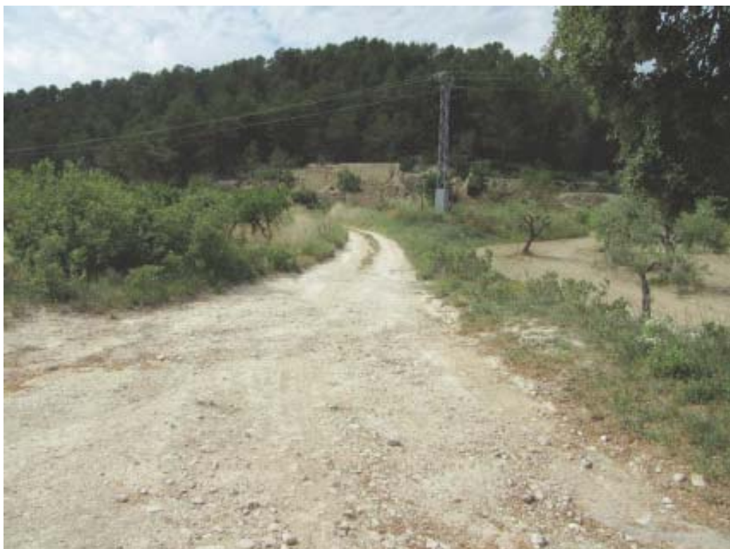
Foto 5 Estado actual PK 0,700
