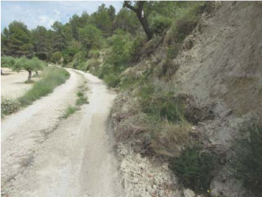
Foto 6 Estado actual PK 0,350
