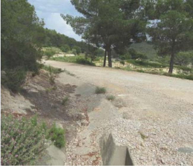
Cuneta y tajea
