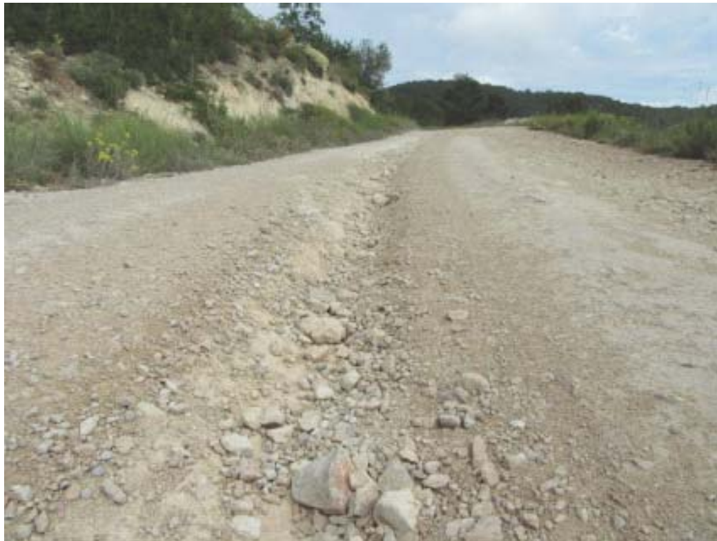
Foto 2 Estado actual cuneta obstruida
