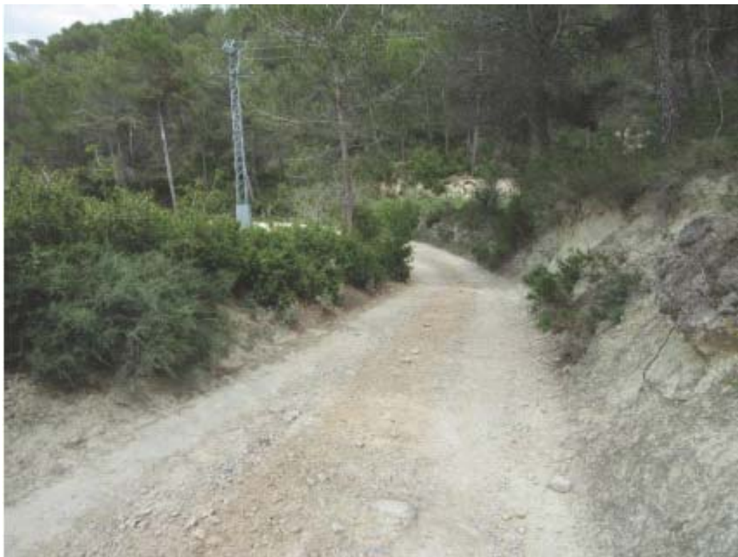
Foto 7 Estado actual PK 0,900
