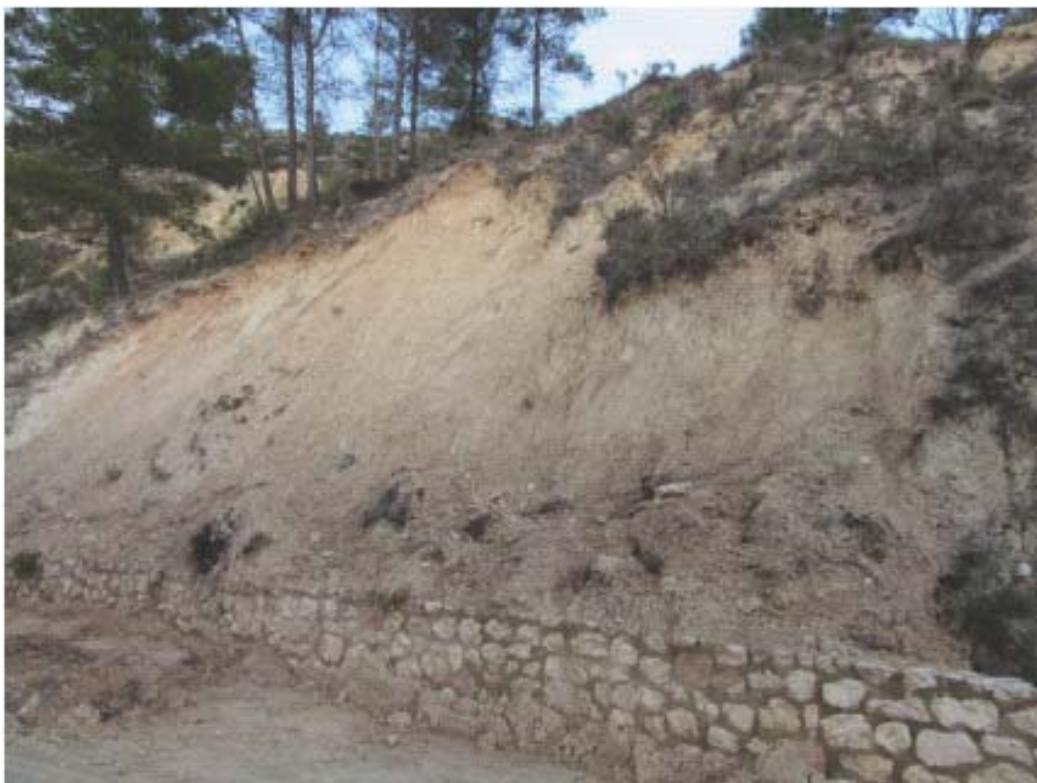
Foto 8 Estado actual deslizamiento taludes
