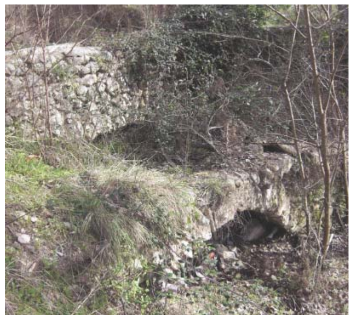
Conexión sumidero con antiguo cauce
