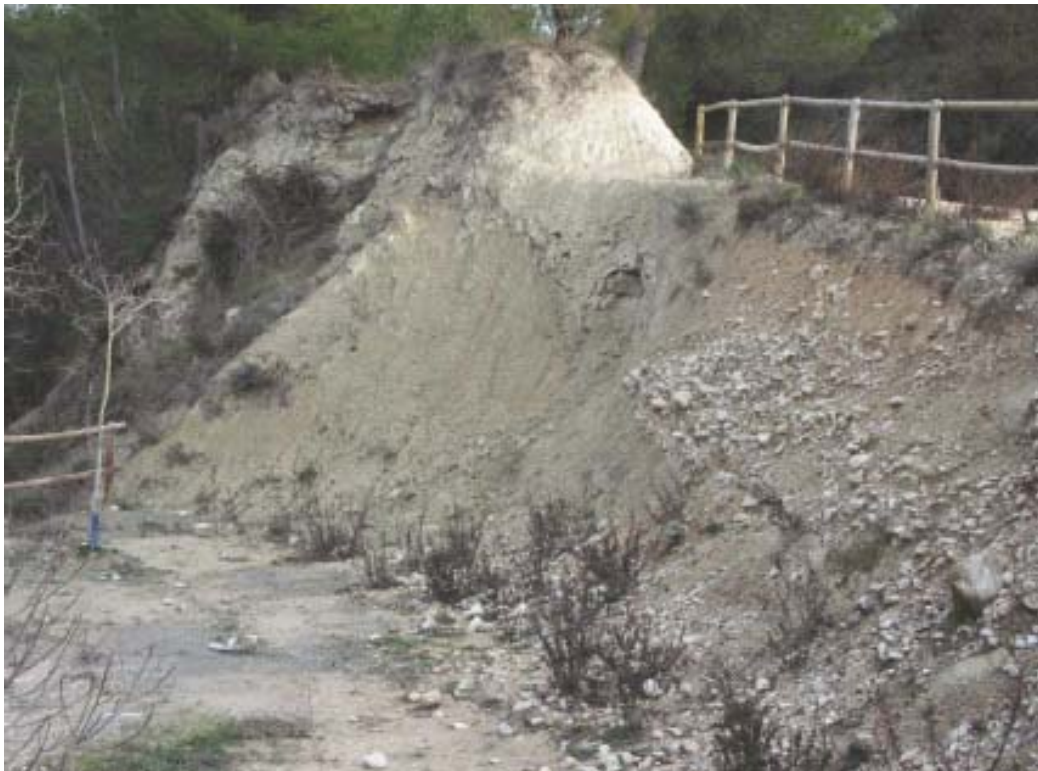
Foto 3 Desprendimientos talud acceso
