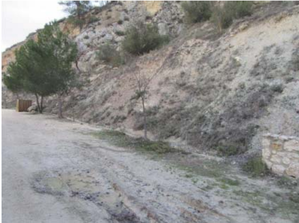
Foto 9 Estado actual deslizamiento taludes
