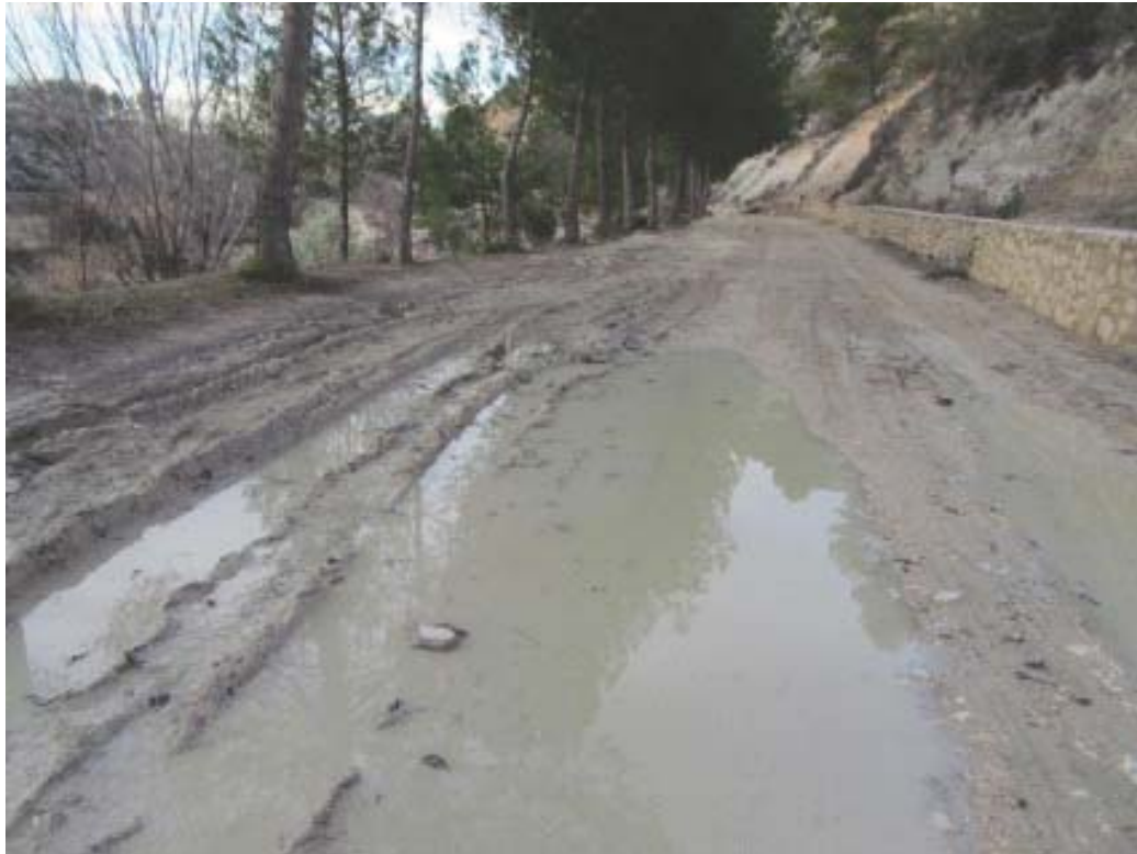
Foto 5 Estado actual camino
