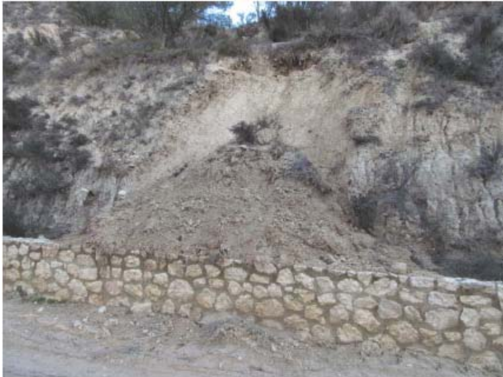
Foto 7 Estado actual deslizamiento taludes
