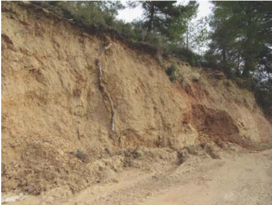
Foto 1 Estado actual desprendimiento sobre el camino
