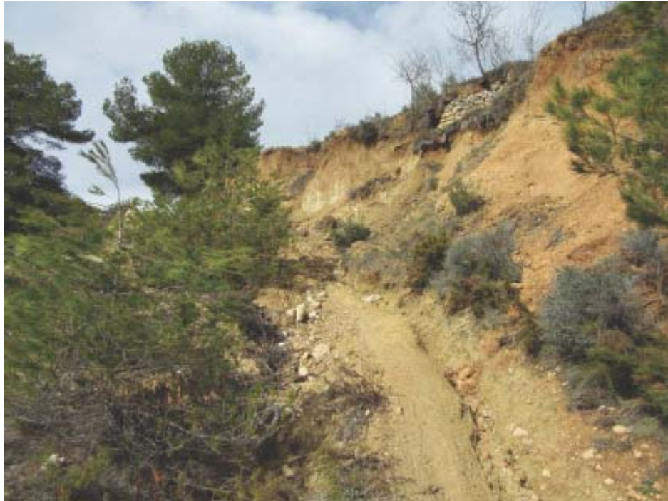
Foto 5 Estado actual desprendimiento sobre el camino exterior
