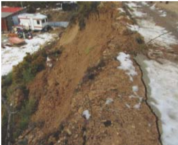
Desprendimientos en los taludes.
