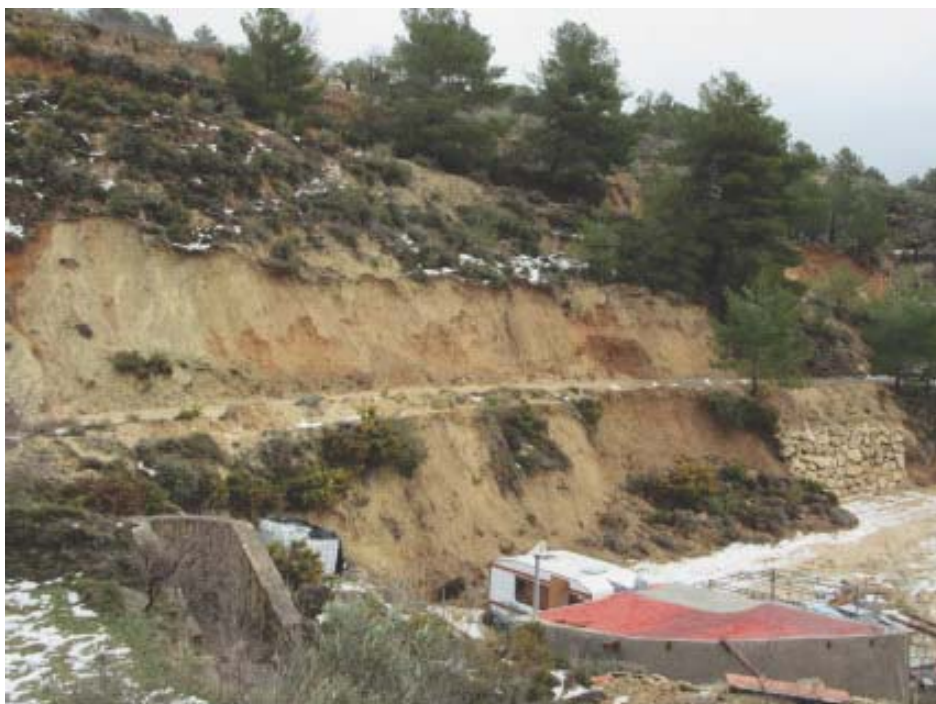
Foto 4 Vista general desprendimiento talud del camino
