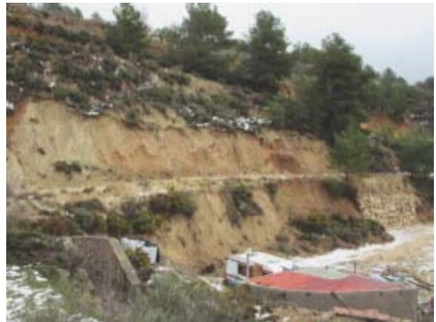
Desprendimientos en los taludes.
