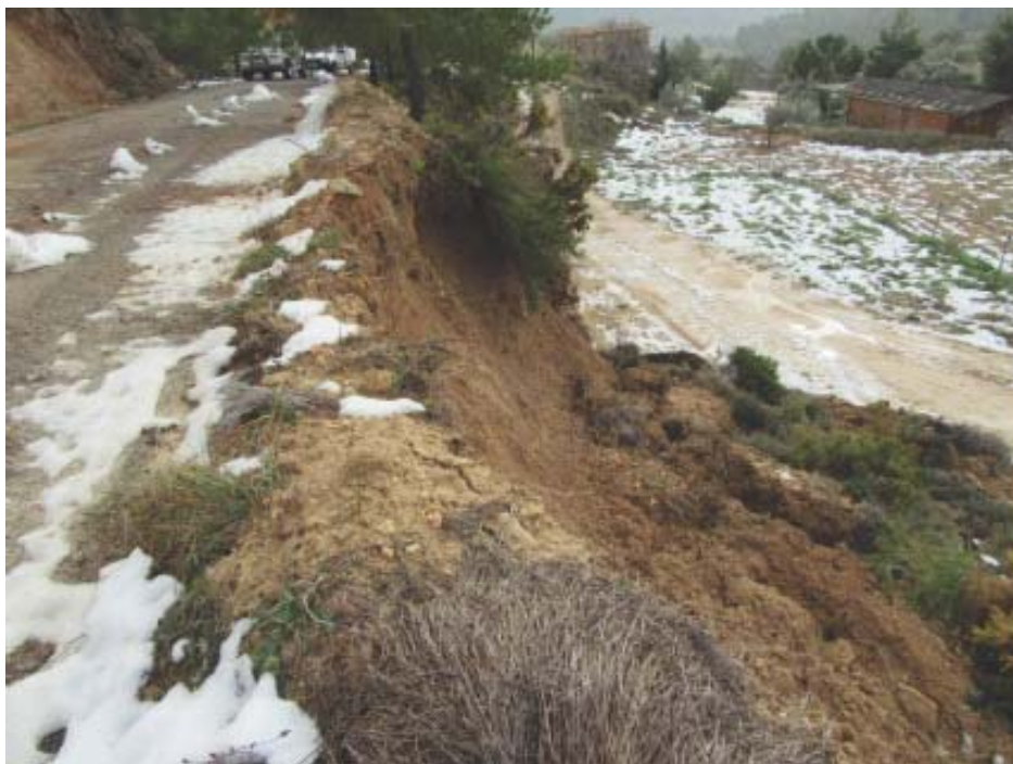
Foto 2 Estado actual desprendimiento talud del camino
