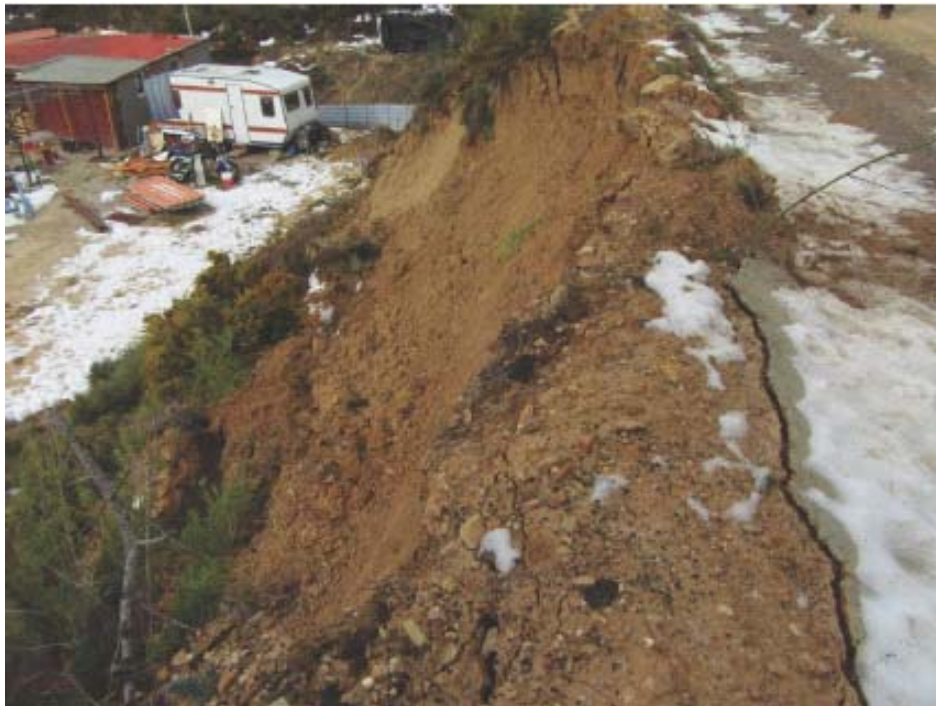
Foto 3 Estado actual desprendimiento talud del camino
