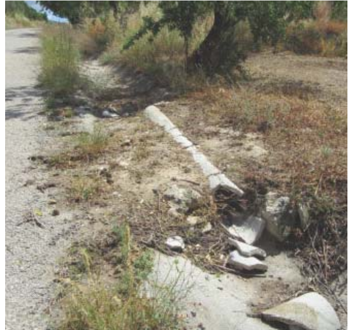
Ausencia de pasos salvacunetas y pasos defectuosos.
