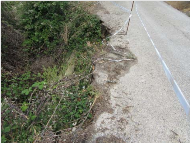
Desprendimiento de talud y cunetas erosionadas.
