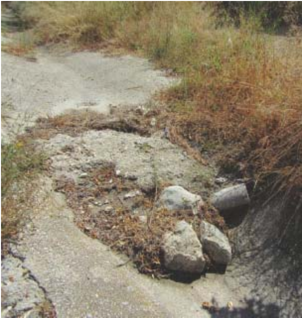
Ausencia de pasos salvacunetas y pasos defectuosos.
