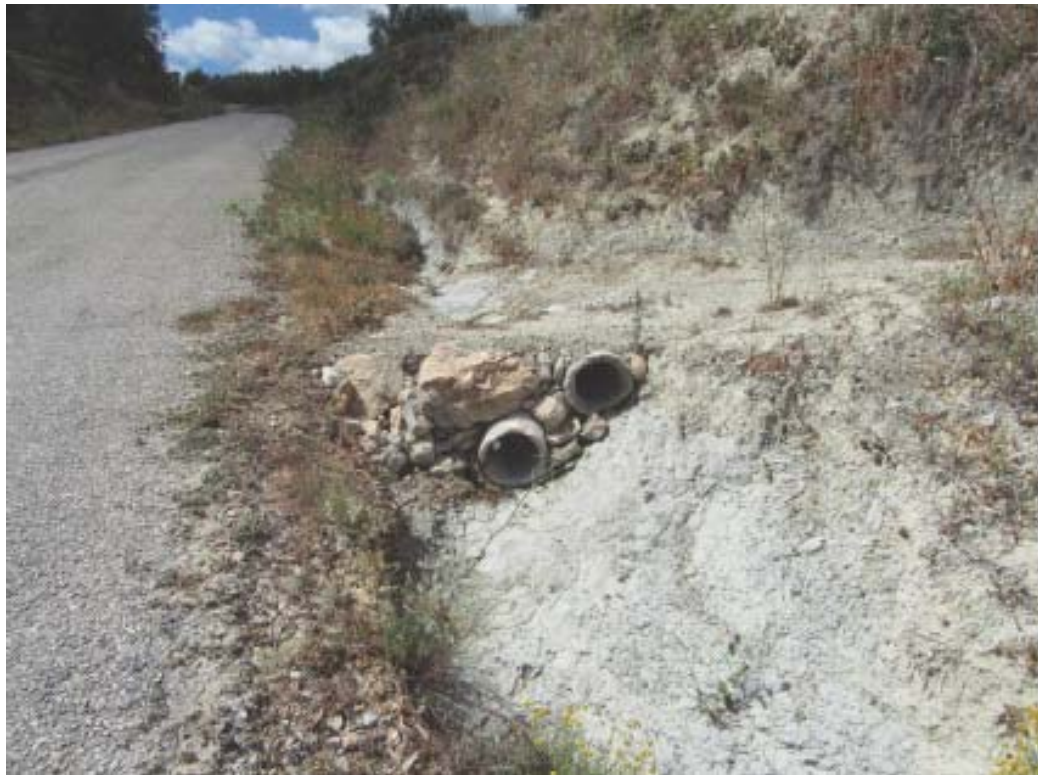
Foto 4 Estado actual paso salvacunetas
