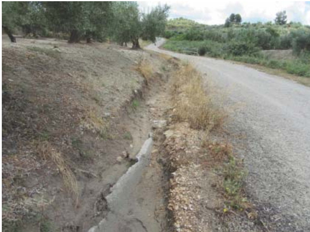
Foto 5 Estado actual cunetas
