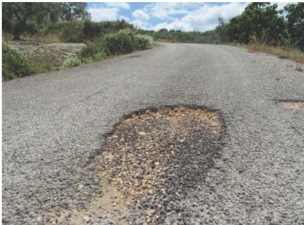
Foto 7 Estado actual pavimento
