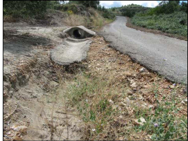
Desprendimiento de talud y cunetas erosionadas.
