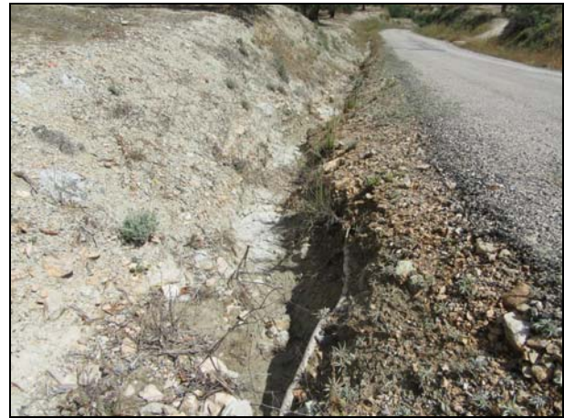
Pasos salvacunetas deteriorados y cunetas erosionadas.
