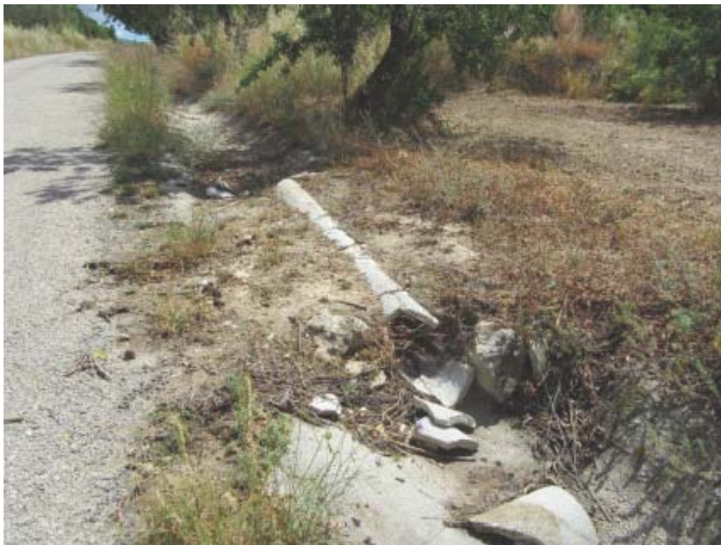
Foto 1 Estado actual paso salvacunetas
