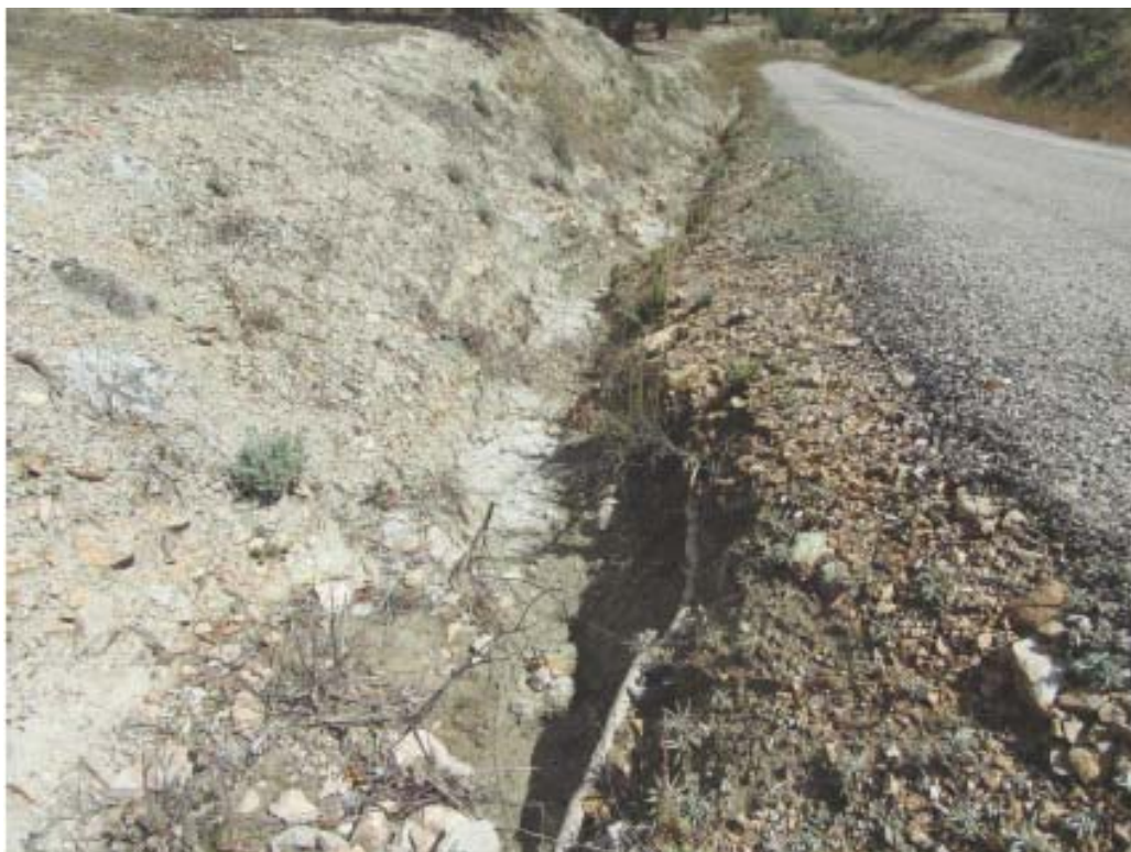
Foto 3 Estado actual cuneta
