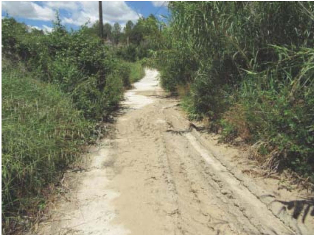
Foto 9 Estado actual camino
