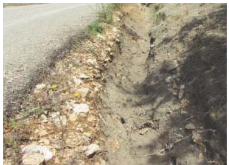
Cunetas erosionadas
