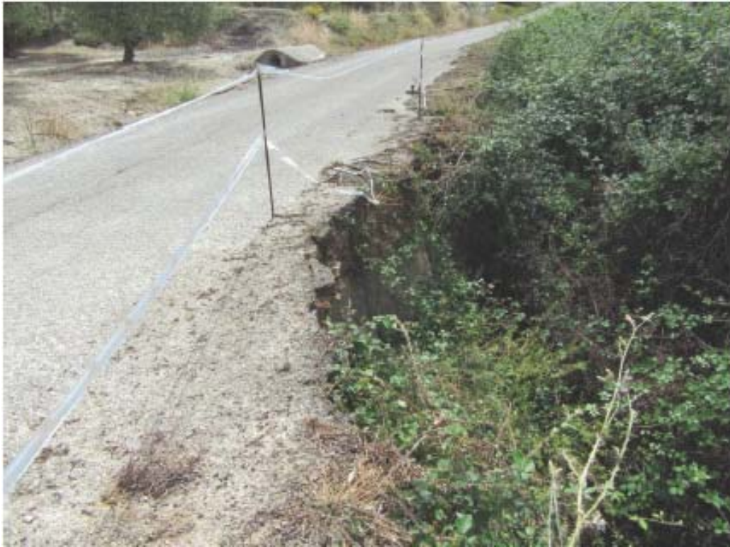
Foto 6 Estado actual talud camino
