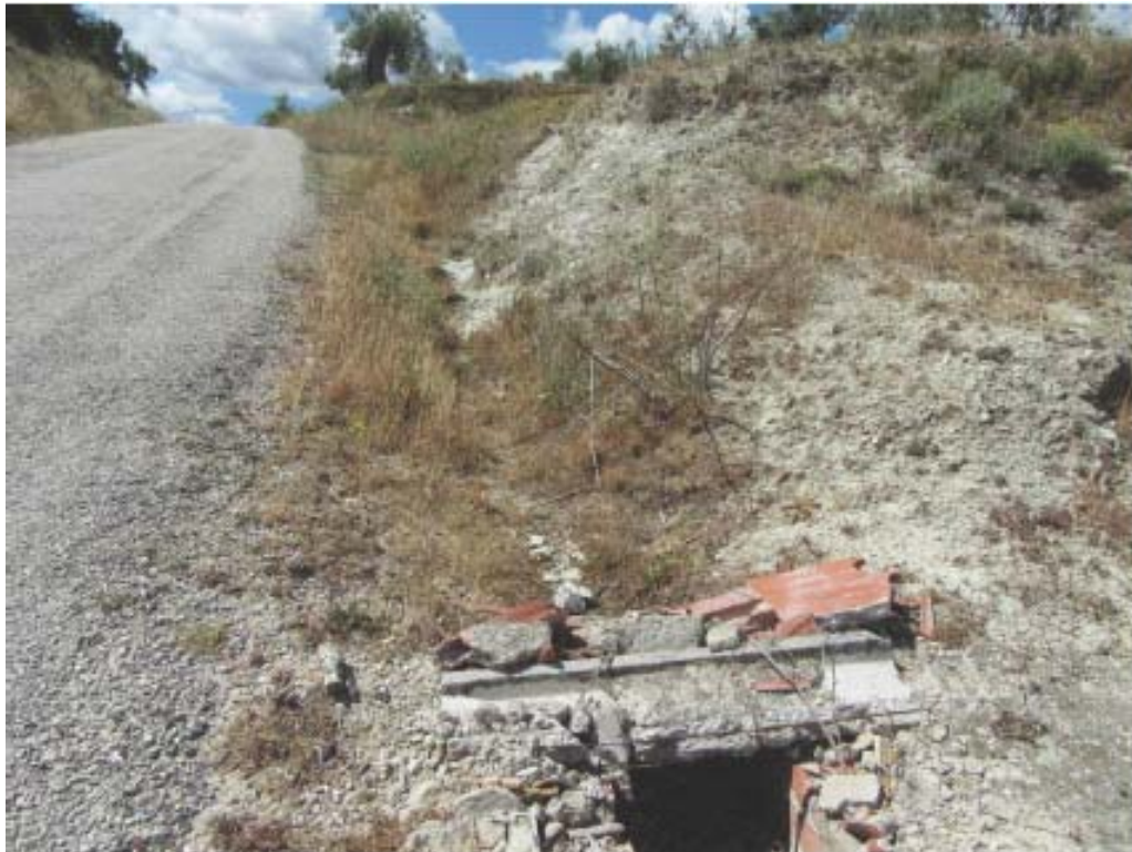
Foto 2 Estado actual cuneta y paso
