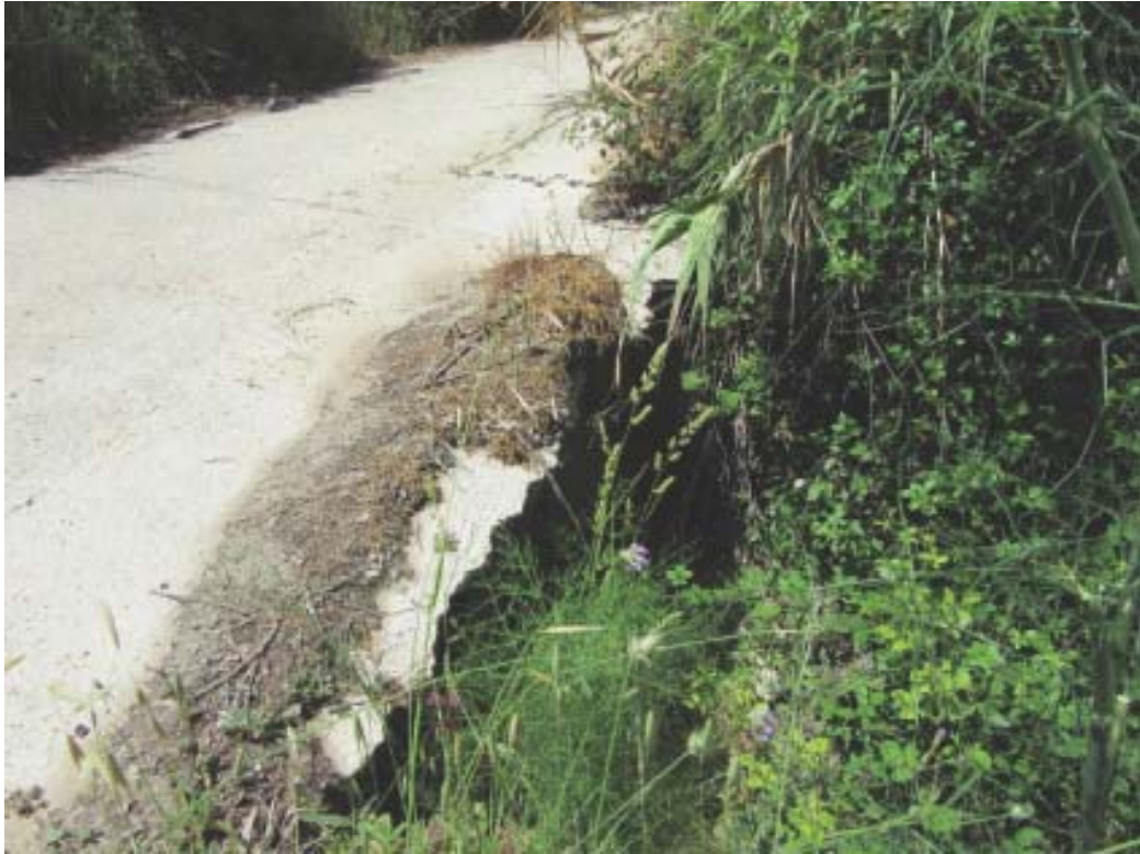
Foto 8 Estado actual socavón
