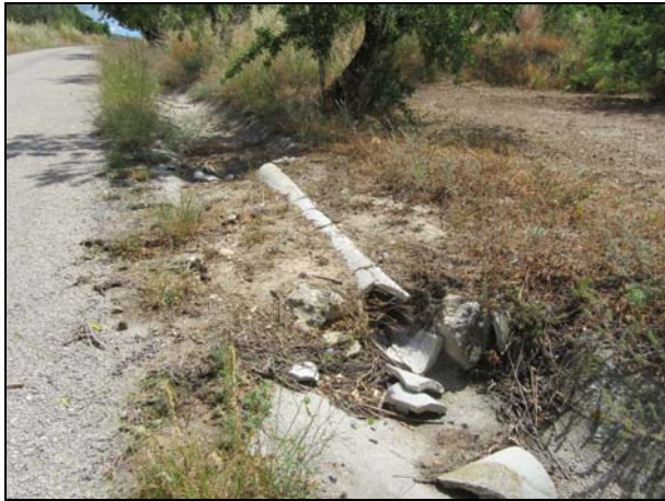
Pasos salvacunetas deteriorados y cunetas erosionadas.
