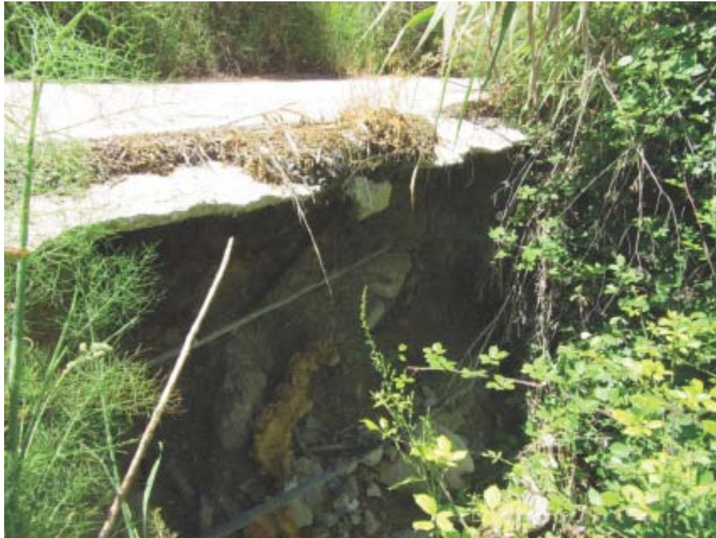
Foto 10 Detalle socavón bajo calzada
