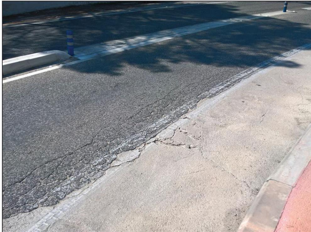
PK 3+640. Bacheo en límite de carril por existencia de media y desplazamiento de rodamiento de vehículos a zona de arcén y berma antigua.
