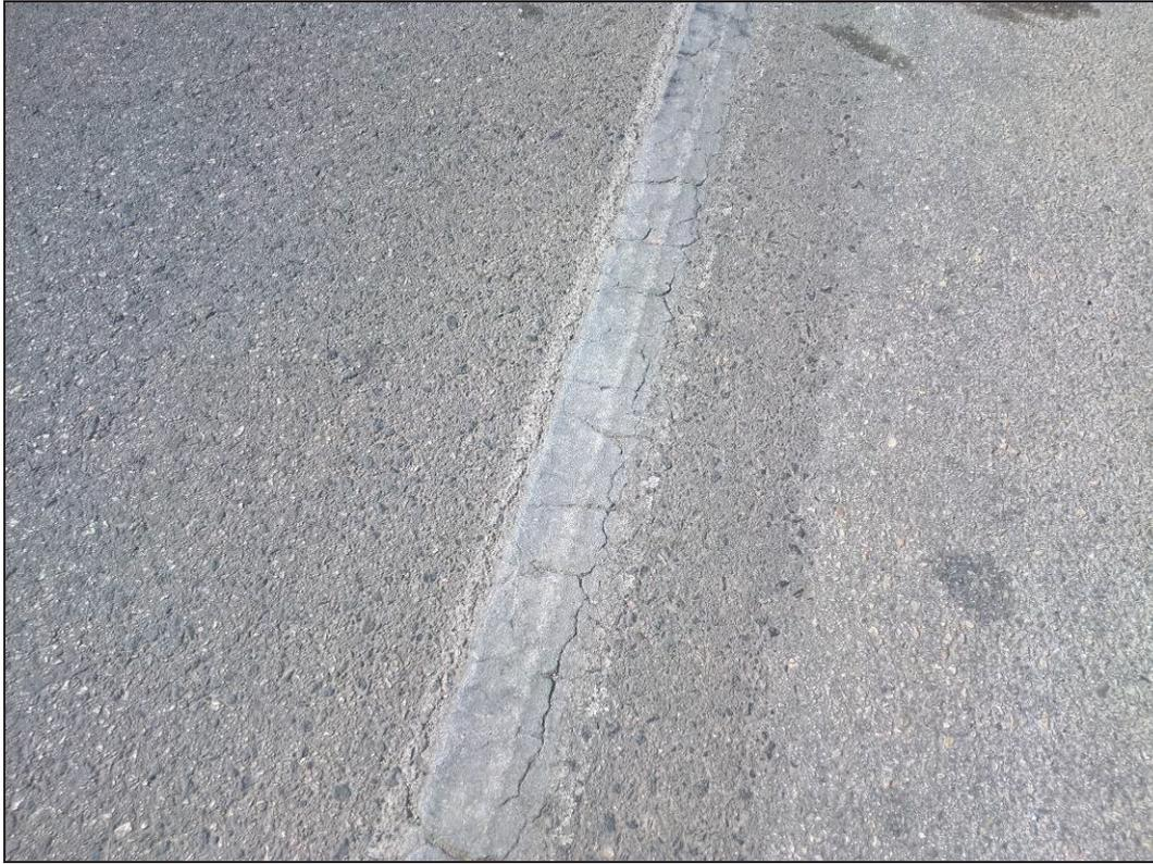
PK 0+950. Detalle del firme. Pulido de áridos, pérdida de finos y grietas longitudinales marcando la señalización longitudinal.
