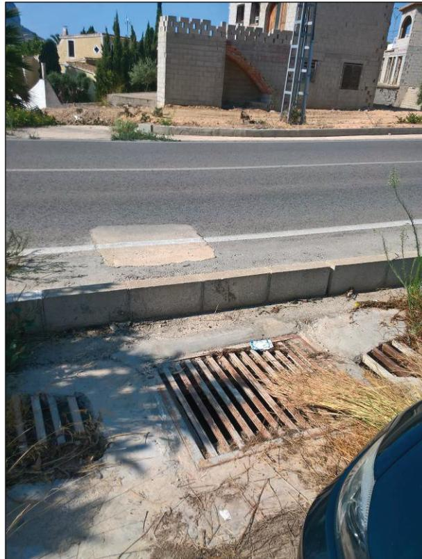
PK 1+555. Obra de drenaje transversal. Rejillas de captación en lado izquierdo y boquilla de vertido en lado derecho. Se aprecia vertido de residuales en el interior de la rejilla de captación por posible filtración de alcantarillado. Se hace inspección por parte de capataz independiente al presente proyecto.
