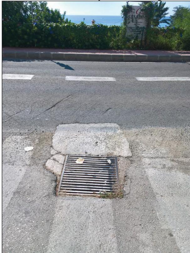
PK 1+685. Obra de drenaje transversal con rejilla en lado izquierdo y vertido con boquilla en lado derecho, tras la acera. En las cercanías, lado derecho, hay un imbornal conectado con ese pozo de captación.
