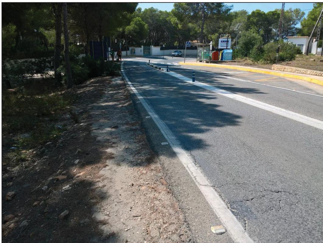
PK 3+735. Escalón lateral de límite de carril a berma en tierras. Necesidad de reconstrucción de berma para obtener una seguridad de circulación adecuada. Berma en hormigón.
