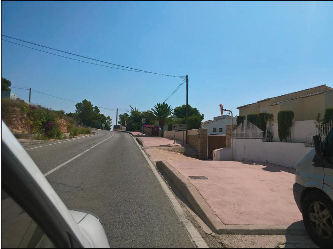
PK 2+900. Existencia de acera n lado derecho con entradas a fincas particulares. Particularidad de entradas a cota inferior por lo que el firme a colocar deberá realizarse en embocadura para minimizar el resalto o desnivel.
