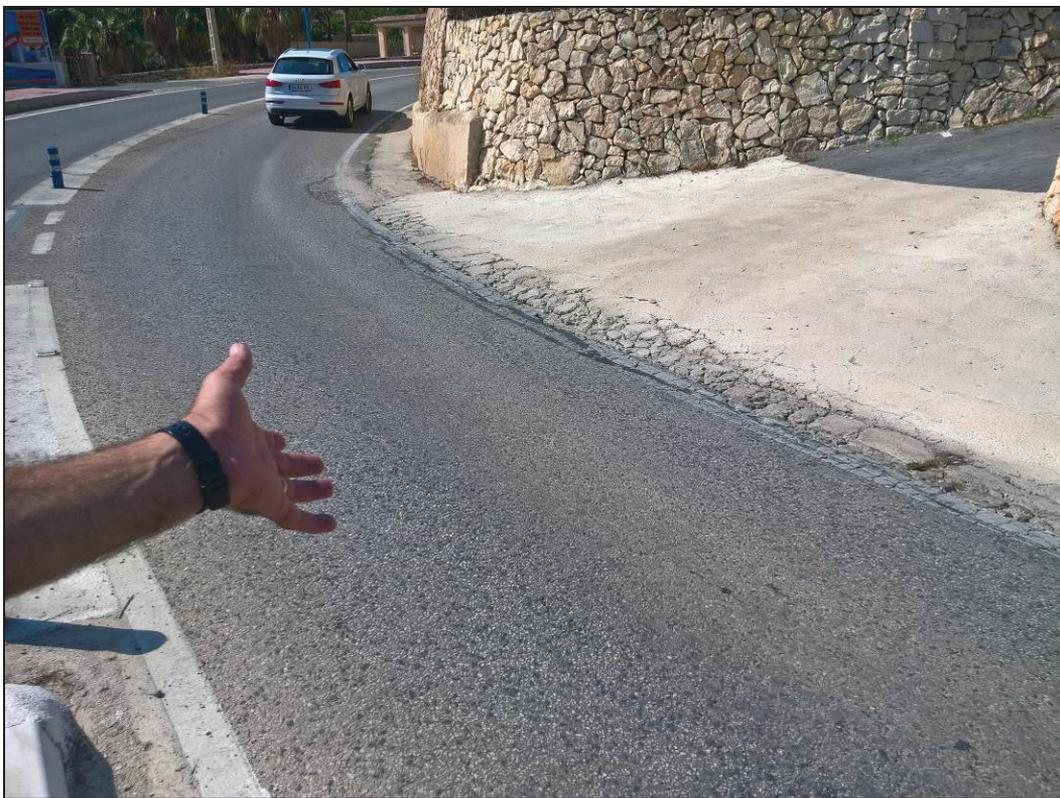
PK 2+520. Blandón producido en límite exterior de carril debido a la existencia de mediana que desplaza la rodadura de los vehículos hacia exterior donde el arcén y berma existente no poseen la base portante necesaria. Necesidad de bacheo completo con firme calizo G20 bajo rodadura.
