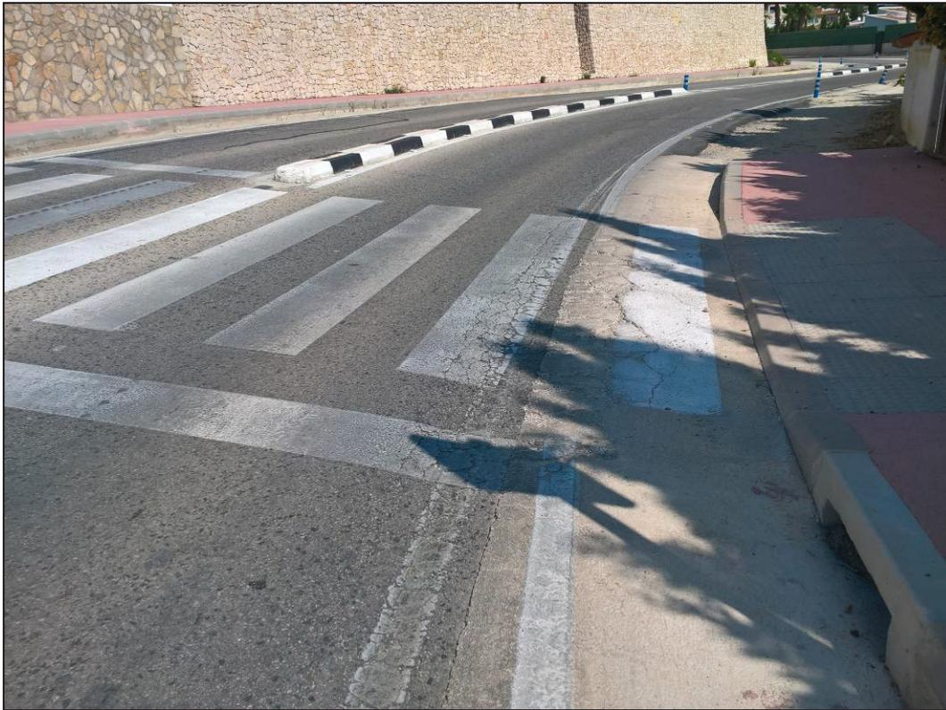
PK 3+170. Paso de peatones y ordenación mediante mediana. Existencia de blandón en exterior de calzada por ampliación de plataforma sobre arcén y berma a antigua. Necesidad de bacheo.
