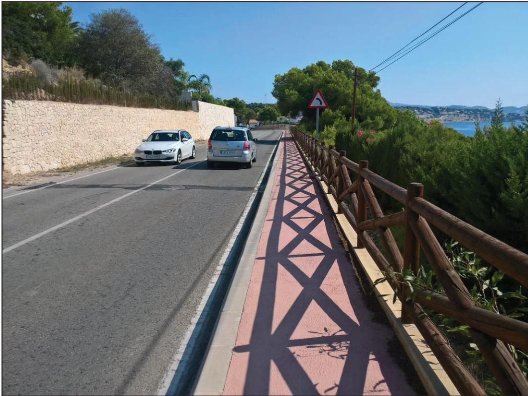
PK 1+940. Cruce de zanja de Iberdrola (hay otras tres más localizadas antes de llegar a este PK). Se observa la acera pavimentada en hormigón coloreado y valla madera de protección ante el desnivel.
