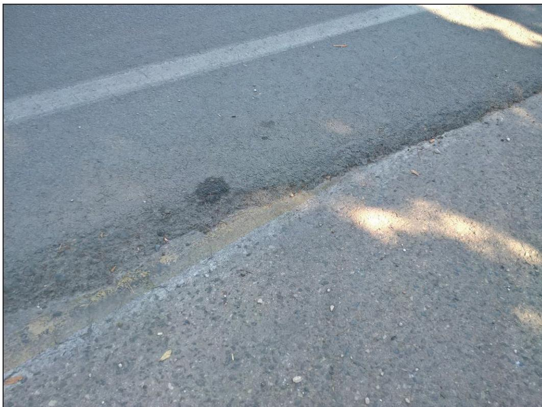
PK 0+150. Detalle de espesor de firme asfáltico de rodadura sobre capa asfáltica de base ya existente.
