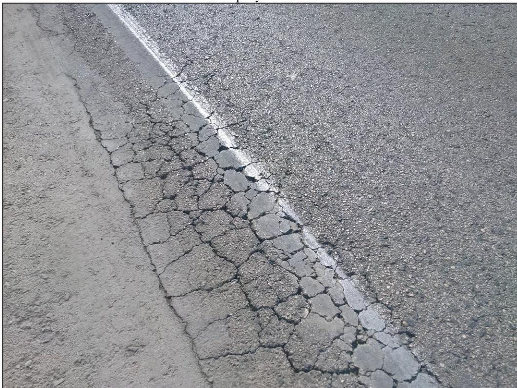
PK 1+580. Firme agrietado y cuarteado en acceso a espacio ordenado observado en fotografía previa, fuera del carril de rodadura pero necesario su bacheo.
