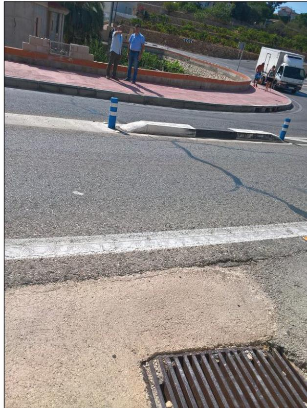
PK 2+445. Obra de fábrica transversal con rejilla de captación en lado izquierdo y boquilla de vertido a canal de pluviales en lado derecho y encauzamiento posterior a barranco que acaba en Cala Fuster.
