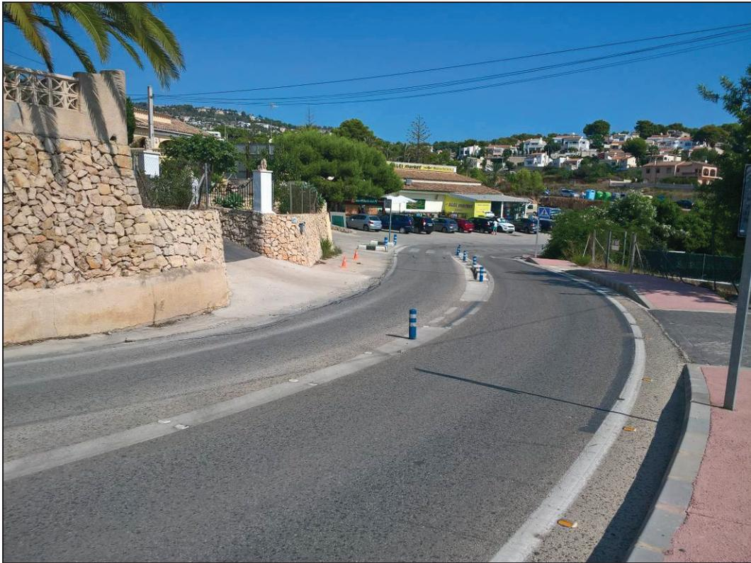
PK 2+510. Nueva actuación existente en mediana para ordenamiento de paso de peatones cercano. Captafaros en borde y mediana, señalización horizontal e hitos plásticos cilíndricos.
