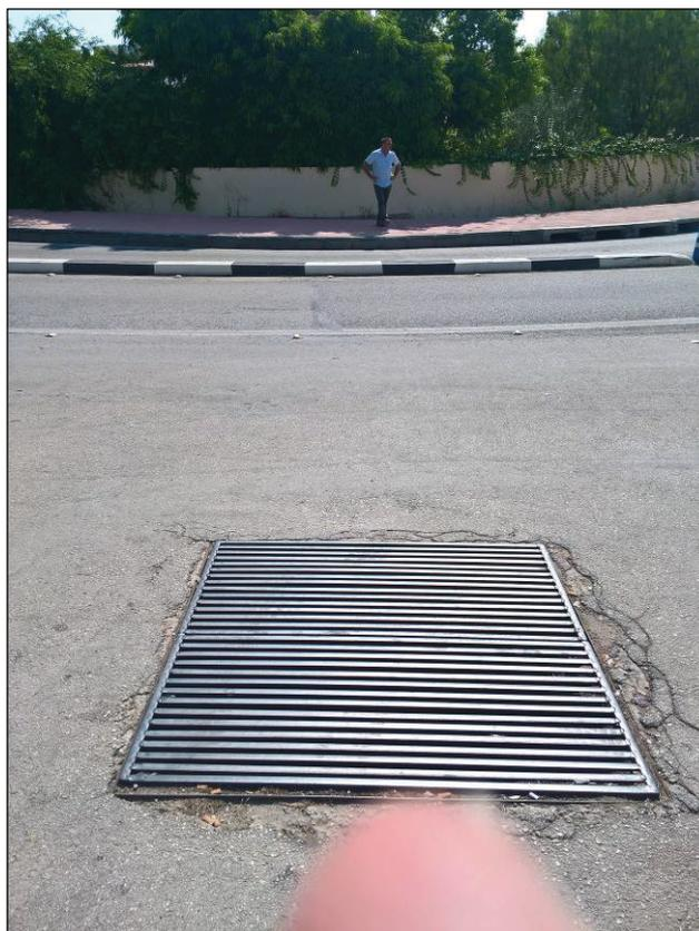
PK 2+565. Obra de drenaje transversal con rejilla en lado izquierdo y vertido sobre cuneta que canaliza hasta barranco que termina en Cala Fuster.
