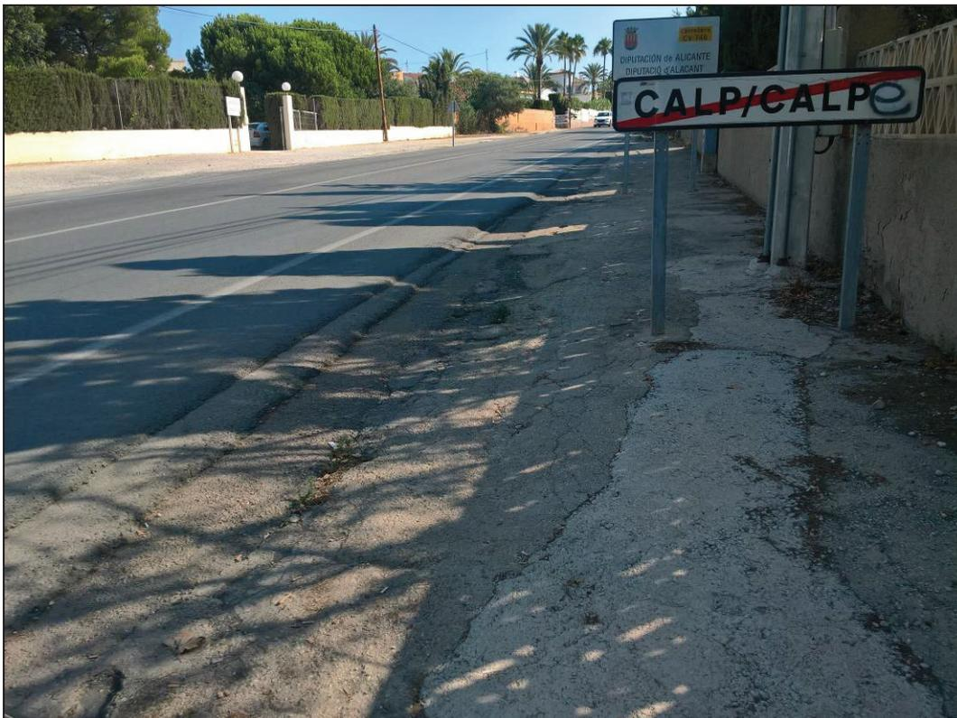
PK 0+100. Encauzamiento por superficie de escorrentía superficial de lluvias. Inexistencia de berma en tierras. Superficies pavimentadas en hormigón hasta valla límite de propiedades privadas.
