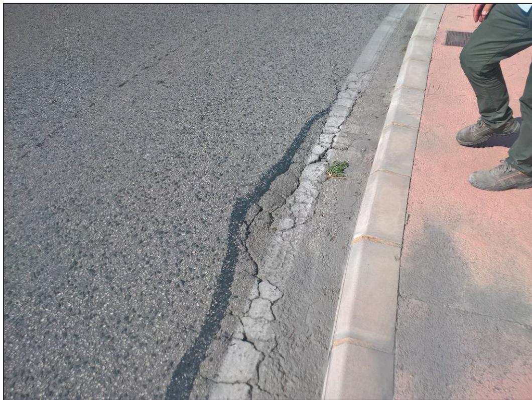
PK 1+620. Bacheo junto bordillo provocado por punto bajo en el trazado de la línea de borde de carril. Necesario cajeo y bacheo con G20 calizo. Se observa, en añadido, pulido de árido grueso y pérdida de finos.
