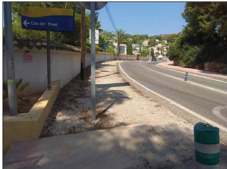
PK 3+600. Berma en tierras que se erosionan con la lluvia. Posibilidad de ejecución de berma en hormigón desde el PK 3+350 en el lado derecho.
