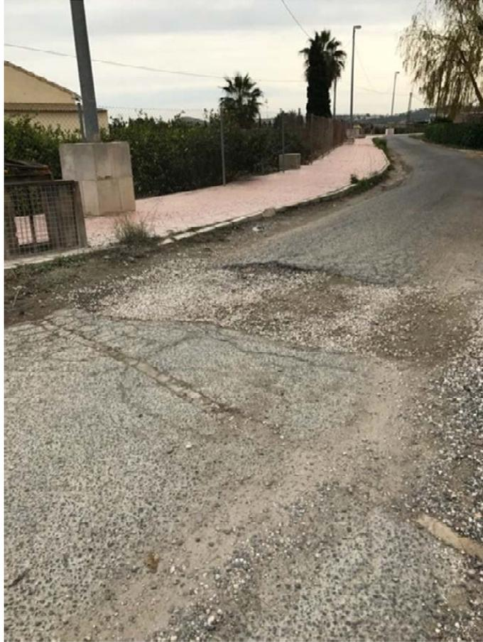
**Fotografía 3.**-Perdida de capa de rodadura en cruce de acequia por desborde de la misma por su aliviadero superior, punto de acumulación de aguas con colapso del encintado de bordillo y plataforma del vial.
