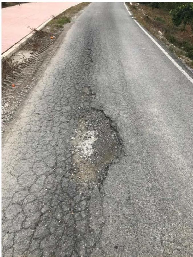
**Fotografía 2.-**Asiento longitudinal de la explanada junto al bordillo de la acera que alberga la ACEQUIA DE LA DAYA. La acumulación de aguas produce el colapso de la infraestructura.
