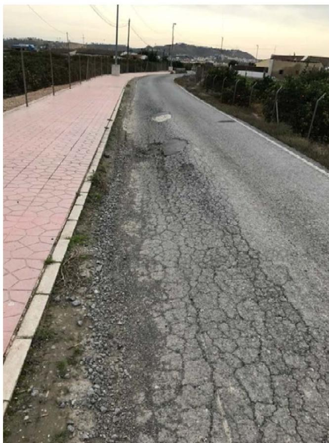
**Fotografía 4.**-Colapso de la infraestructura del vial junto al acerado, con cambio de peralte de la calzada.
