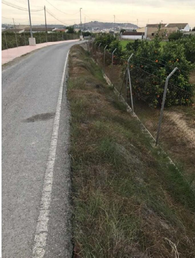
**Fotografía 5.**-Zona de vertidos de agua con la nueva actuación donde se pretende el cambio de pendiente transversal del vial para evitar acumulaciones junto al acerado, y permitir el correcto drenaje por los huertos aledaños.
