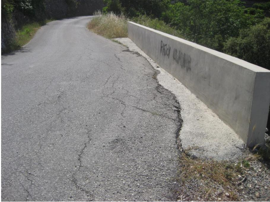
**Fotografía 6.** En la fotografía podemos ver las grietas que presenta la calzada en el asfalto como consecuencia del desplazamiento del firme por erosión del terreno sobre el que se apoya el murete de contención.
