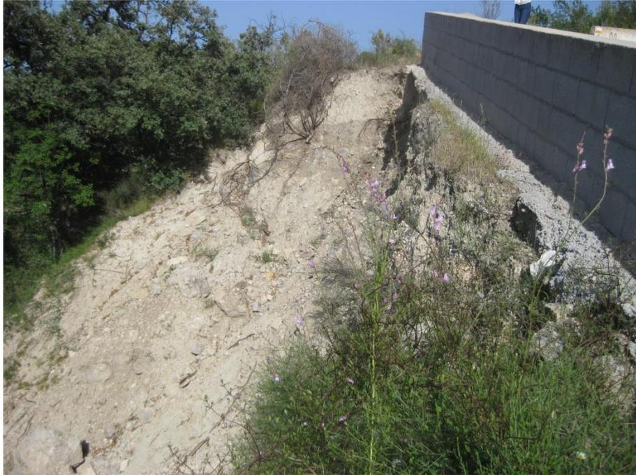
**Fotografía 4.** Deslizamiento del terreno debido a las lluvias. Se puede observar como parte de la zona del muro de fábrica de bloques se encuentra descalzado, sin apoyo. Se demolerá dicho muro y se realizará una excavación para poder ejecutar el muro de escollera de contención.
