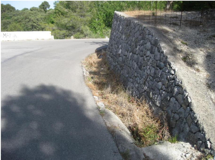
**Fotografía 2.** Estancamiento del agua por la escasa pendiente de la cuneta y la aparición de hierbas que han ido creciendo. Tubo de drenaje obstruido que permite el acceso a una parcela. Se demolerá dicho tubo y se implantará uno de mayor diámetro con la pendiente necesaria.
