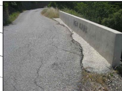
Fisuras en el asfalto debido la desprendimiento de las tierras y problemas de apoyo
