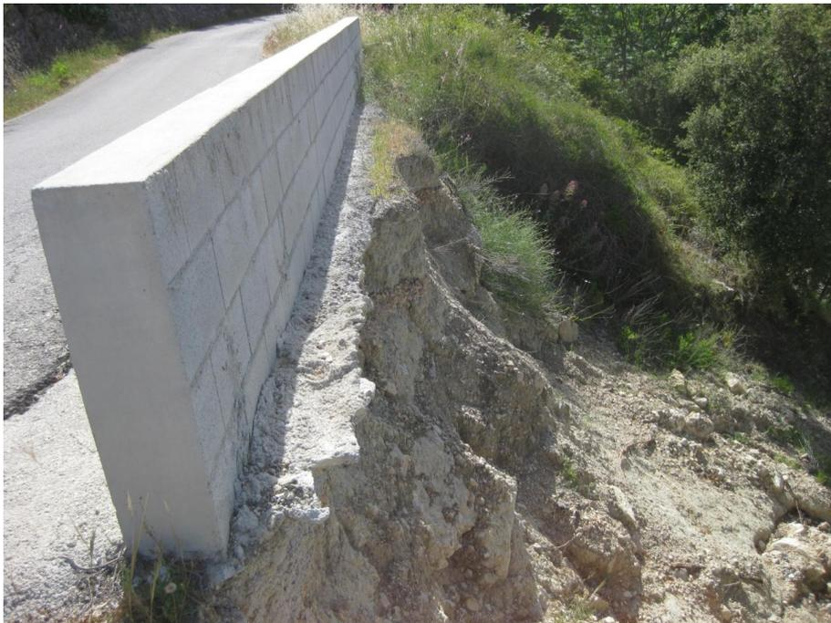
**Fotografía 5.** Vista del talud de carretera a reparar con muro de escollera.
