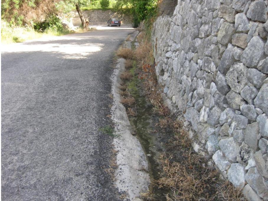
**Fotografía 3.** Tramo final de creación de nueva cuneta, se puede seguir observando la estanqueidad de las aguas. Las aguas han de verter al final de la calzada de la imagen y actualmente el tramo final de cuneta está más elevado que el tramo principal de la foto donde vemos agua en la cuneta.
