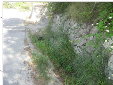
Obstrucción del tubo existente. Diámetro insuficiente.
