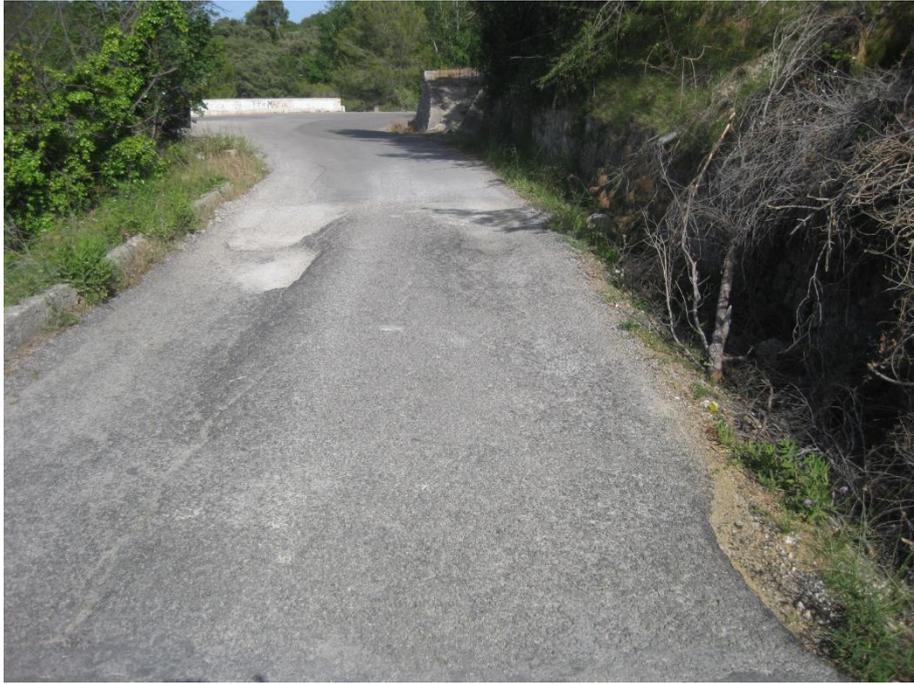
**Fotografía 1** Inicio de la intervención. Se puede observar el mal estado de la cuneta y del firme.
