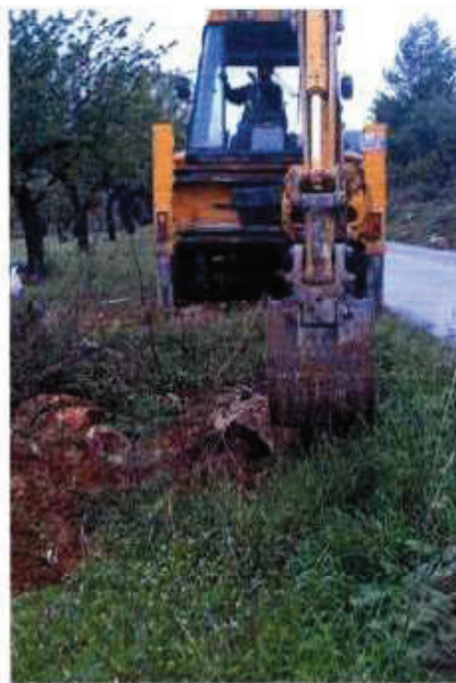
EJECUCIÓN DE LA CALICATA 2
