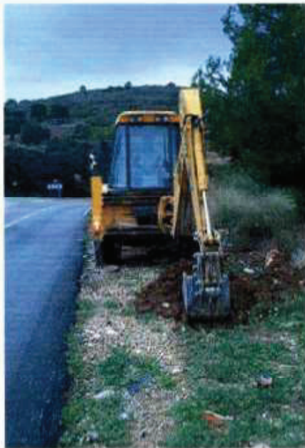
EJECUCIÓN DE LA CALICATA 1
