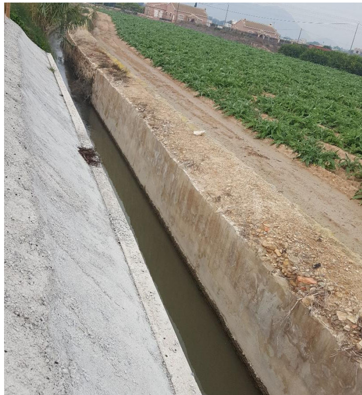
Figura 7. Vista general tramo de acequia rehabilitado para instalación caudalímetro en Acequia del Río
