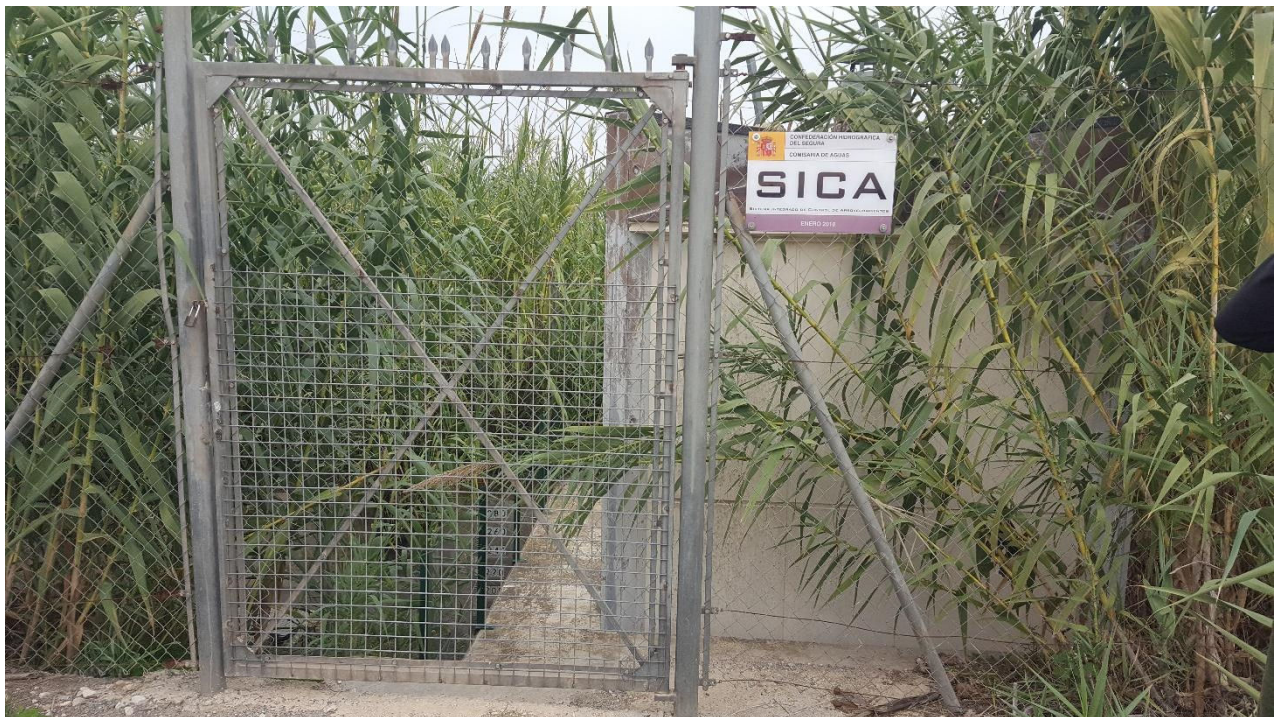
Figura 5. Vista general caudalímetro implantado actualmente en Acequia Mayor
