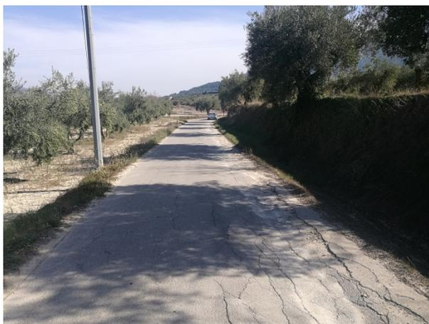
**Fotografía 5. Camí Corralet. Zona a demoler y repavimentar**
