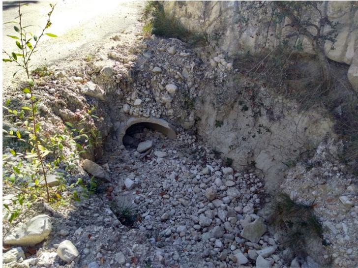
**Fotografía 6. Camí Font del Perelló. Tubo donde se ejecutarán aletas de hormigón**
