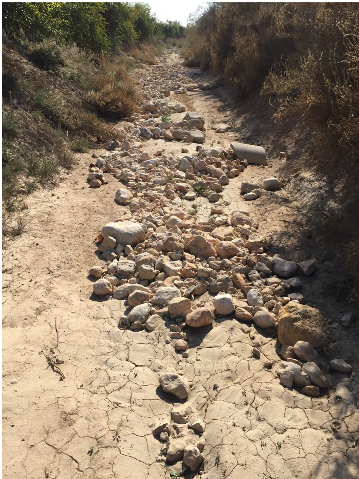
CAMINO ZANJONES. TRAMO II
