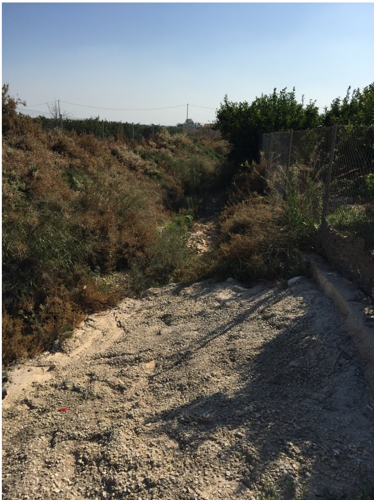
CAMINO ZANJONES. TRAMO I
