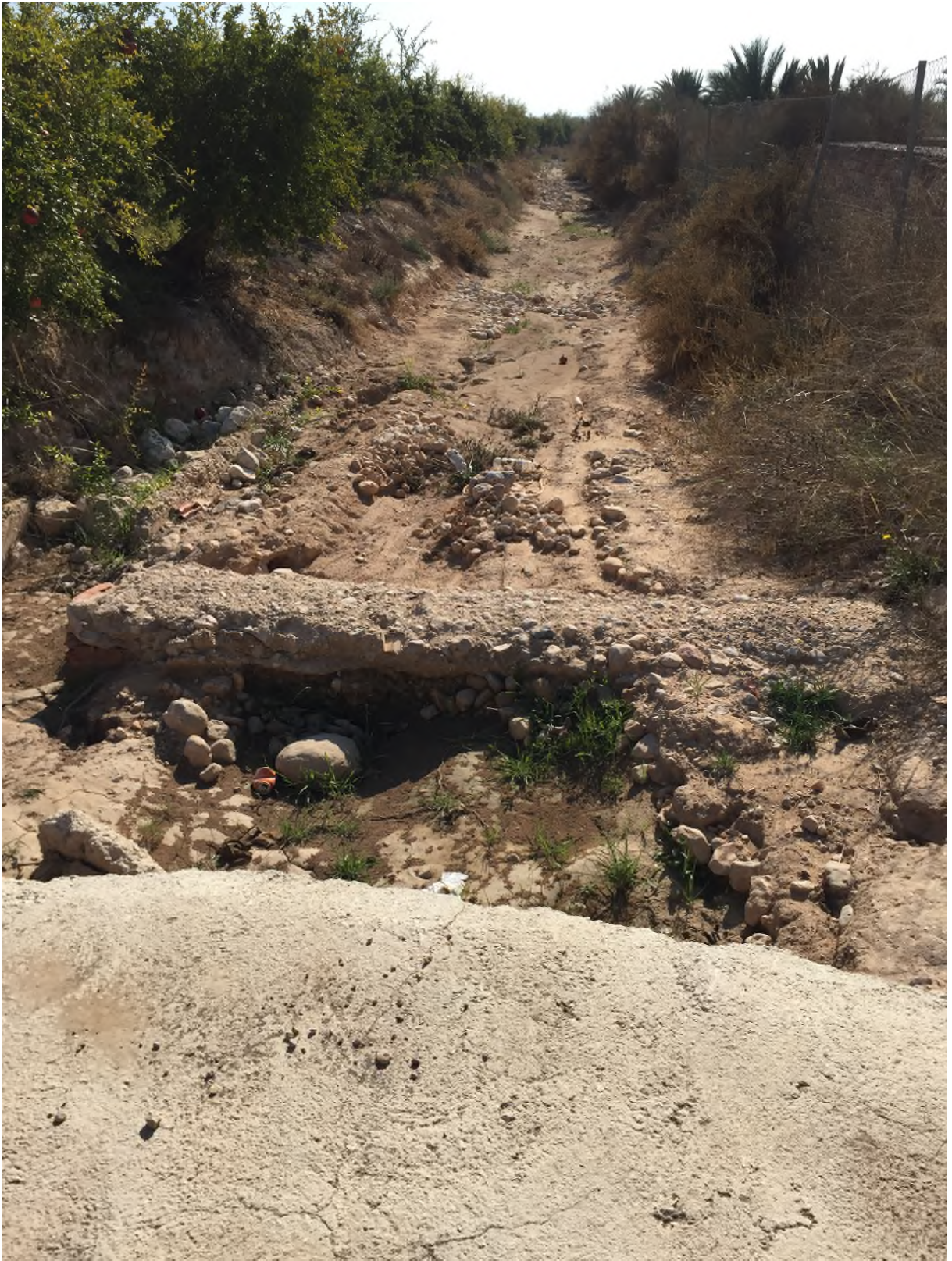
CAMINO ZANJONES. TRAMO II
