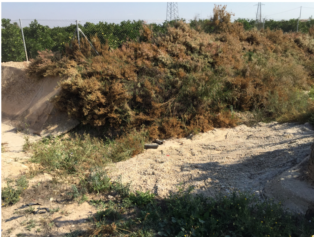
CAMINO ZANJONES. TRAMO I
