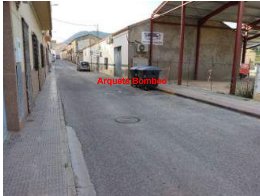
Arqueta bombeo existente
