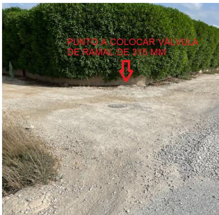
FOTOGRAFÍA N° 5: PUNTOS A COLOCAR VÁLVULAS EN RAMALES DE 315 MM QUE SE CONECTARÁN EN EL TRAMO A REPARAR.
