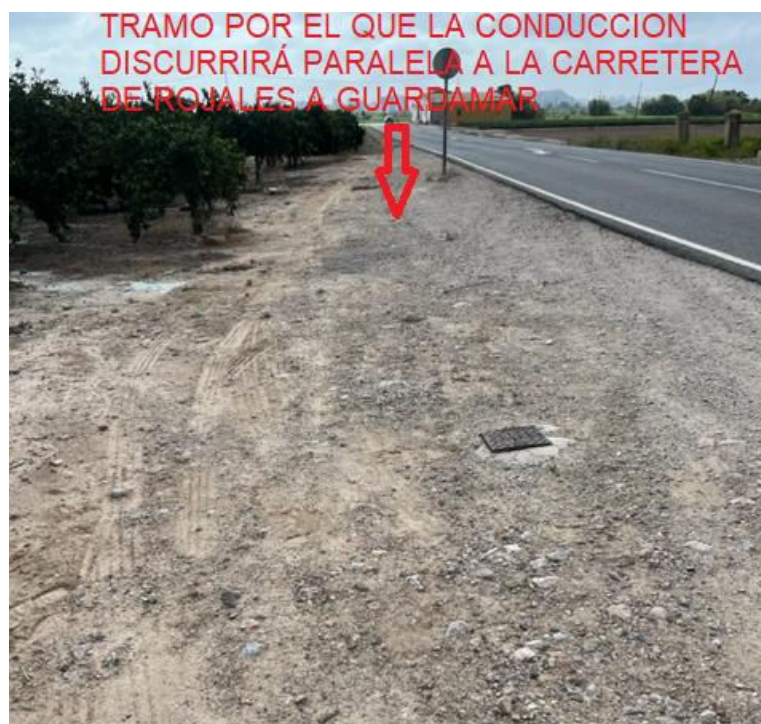
FOTOGRAFÍA Nº 2: TRAMO A COLOCAR EN PARALELO A LA CARRETERA DE ROJALES A GUARDAMAR DEL SEGURA
