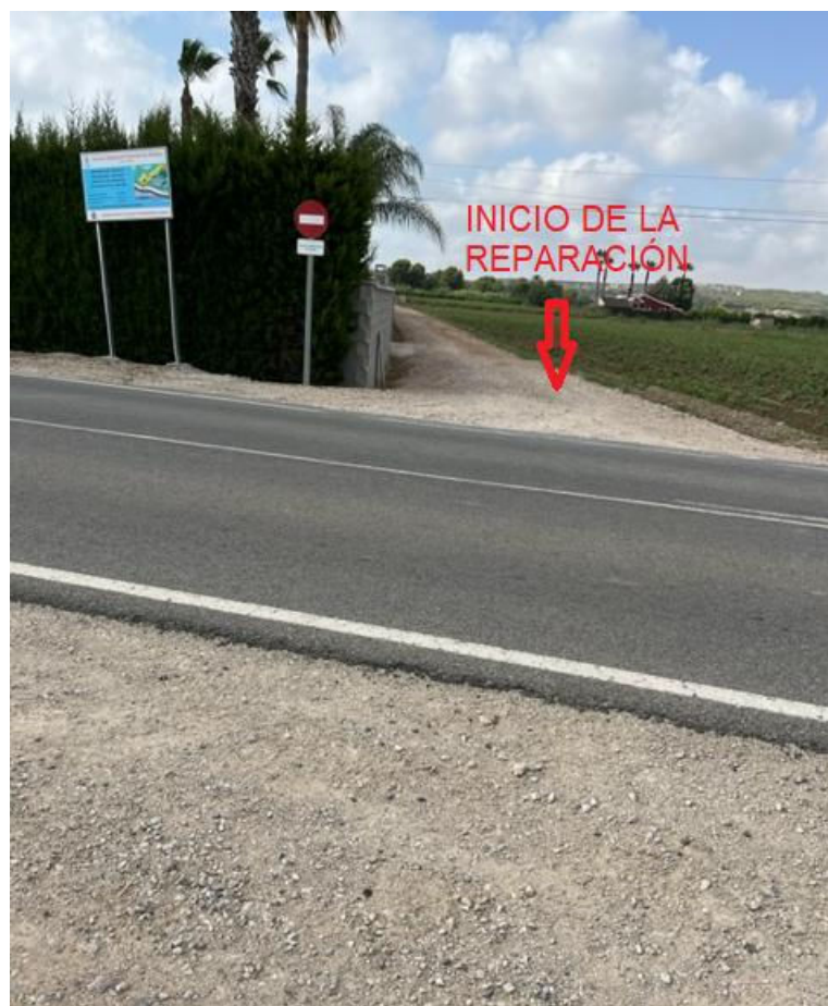
FOTOGRAFÍA Nº 1: PUNTO DE INICIO DE LA REPARACIÓN, EL CRUCE DE LA CARRETERA SE REALIZARÁ APROVECHANDO UNA HINCA EXISTENTE
