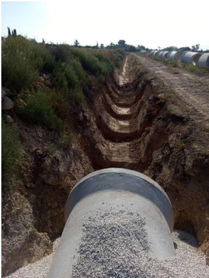
El caudal que conduce actualmente este canal oscila entre 250 - 300 l./seg. La tubería que se proyecta de 1000 de diámetro interior en homigón armado con junta elástica, con la pendiente del canal del 0,15% es capaz de conducir 928,58 l./seg a una velocidad de 1,18 m/seg.
