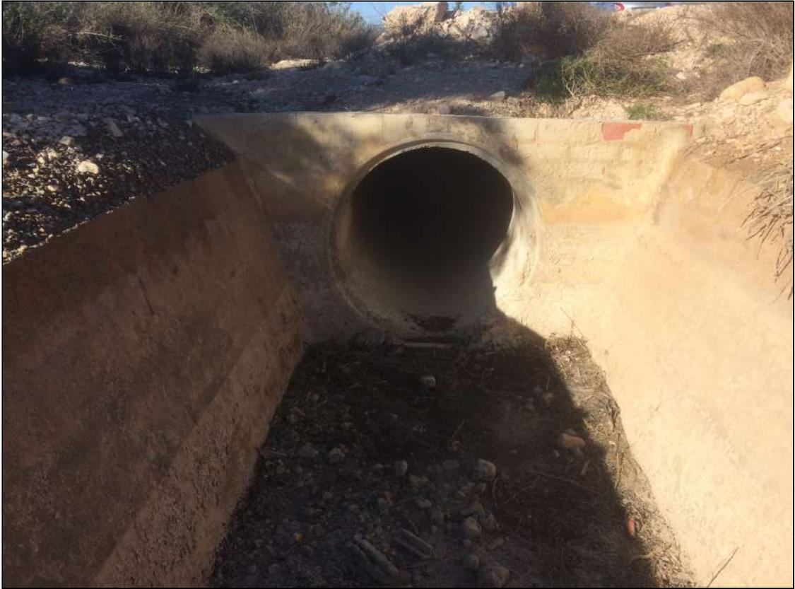
**Foto 3:** 2º Canal de Poniente - Conexión con tramo entubado
