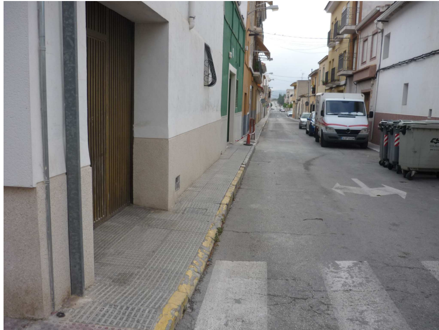
Acera izquierda de la avda Crevillente
