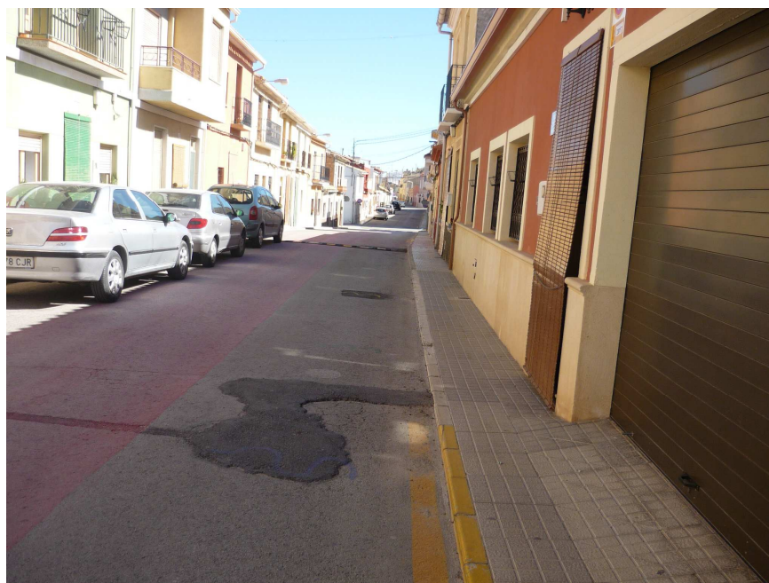
Rotura en calle Mayor
