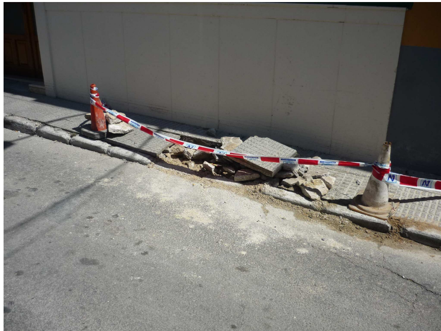
Rotura en avenida Crevillente
