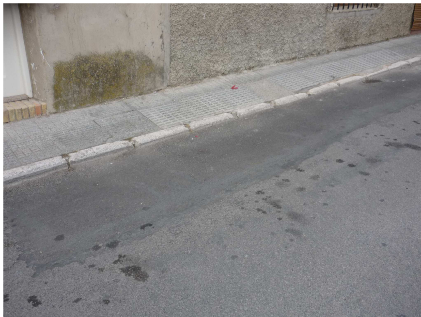
Rotura en avenida Crevillente
