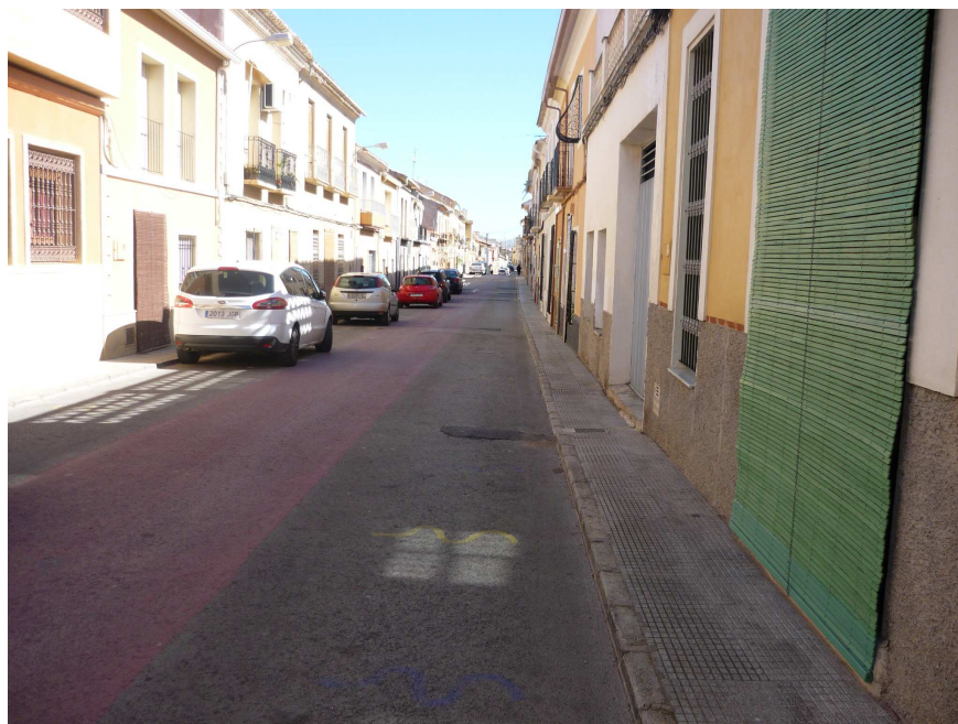
Rotura en calle Mayor
