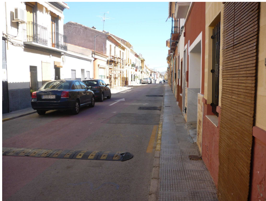
Rotura en calle Mayor
