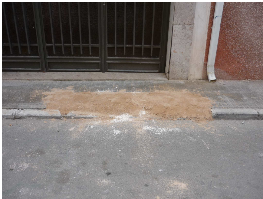
Rotura en avenida Crevillente
