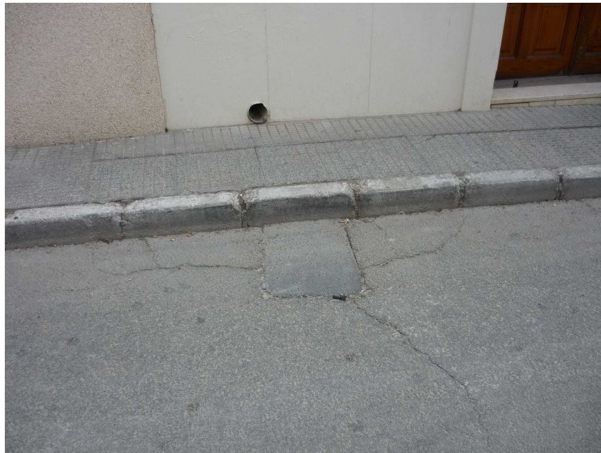
Rotura en avenida Crevillente
