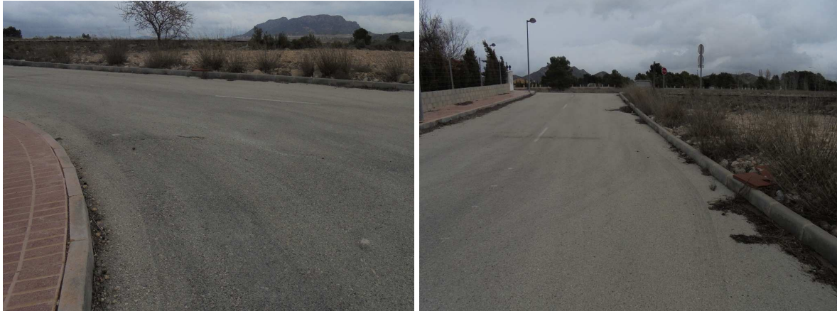
Imagen 5. Punto de entronque con red existente. Tramo inicial.
