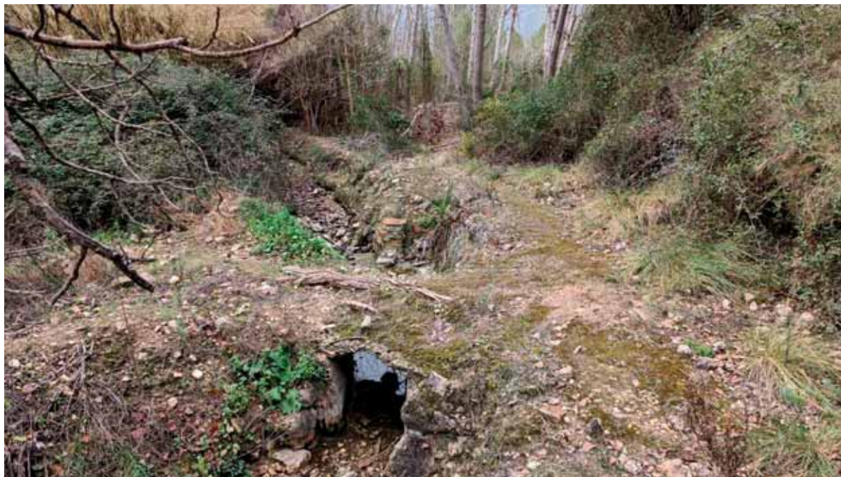
Foto 1: imagen de la acequia Deveses próxima al Barranco, a reconstruir la acequia.
