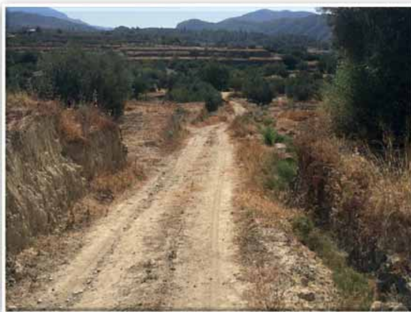
2.9.- Tramo camino existente. Perfil 73-76
