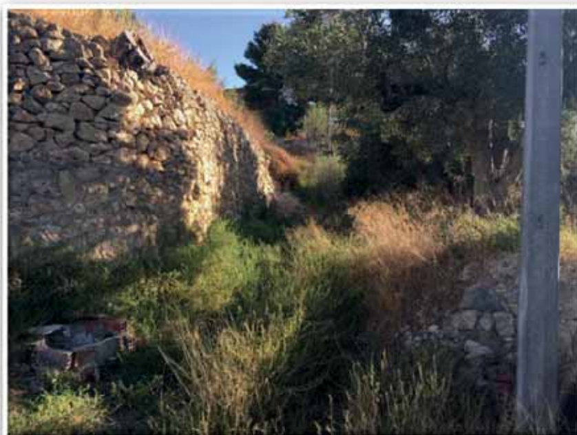
2.3.- Tramo apertura manual de zanja. Perfil 47-50
