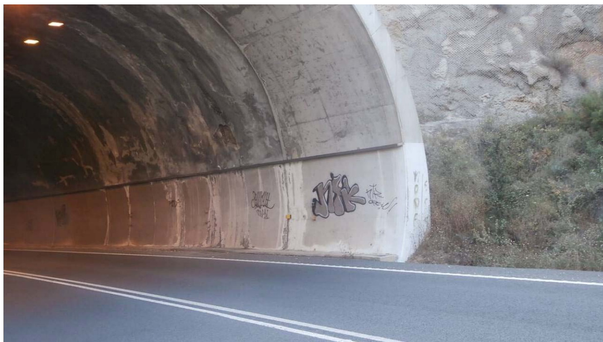
Foto nº 6.- Detalle del hastial izquierdo de la boca suroeste. Se observa que carece del balizamiento vertical indicado en la Norma 8.1-IC Señalización Vertical.
