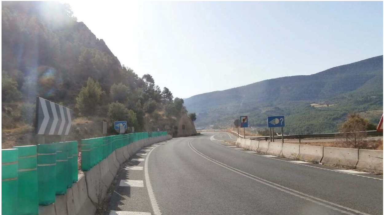
Foto nº 19.- Panorámica de la CV-795 hacia p.p.k.k. decrecientes, dirección Alcoi. Se puede observar, en la margen izquierda, la señal S-6, y en ambas márgenes la señal S-24. En la margen derecha se pueden observar diversos paneles direccionales.
