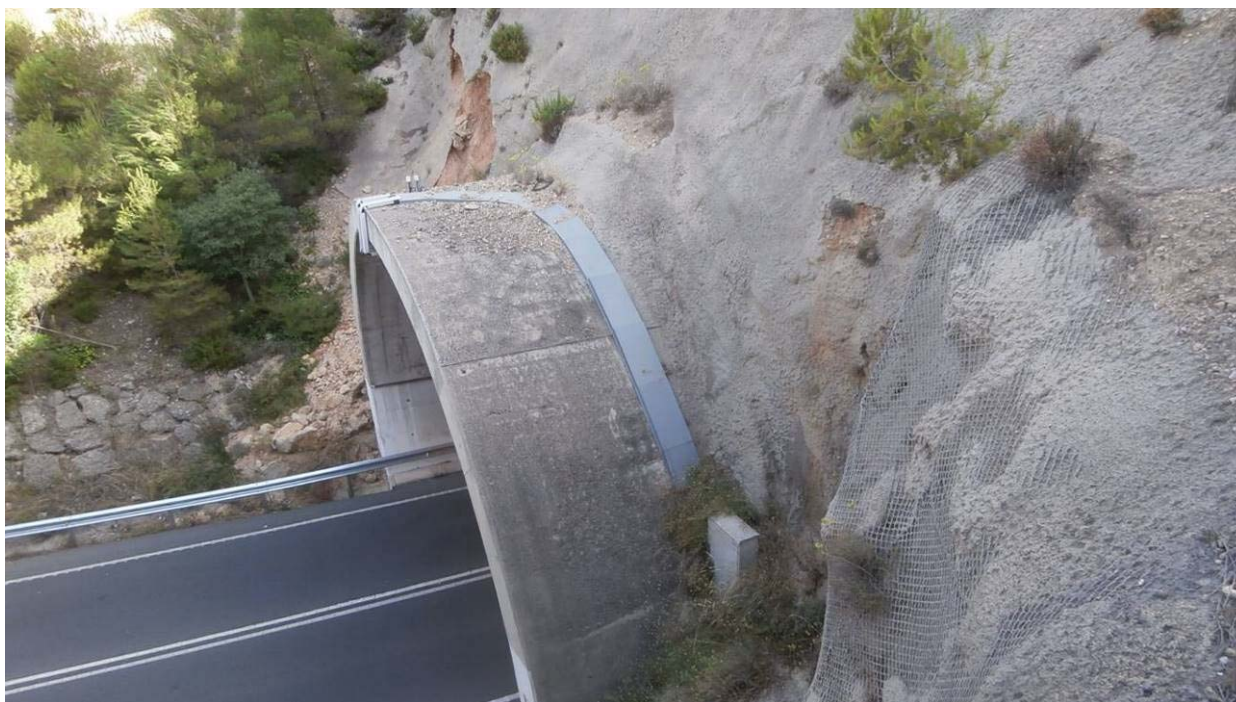
Foto nº 22.- Panorámica de la embocadura suroeste del Túnel del Salt. Se puede apreciar como entran las diferentes líneas eléctricas del alumbrado por la clave de la embocadura.
