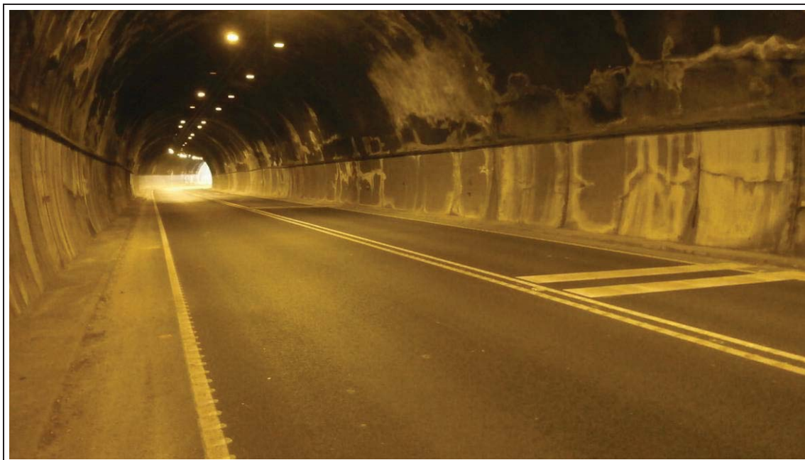
Foto nº 2: Panorámica del Túnel del Salt. Se puede apreciar la iluminación cenital, así como las efluorescencias en los hastiales de hormigón y en el gunitado de la bóveda. Fuente propia.
