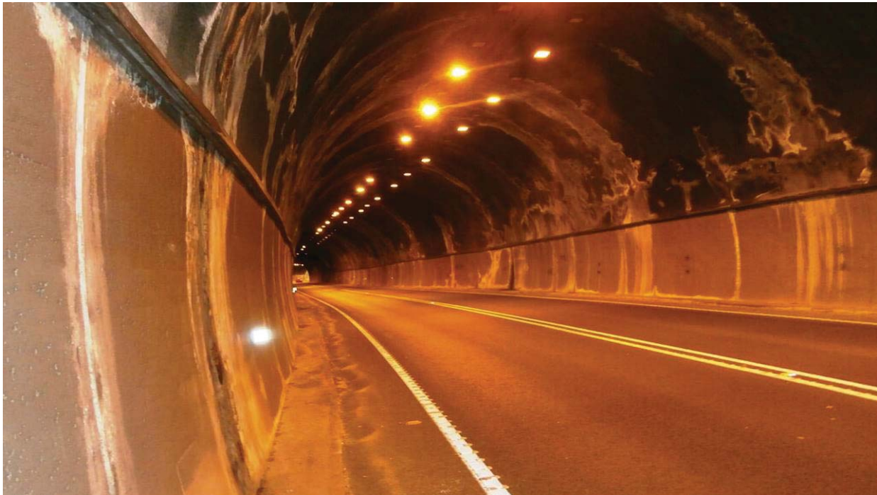
Foto nº 11.- Otro detalle del interior del Túnel del Salt. En este caso se puede apreciar también que la doble línea continua del eje presenta resaltos. También se aprecia el revestimiento rígido de los hastiales y el gunitado de la bóveda.
