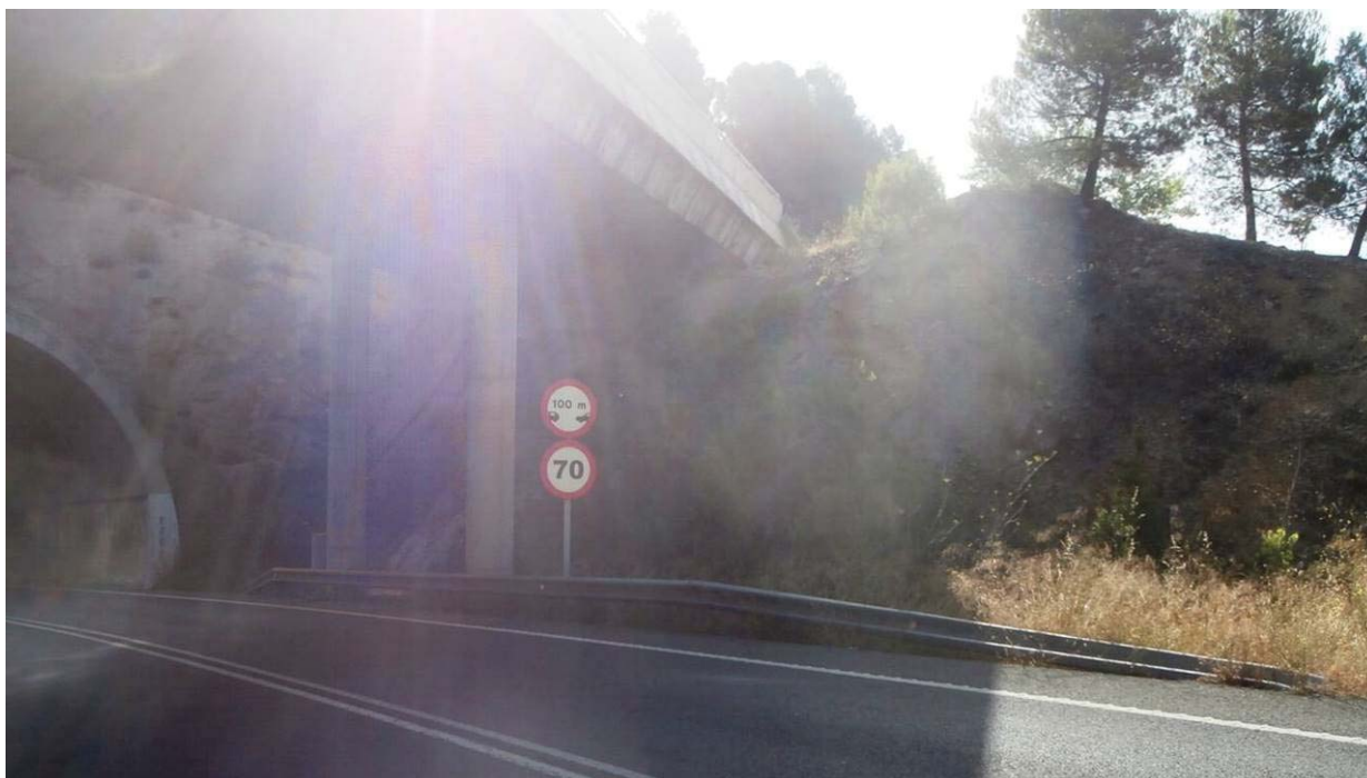
Foto nº 5.- Detalle de las señales R-300 y R-301(70) situadas en la margen izquierda. También se observa que la barrera de seguridad que protege las pilas del paso superior presenta un abatimiento corto, una vez sobrepasado el obstáculo, pero no protege de un posible impacto contra el hastial de la embocadura.
