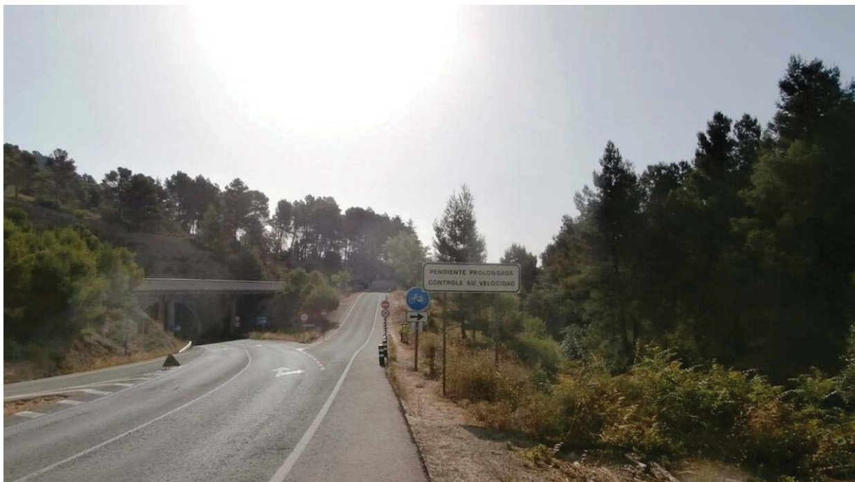
Foto nº 2.- Otra panorámica de la CV-795 hacia p.p.k.k. decrecientes, dirección Alcoi. Se puede observar al fondo la boca suroeste del túnel. También se observa un cartel indicando un tramo de pendiente pronunciada que debería cambiarse por la señal P-16a.
