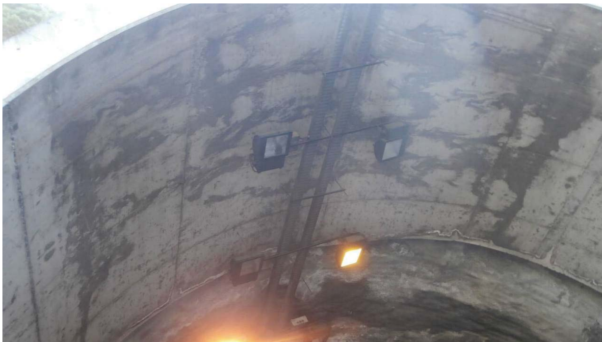
Foto nº 10.- Detalle de la instalación de alumbrado cenital del Túnel del Salt. Se pueden observar también las canaletas en las que se alojan los cables de la instalación eléctrica.
