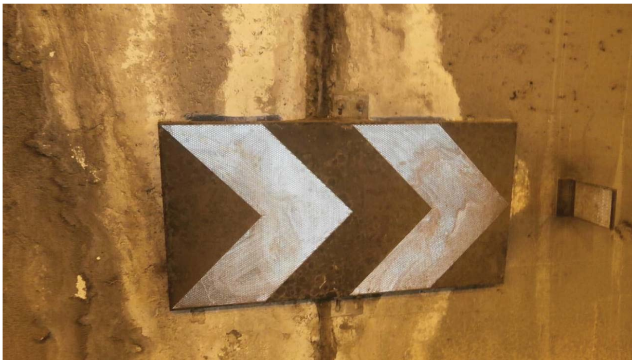
Foto nº 15.- Detalle de uno de los paneles direccionales colocados en el hastial derecho del Túnel del Salt. Se observa que ha perdido su eficacia debido a la suciedad.
