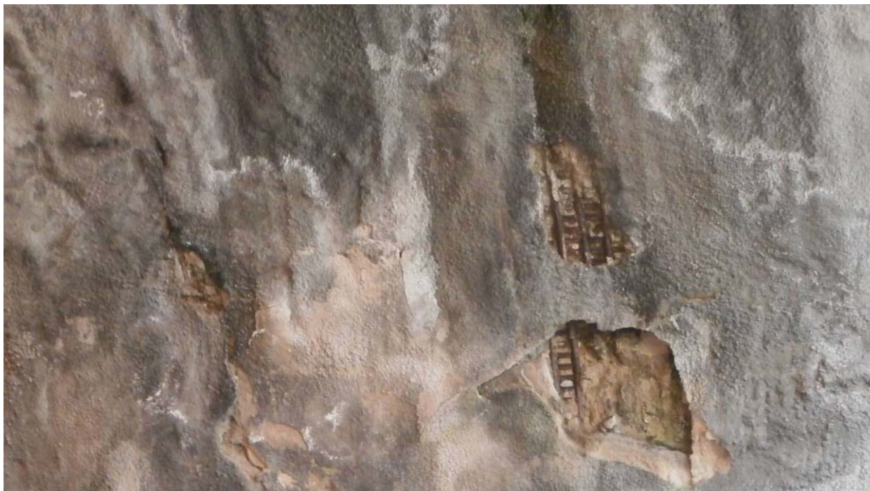
Foto nº 9.- Detalle de algunos desprendimientos del revestimiento de gunita que dejan al descubierto las cerchas de sostenimiento.
