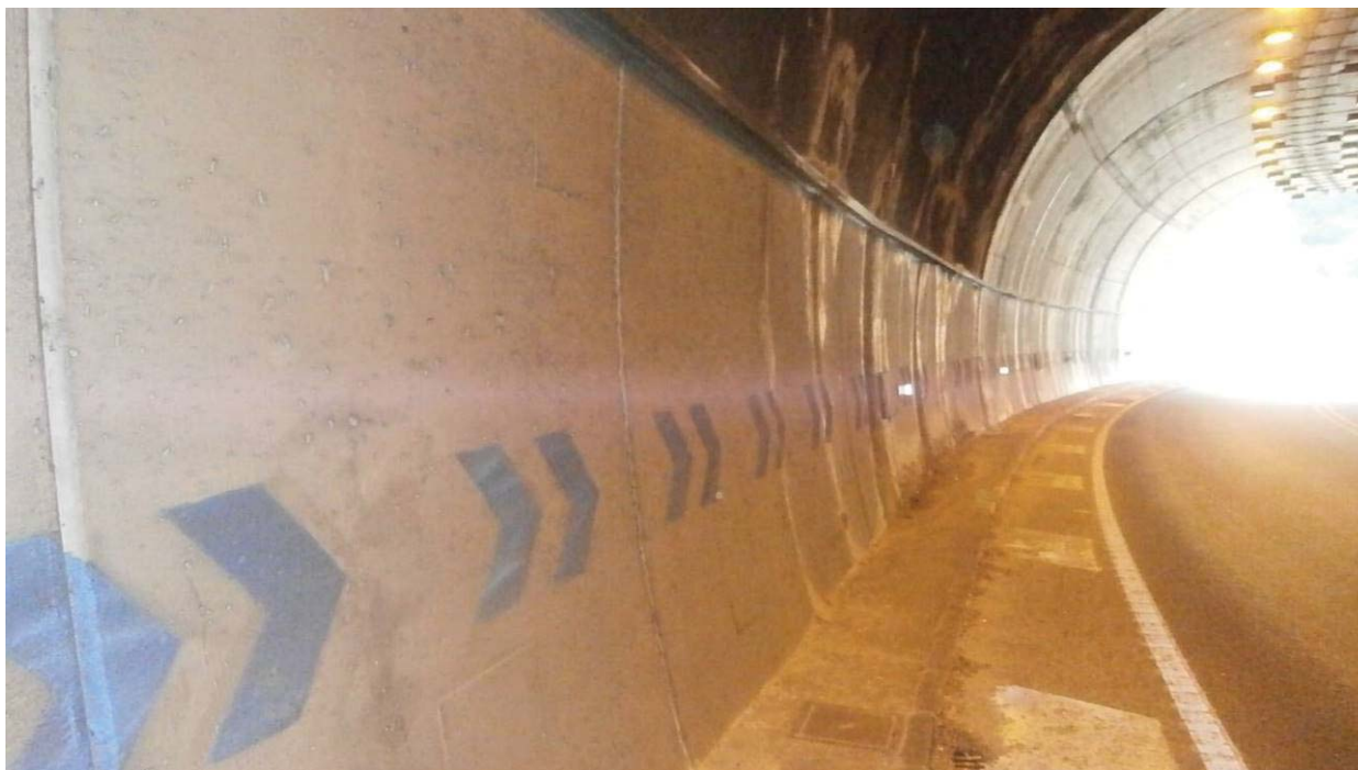
Foto nº 14.- Panorámica de los paneles direccionales pintados en el hastial derecho del Túnel del Salt, a lo largo de la alineación curva próxima a la boca este. También se observa una gran intensidad lumínica debido a la orientación este que presenta esta boca.
