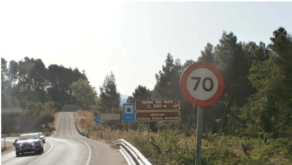
Foto nº 1.- Panorámica de la CV-795 hacia p.p.k.k. decrecientes, dirección Alcoi. Se puede observar la señalización de la margen izquierda que advierte a los usuarios de la proximidad del túnel, en concreto señal R-301(70), cartel S-520 y señal S-5.
