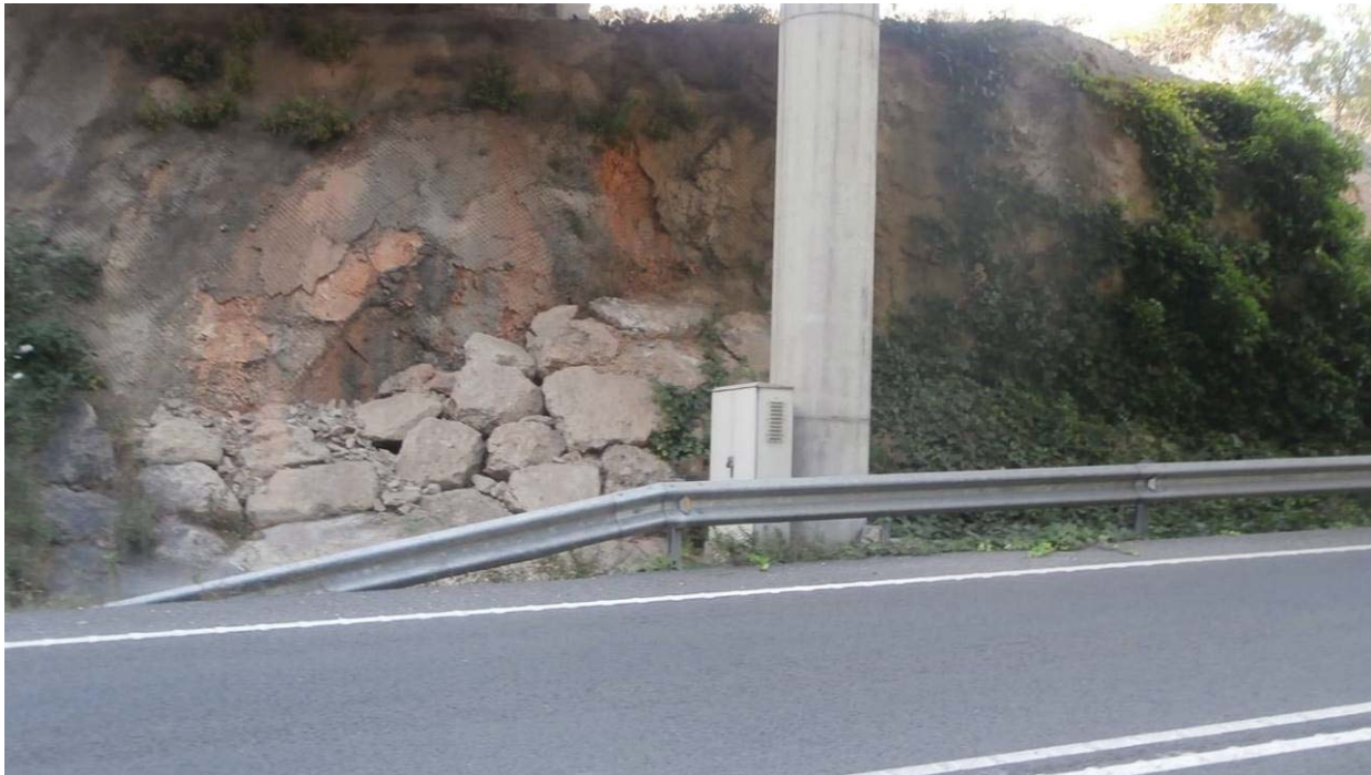
Foto nº 7.- Detalle del armario en el que se alojan las diferentes protecciones de los circuitos eléctricos del alumbrado del túnel.
