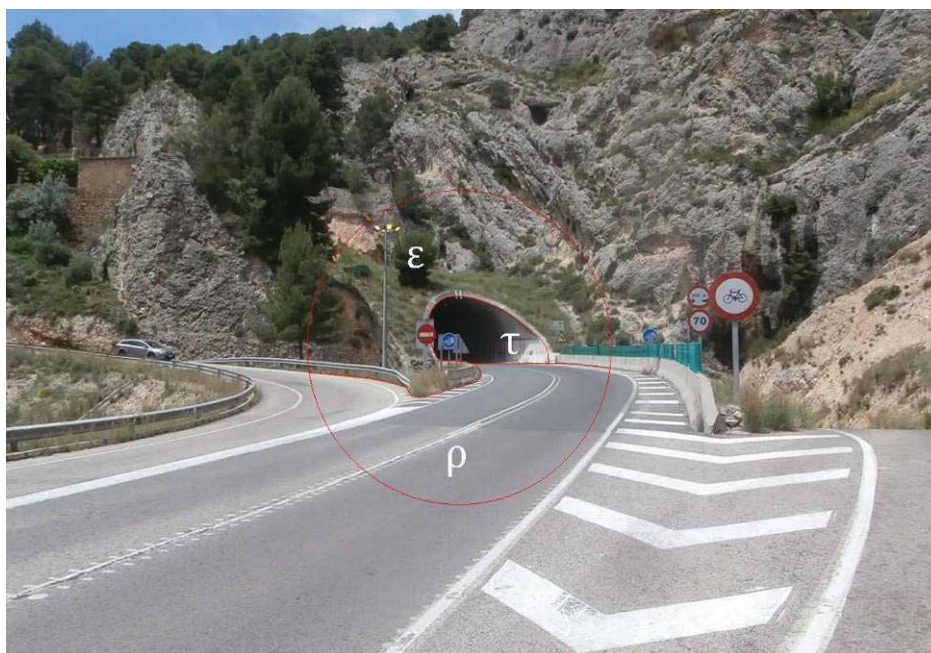
IMAGEN Nº 2.- Vista de la entrada este del Túnel del Salt con el círculo correspondiente al ángulo de visión de 20°.
